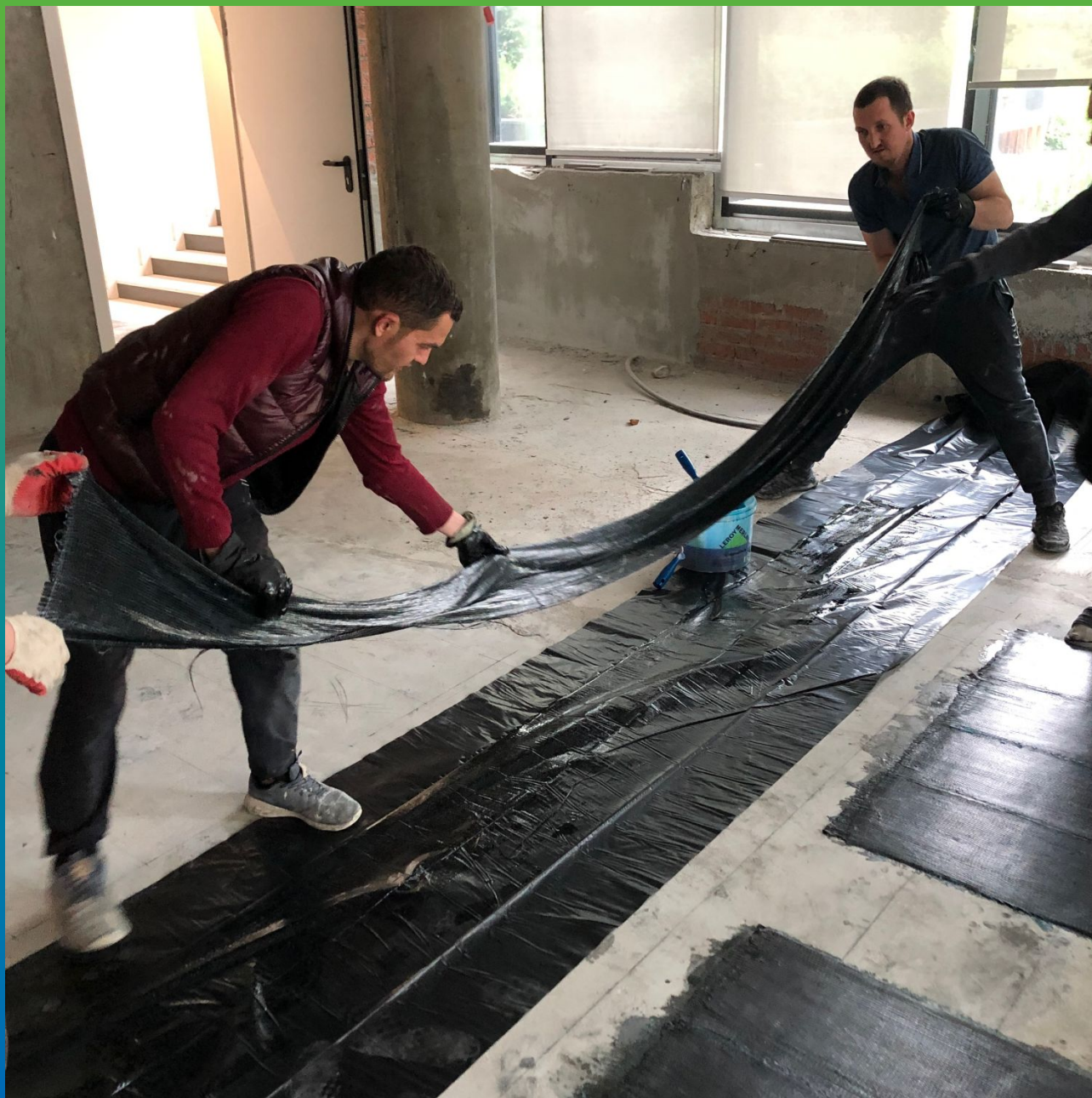
Процесс пропитки углеродных холстов полимерной композицией Манопокс 372
