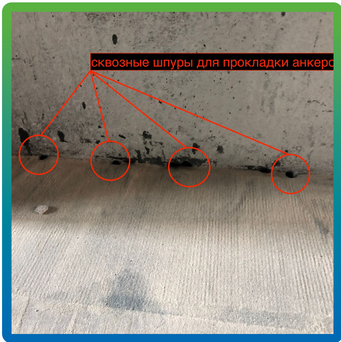
Бурение и подготовка шпуров для прокладки композиционных анкеров по тех решению
