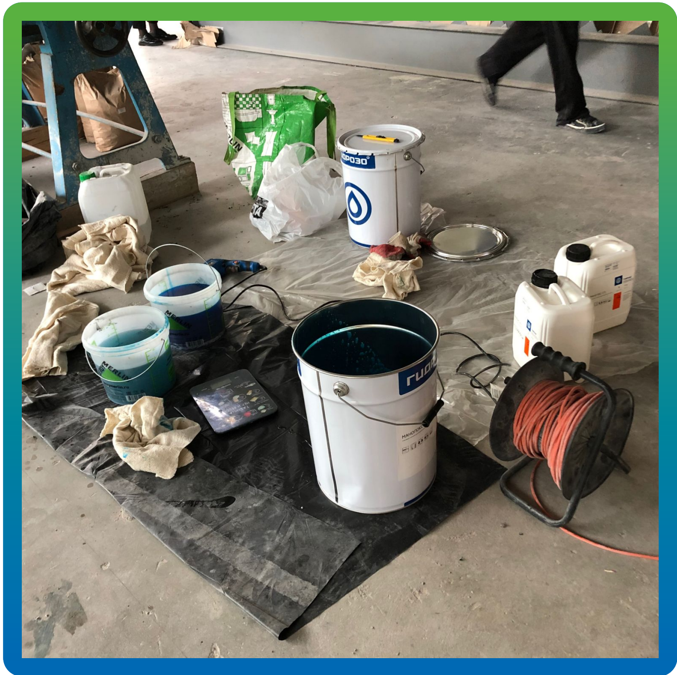
Подготовка полимерной смолы Манопокс 372. Проверка оборудования
