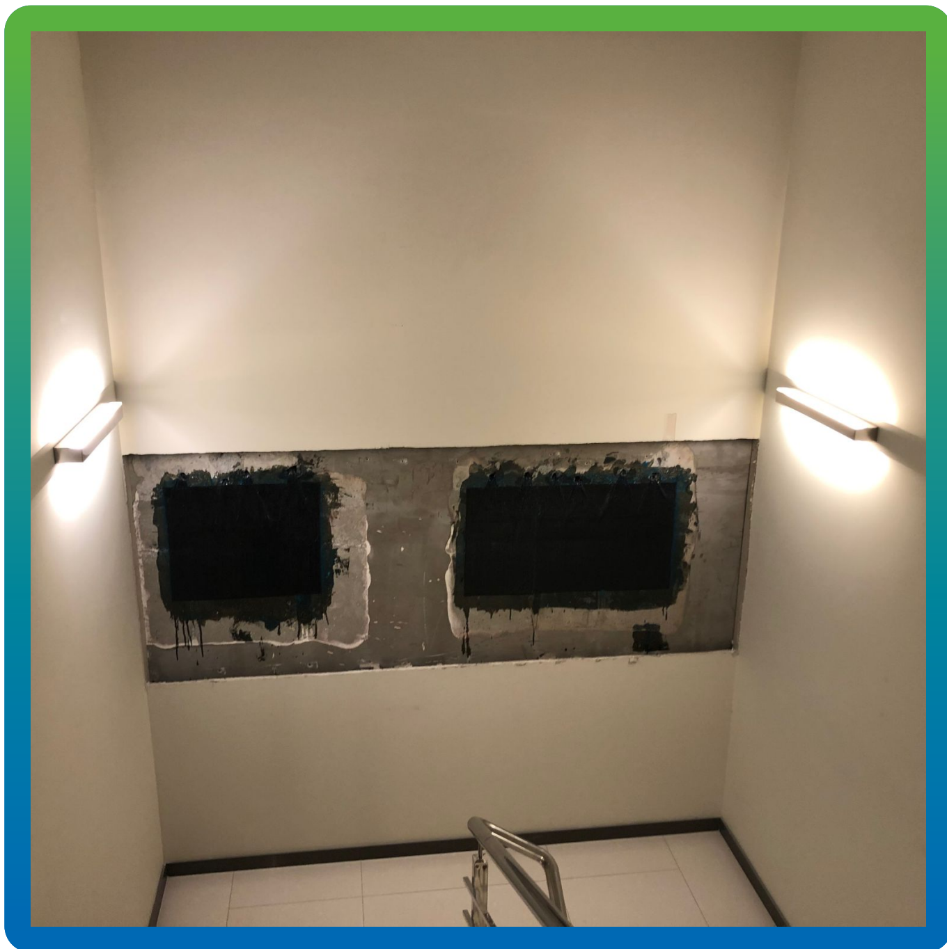
Смонтированные композиционные анкеры. Другой вид
