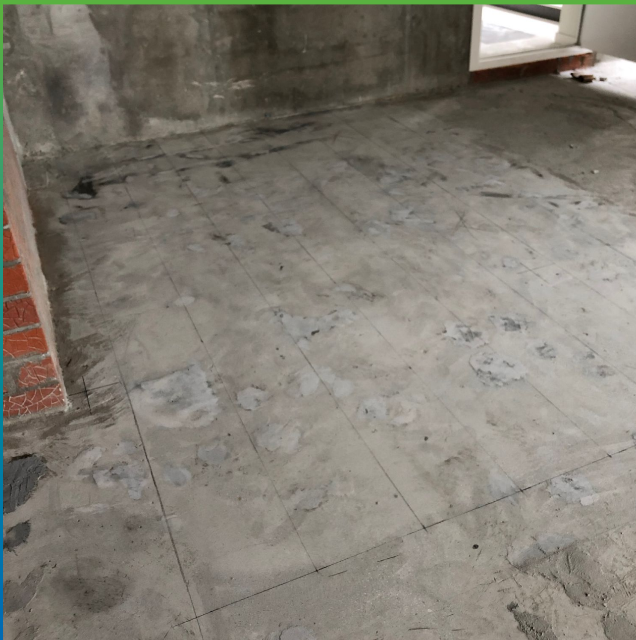
Подготовка основания (шлифовка) и нанесение разметки для монтажа КСУ
