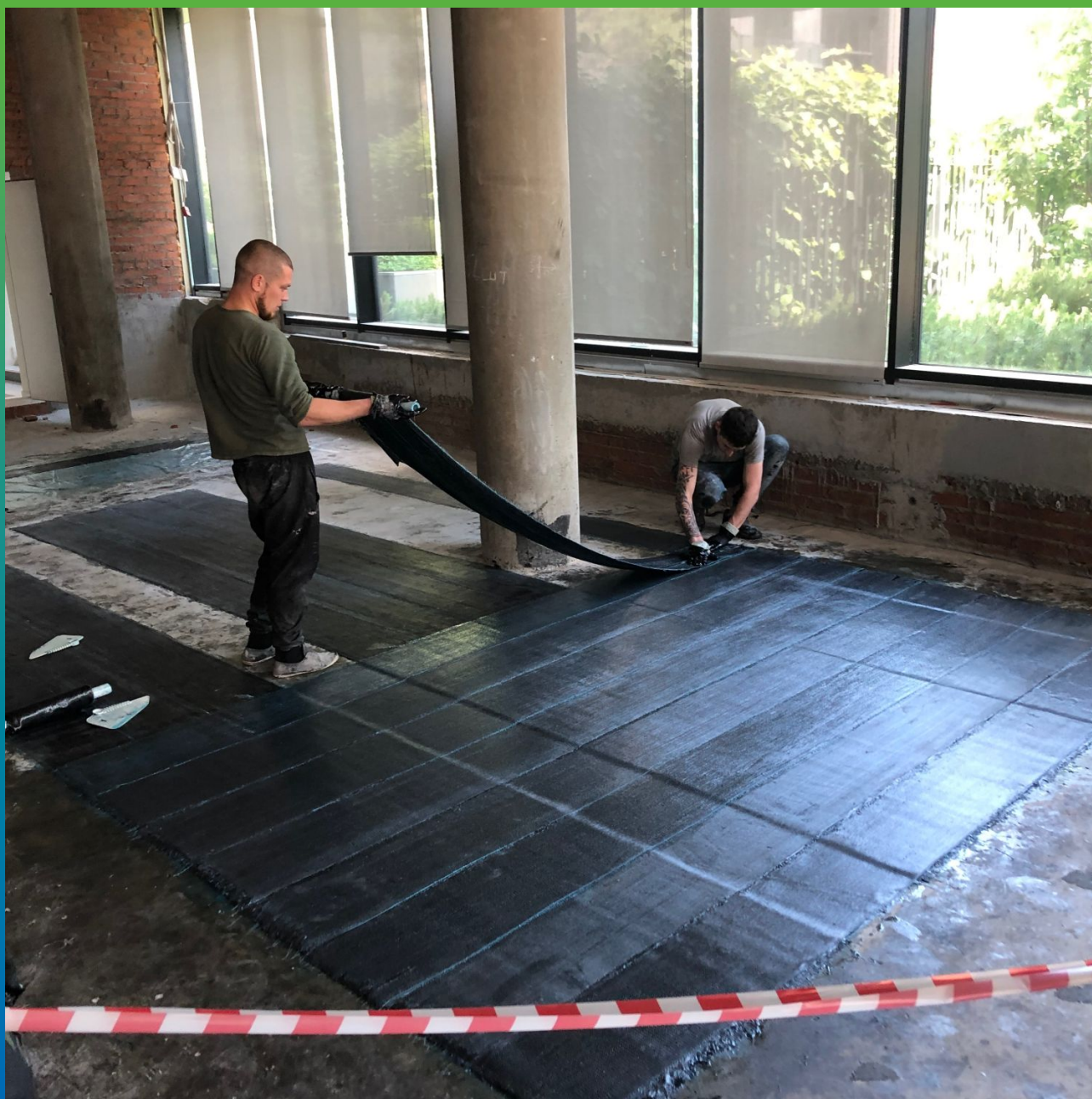
Процесс монтажа последующих слоёв углеродных холстов Армошел KB 500
