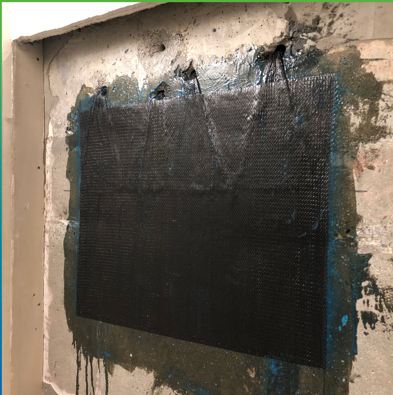
Монтаж композиционных анкеров с обратной стороны шпуров с фиксацией к ж/б элементу
