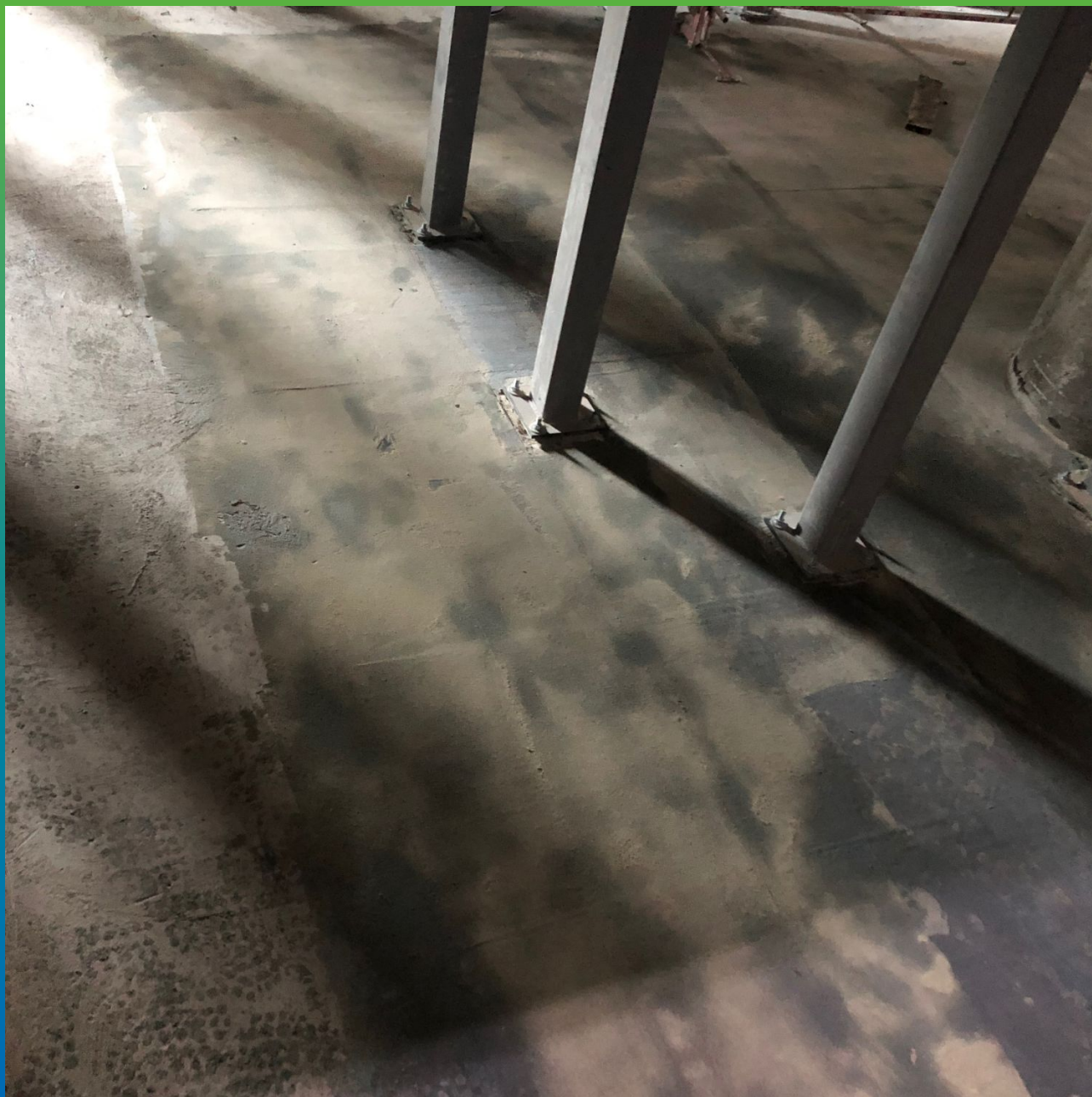
Случай корректировки решения с обходом смонтированных элементов
