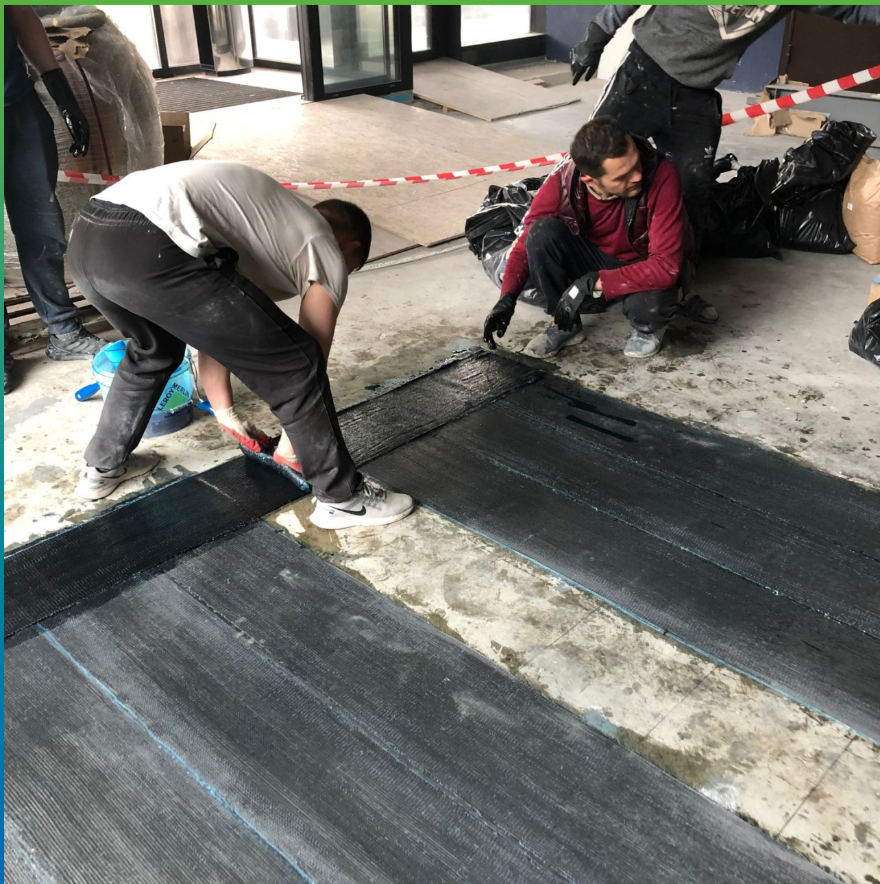
Процесс монтажа углеродных холстов Армошел КВ 500
