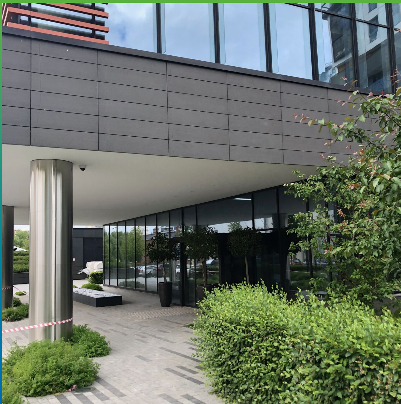
Часть здания с элементом подлежащим усилению (офисы)
