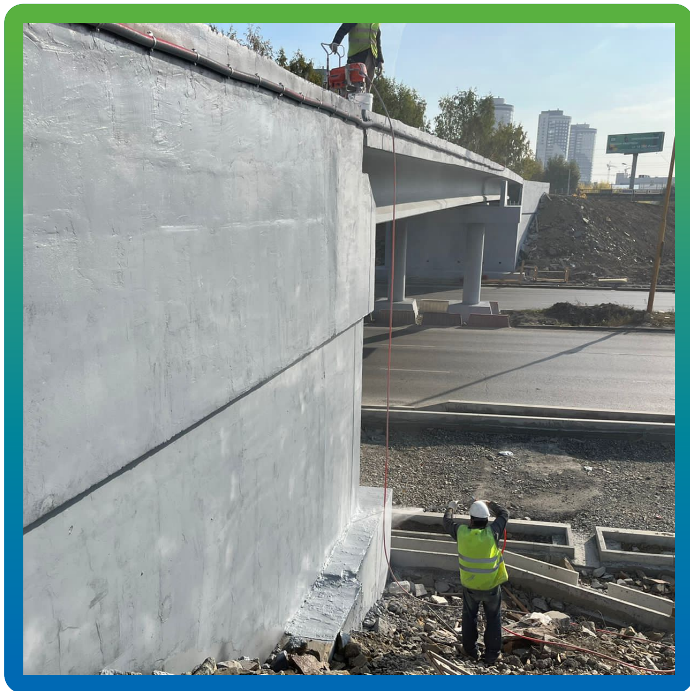
Процесс нанесения состава Маногард АГФ на основание. Другой вид
