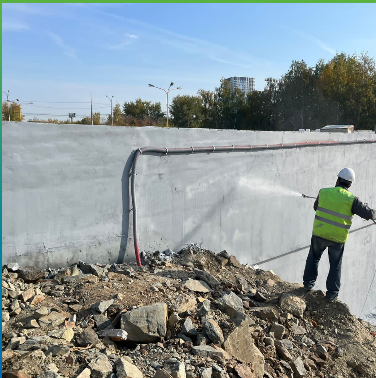
Процесс нанесения состава Маногард АГФ на основание
