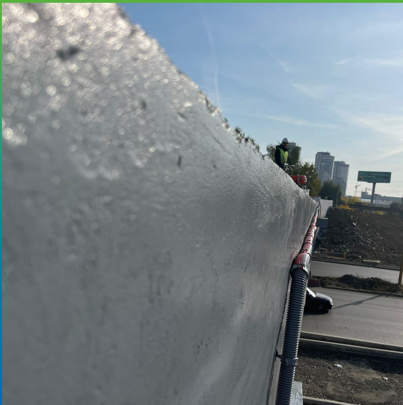
Вид обработанного мостового сооружения антивандальным составом. Детальный ракурс 2
