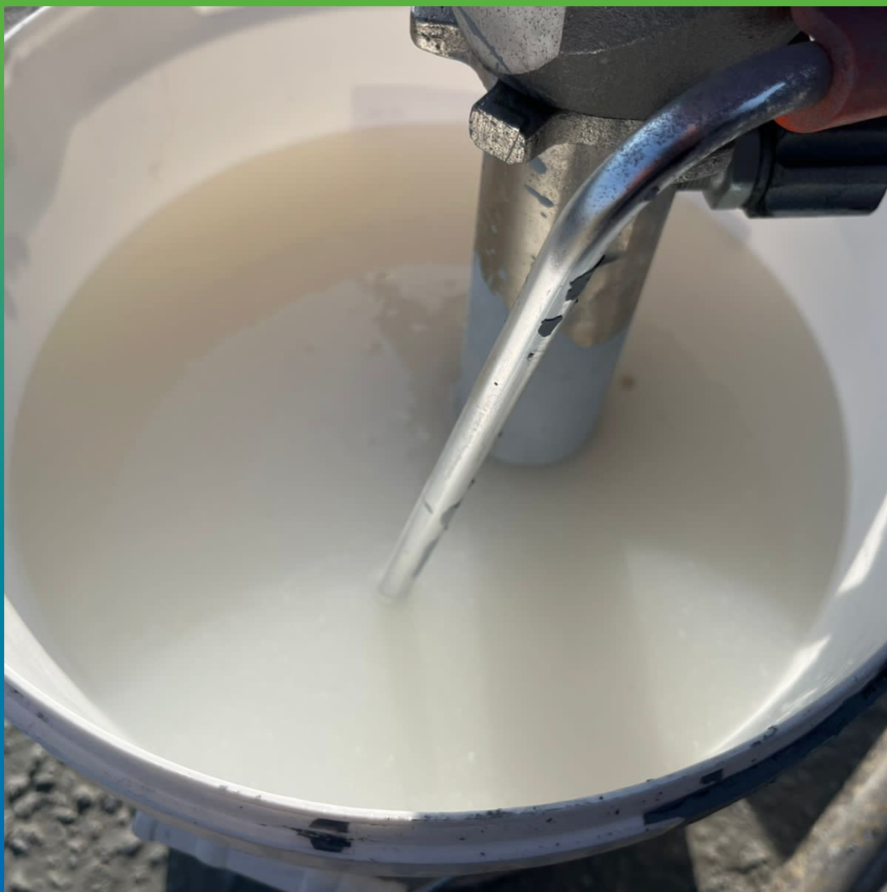
Вид подготовленного состава Маногард АГФ в процессе работы
