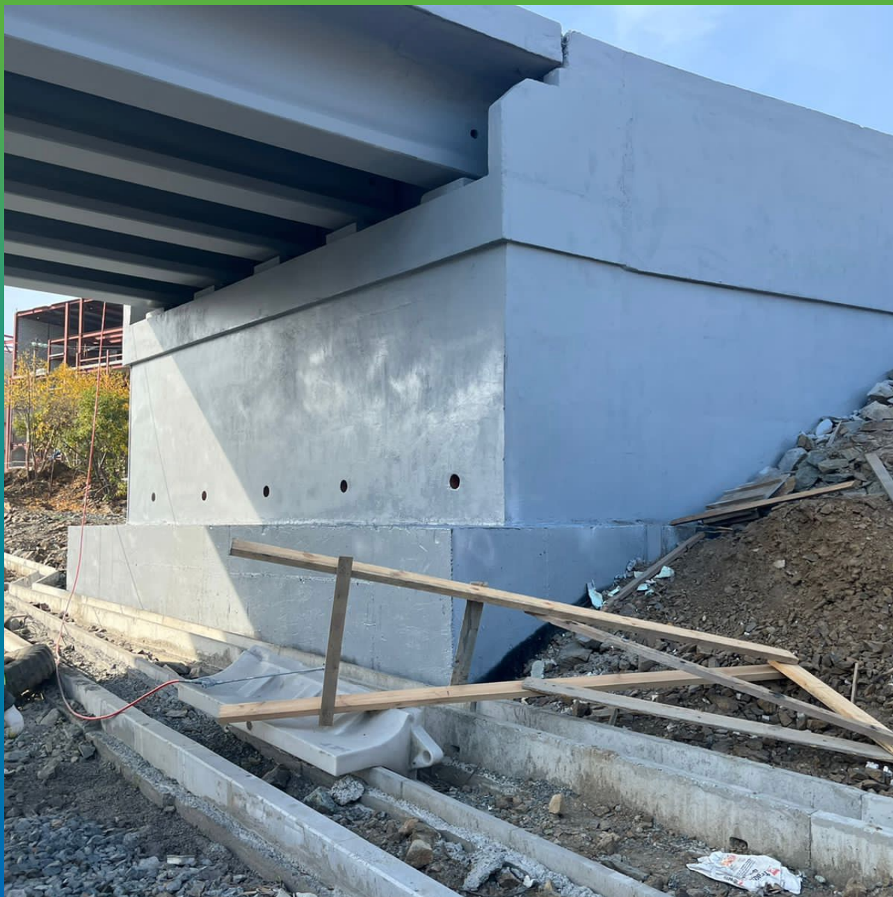
Вид обработанного мостового сооружения антивандальным составом. Другой ракурс
