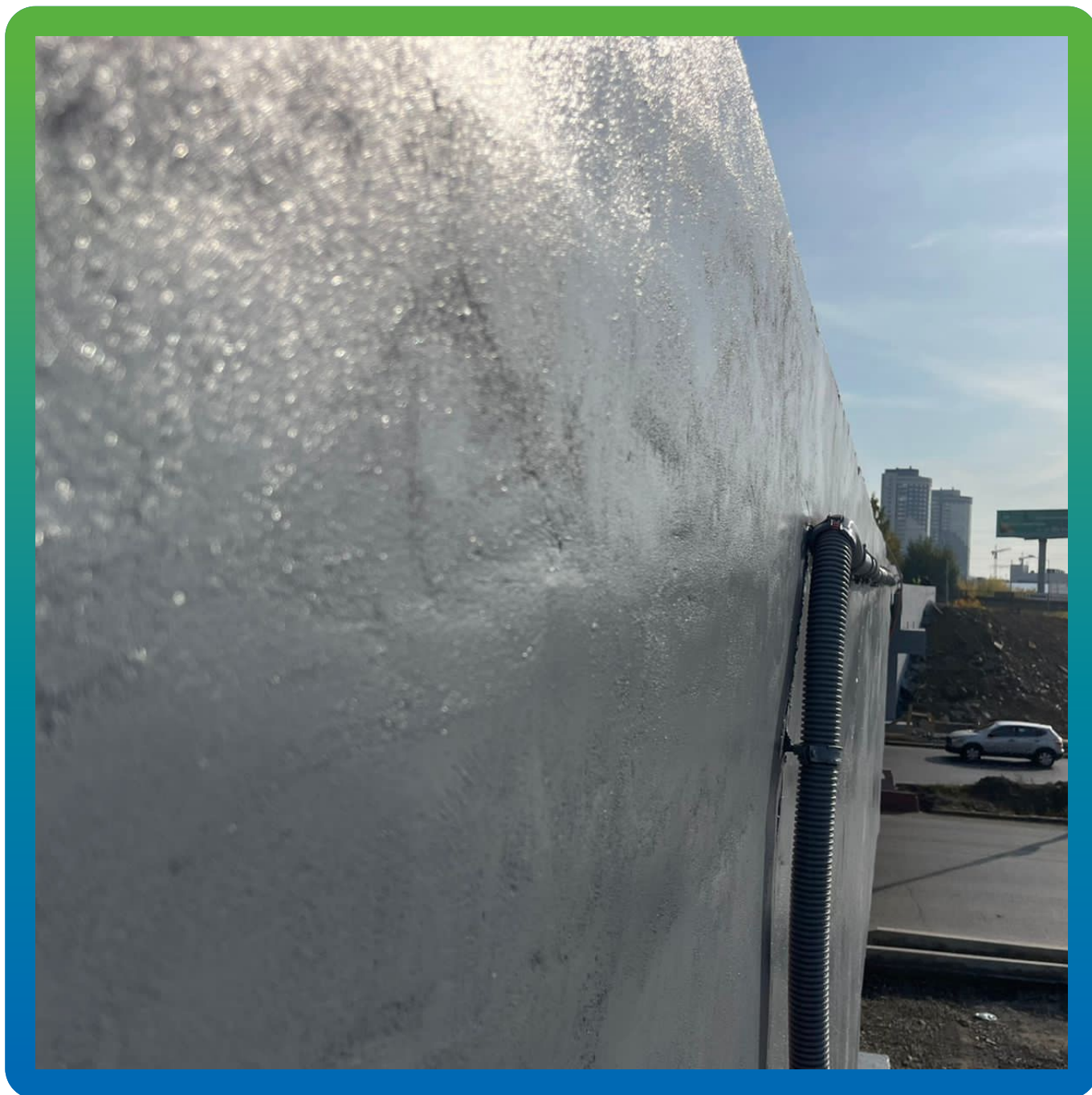
Вид обработанного мостового сооружения антивандальным составом. Детальный ракурс
