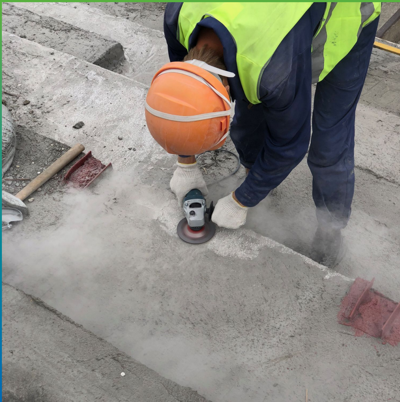
Процесс выравнивания поверхности шлифовкой
