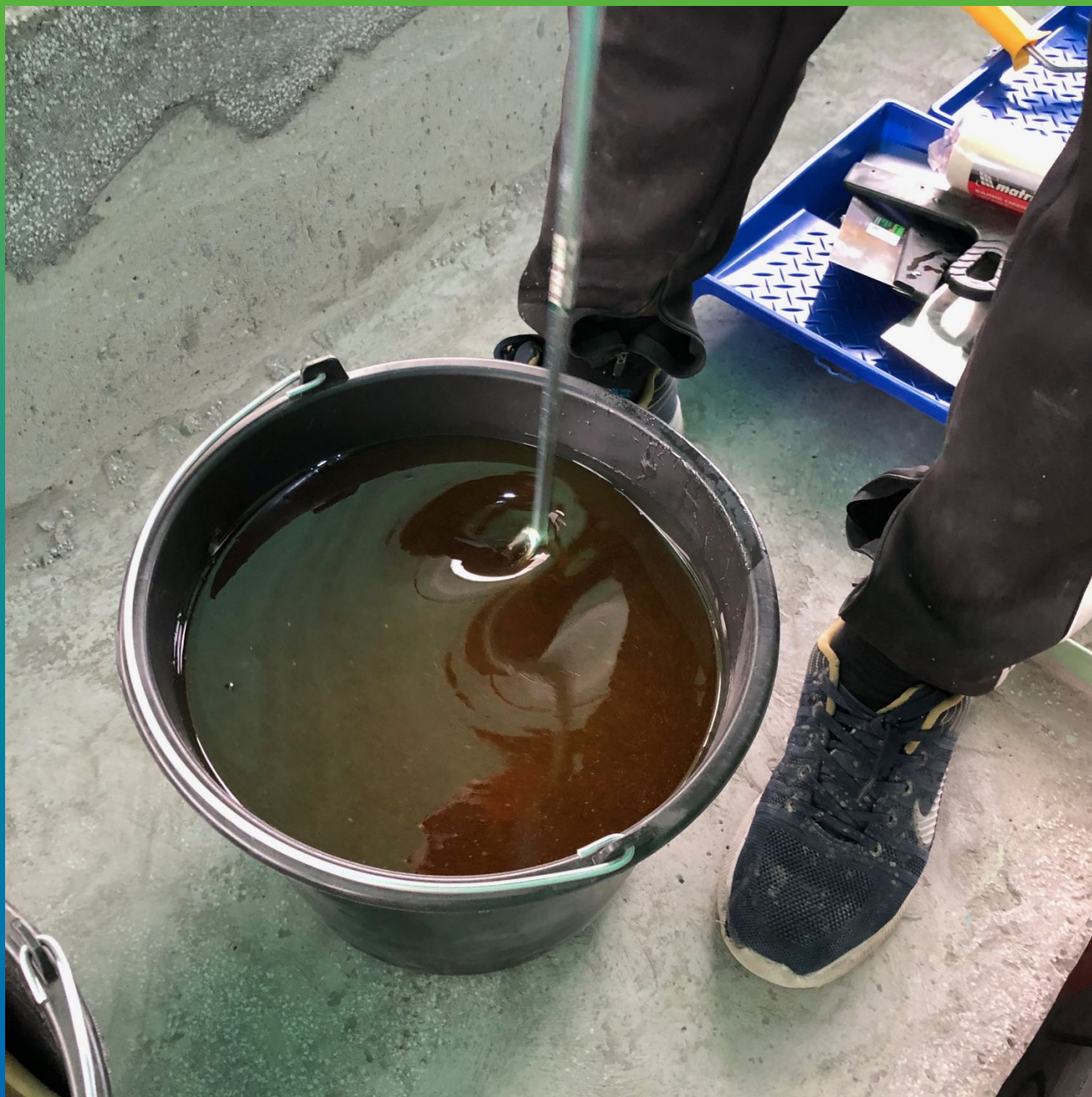
Замешивание компонентов грунтовки Денстоп ЭП 106
