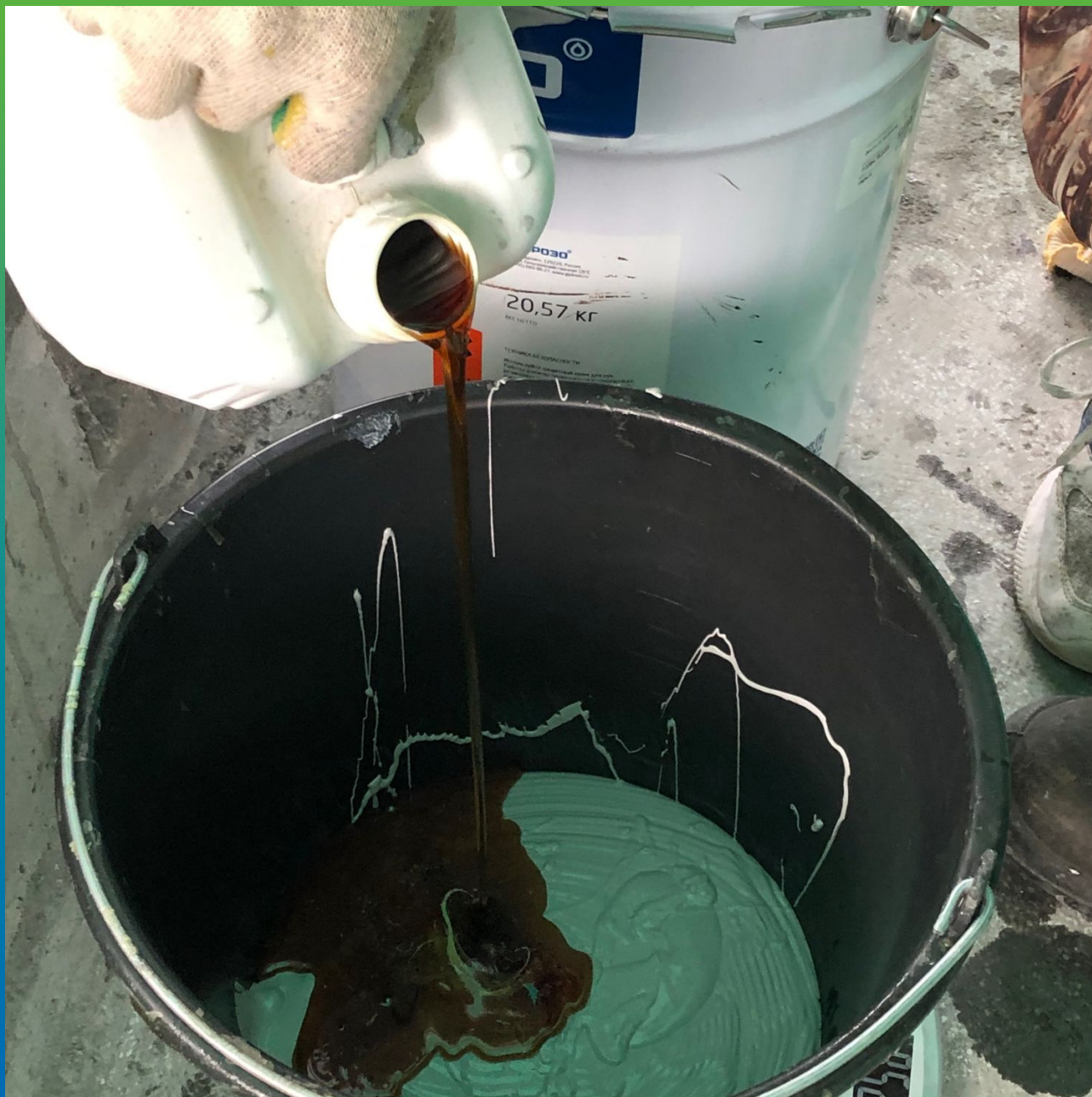
Замешивание компонентов защитного покрытия Денстоп ПУ 730 УФ Колор. Добавление компонента Б
