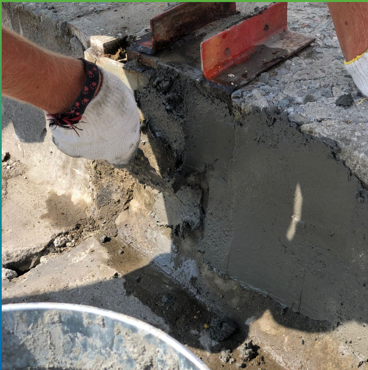
Процесс ремонта основания. Другой ракурс
