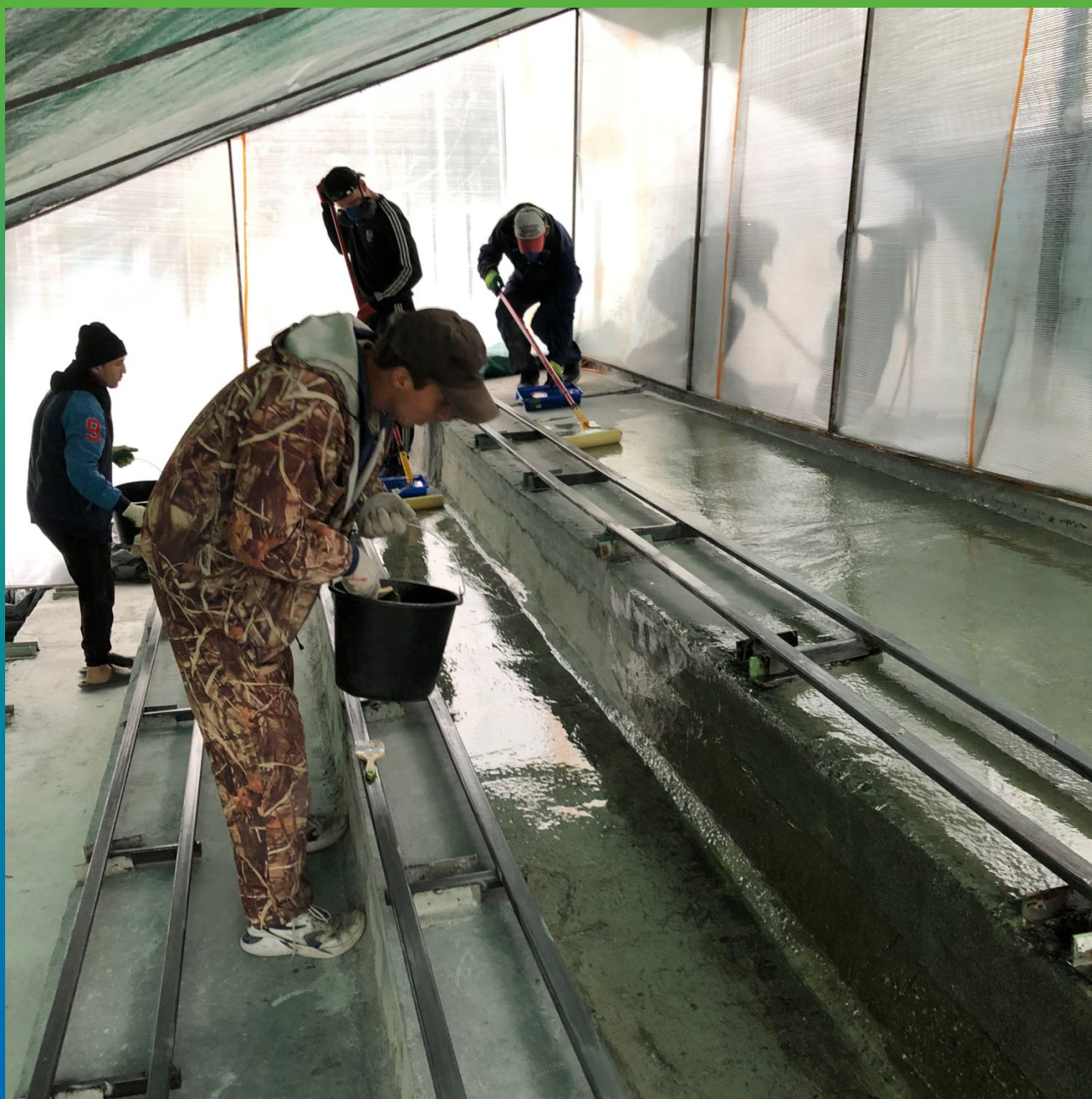
Грунтование поверхности за 2 раза составом Денстоп ЭП 106
