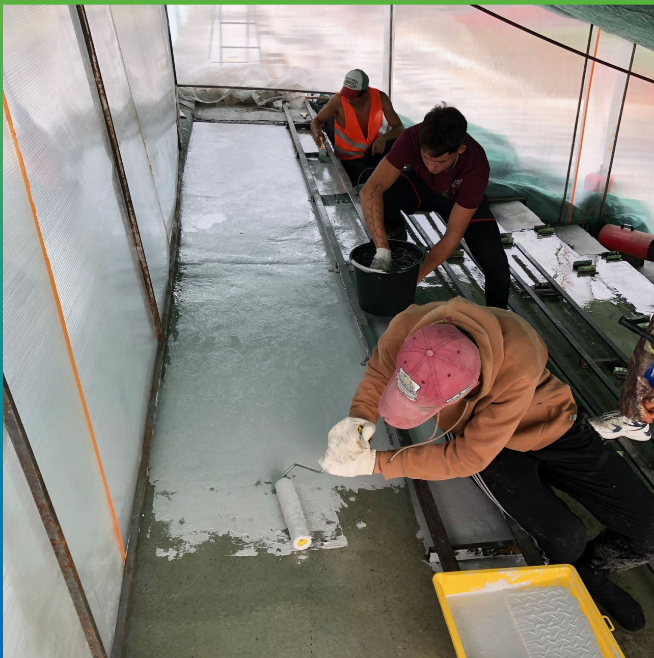
Процесс нанесения композиции Денстоп ПУ 730 УФ Колор на основание
