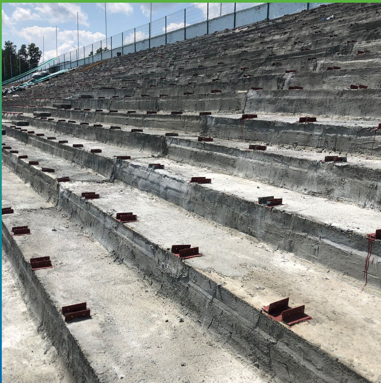
Общий вид на отремонтированную поверхность
