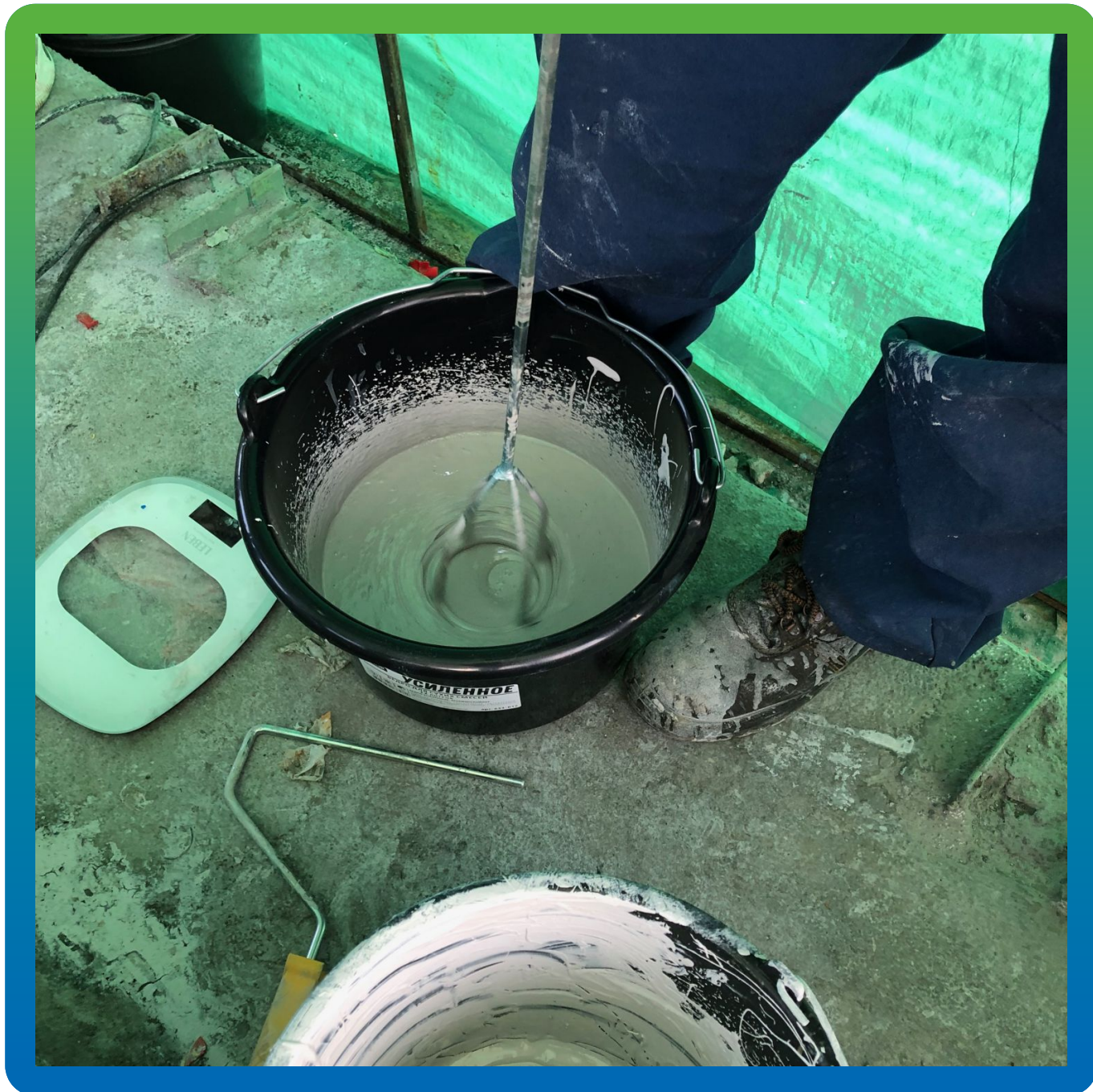
Замешивание компонентов защитного покрытия Денстоп ПУ 730 УФ Колор. Перемешивание
