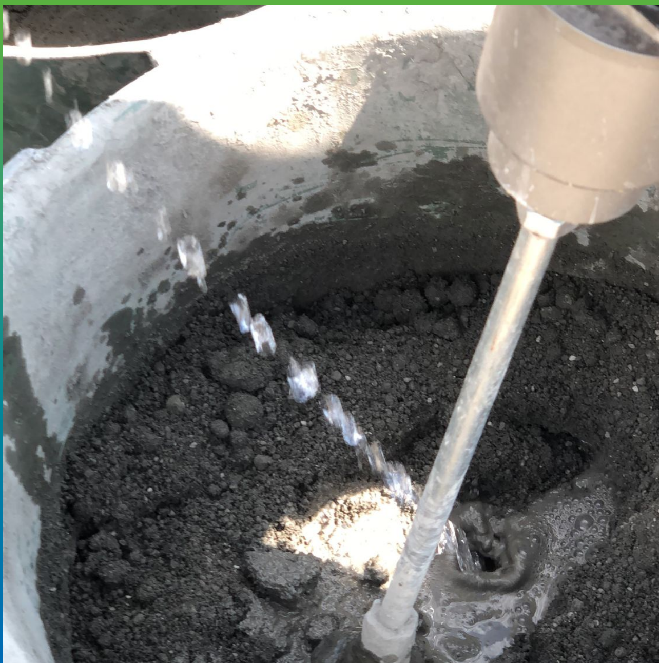
Замешивание состава Стармекс РМ4 с водой
