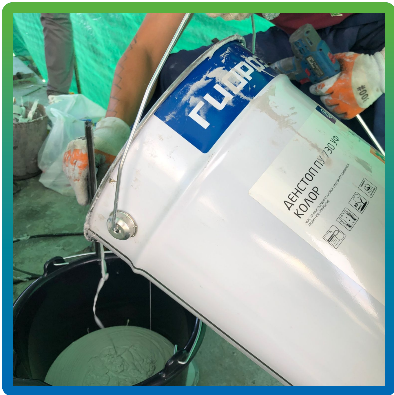
Замешивание компонентов защитного покрытия Денстоп ПУ 730 УФ Колор. Добавление компонента А
