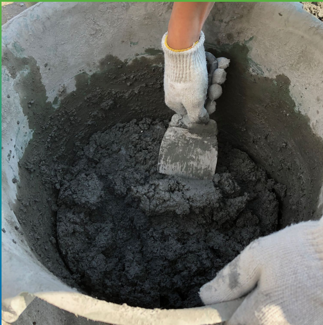
Проверка состава на готовность после тех перерыва
