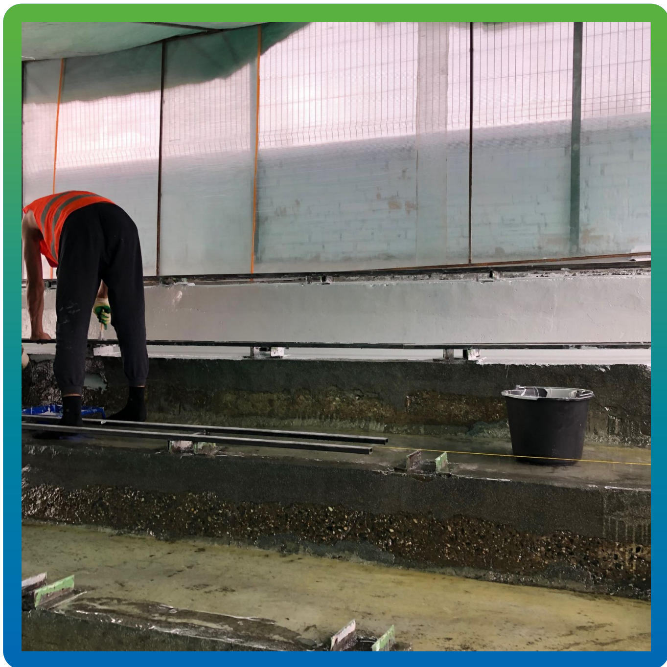
Процесс нанесения композиции Денстоп ПУ 730 УФ Колор на основание. Другой ракурс
