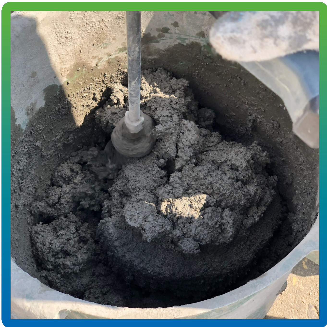
Смешивание состава Стармекс РМ4 ручным строительным миксером
