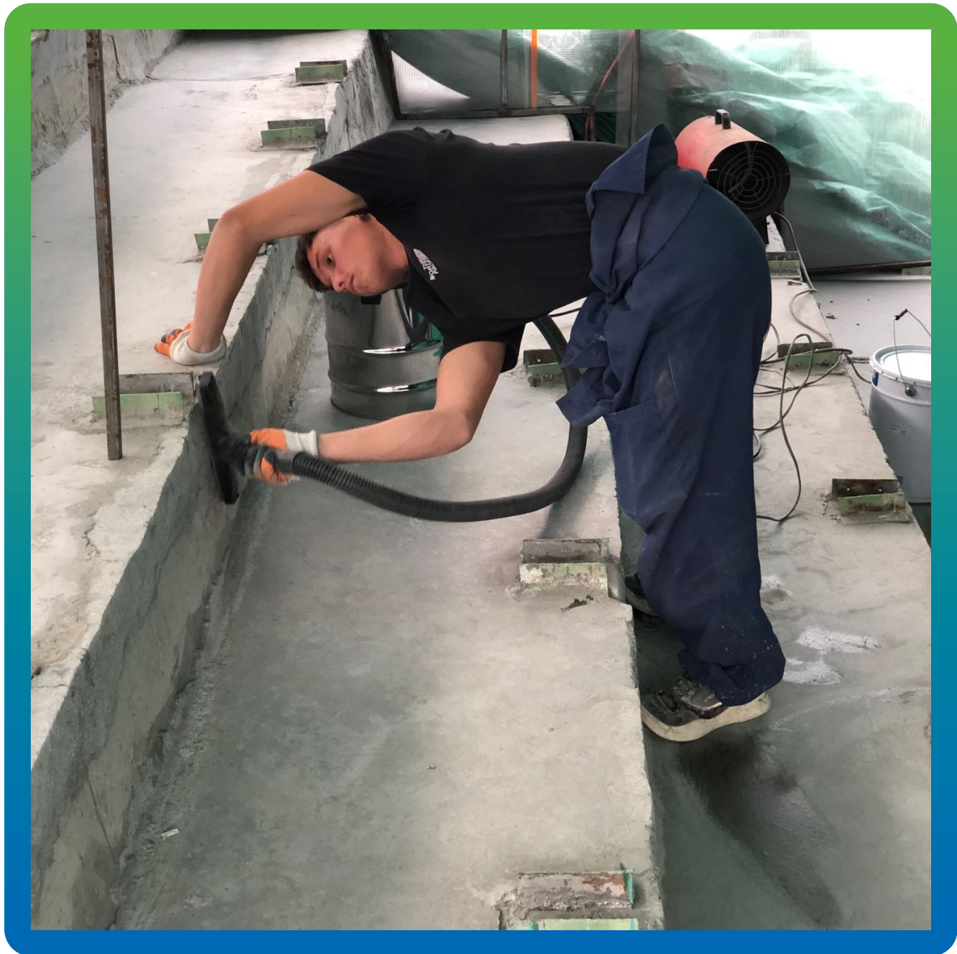
Обеспыливание поверхности строительным пылесосом
