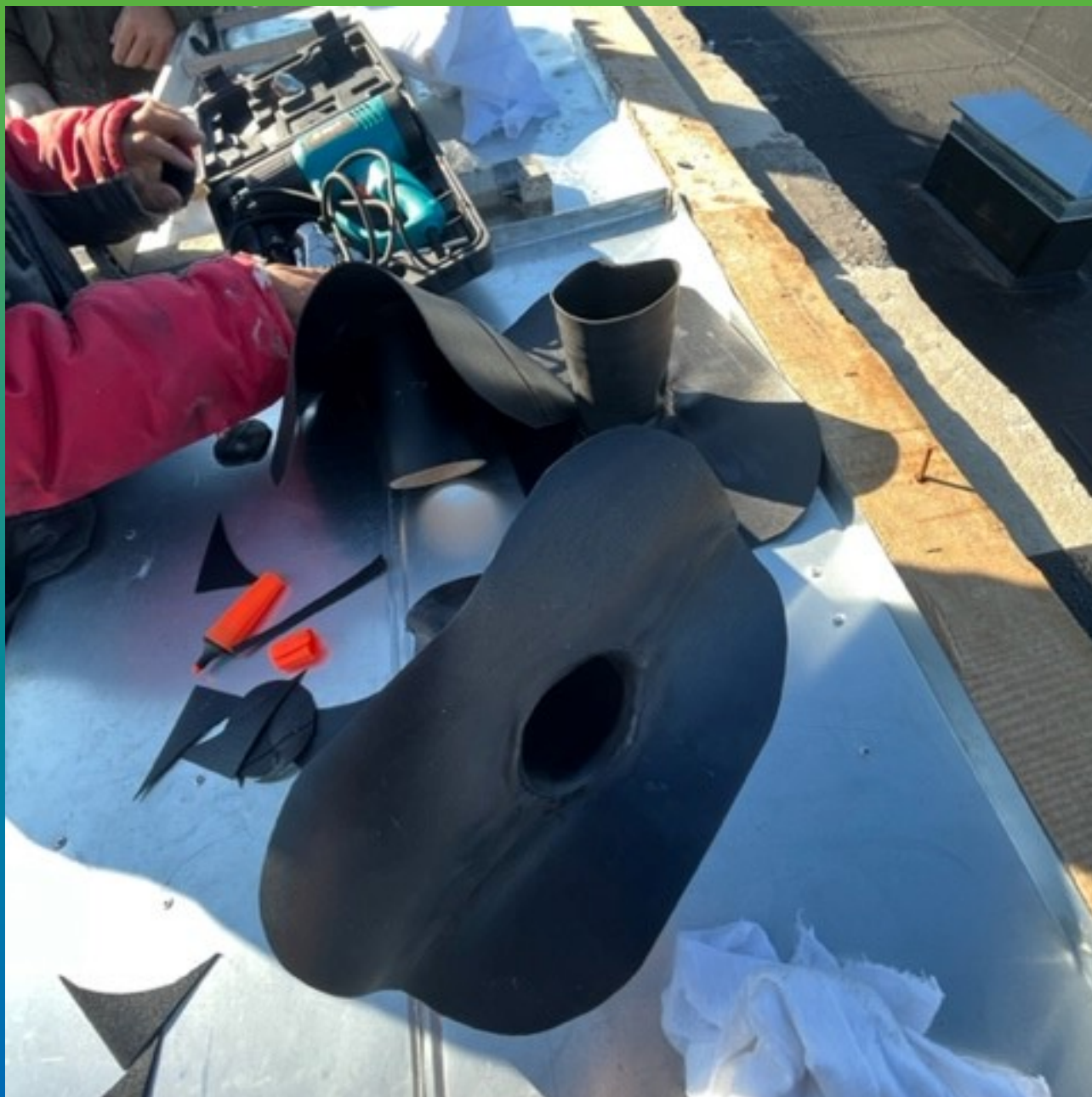
13.10.22 - изготовление фасонных изделий на объекте из материала Термобонд 150/20.
