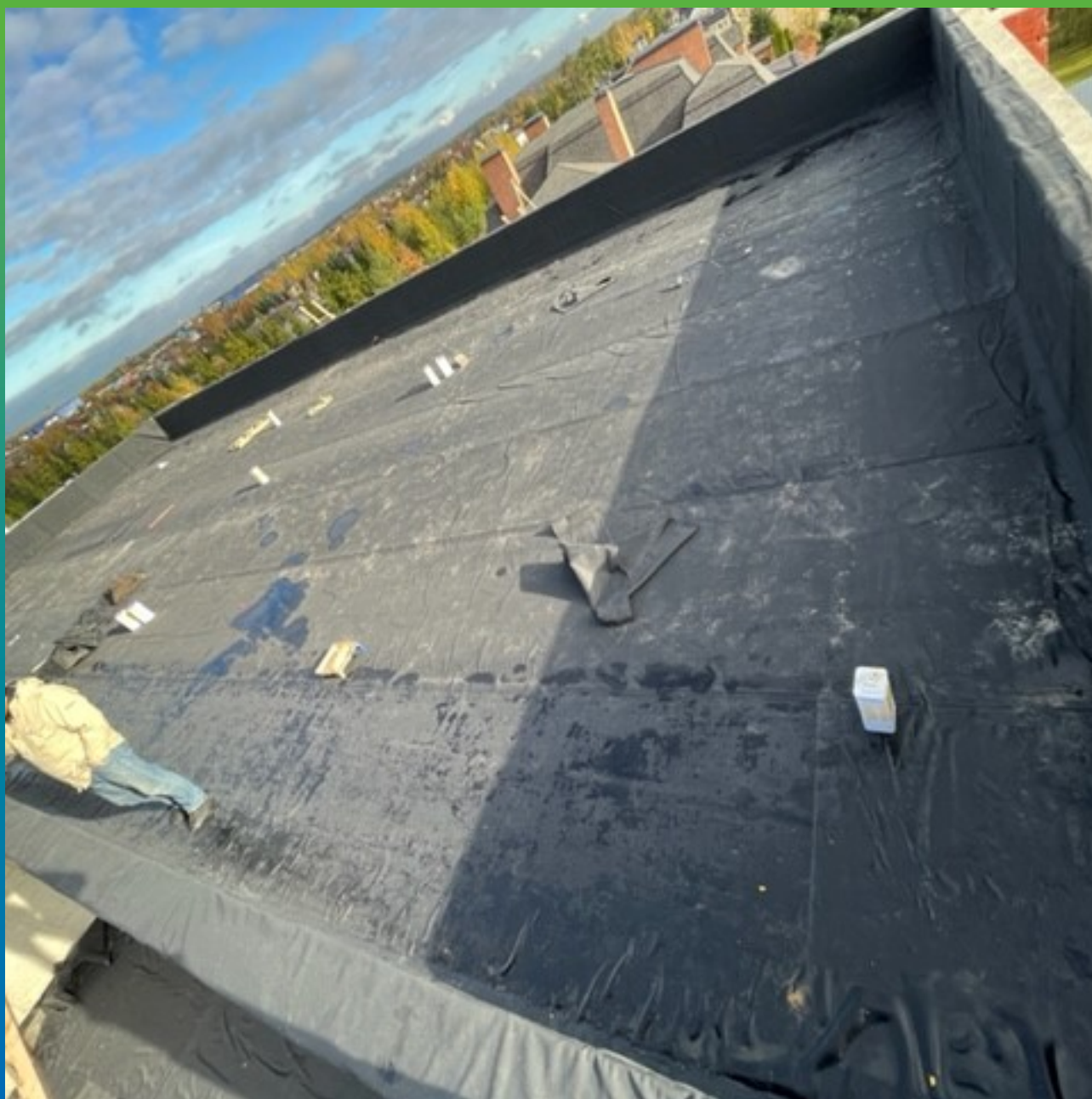
13.10.22 - вид на вторую кровлю полностью проклеенную материалом Преласты П400 и частично с обваренными углами.
