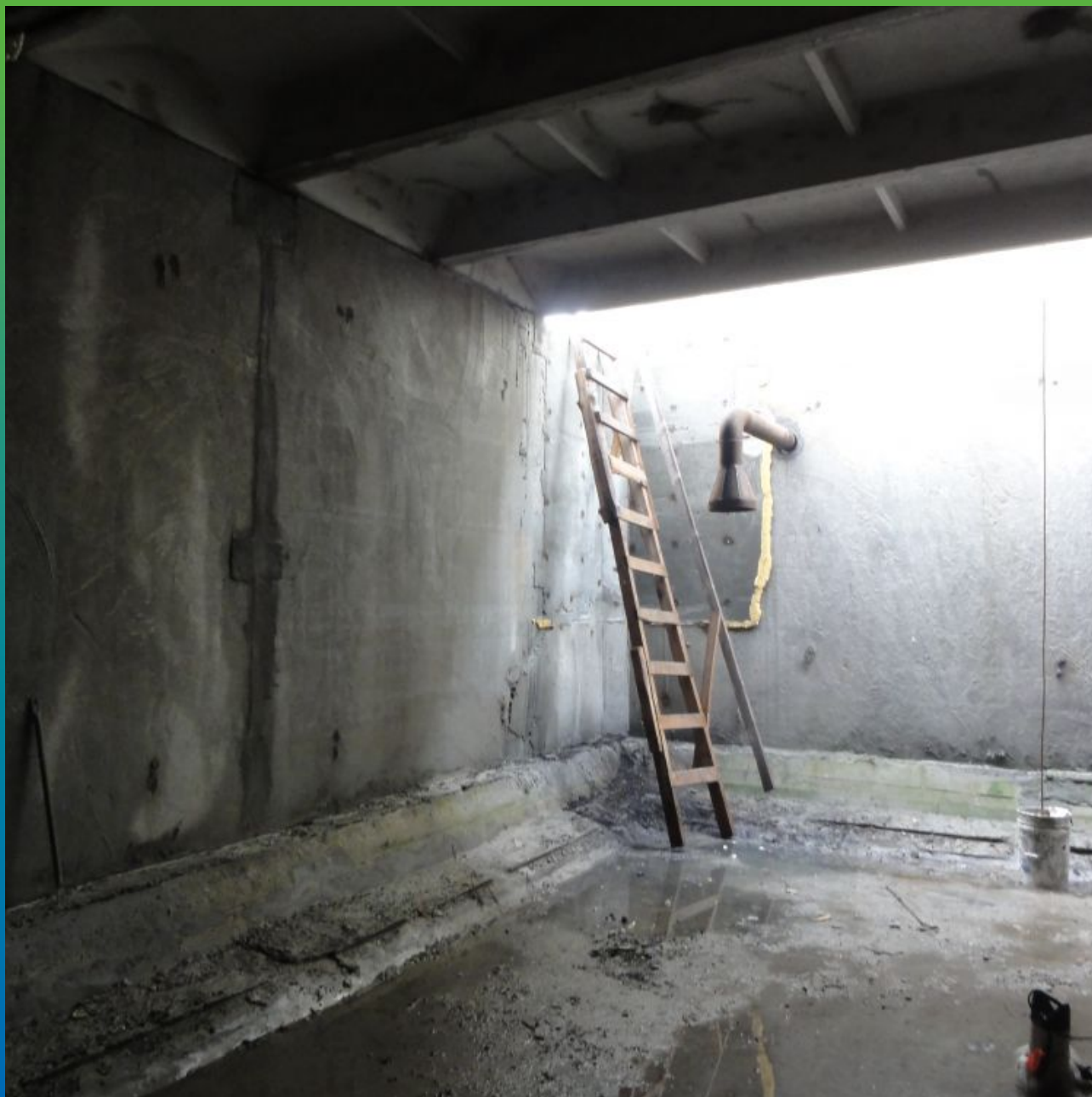
Первоначальный вид объекта
