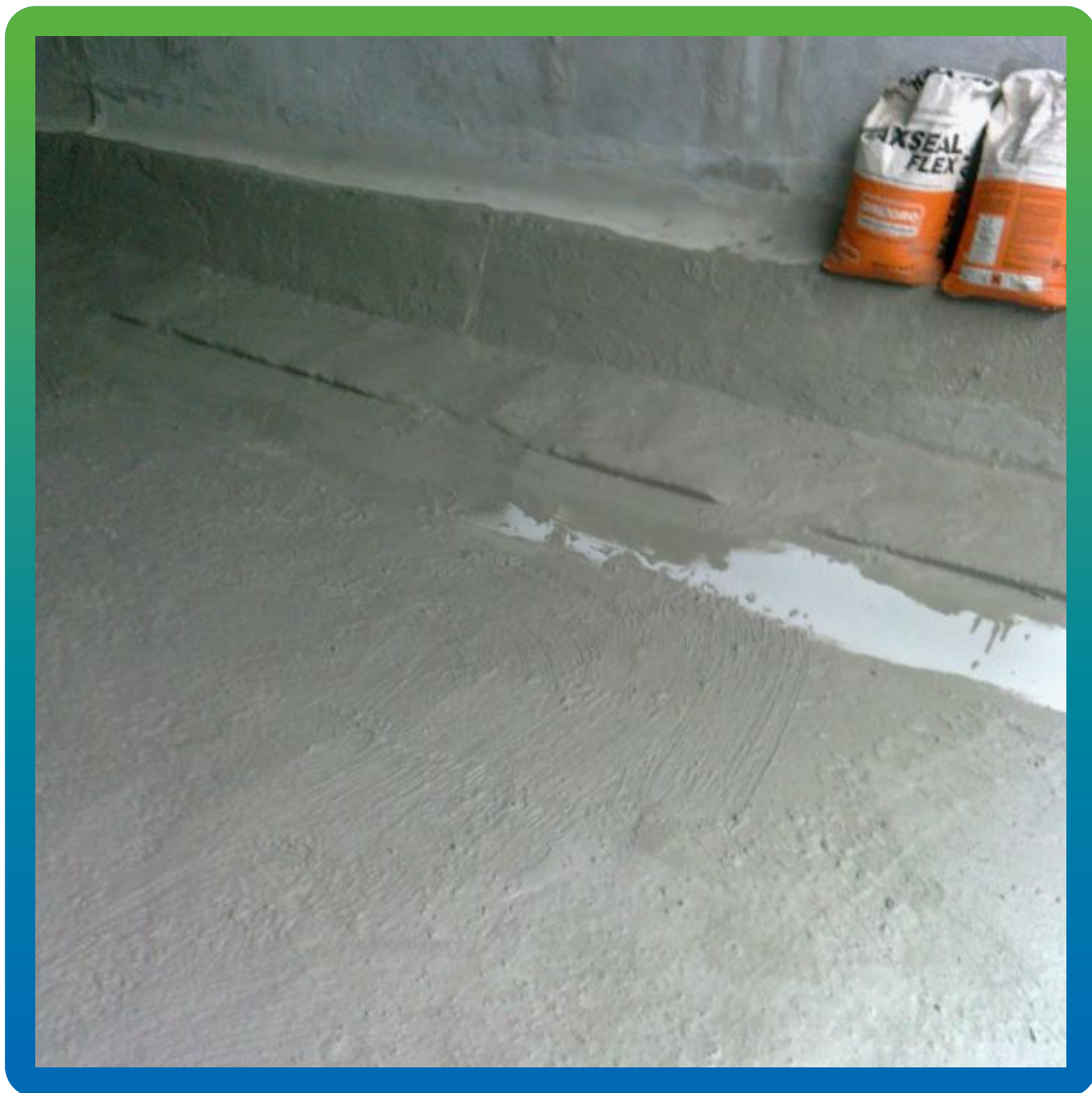
Нанесенный Макссил Флекс и Манодил на адгезив Манопокс 331
