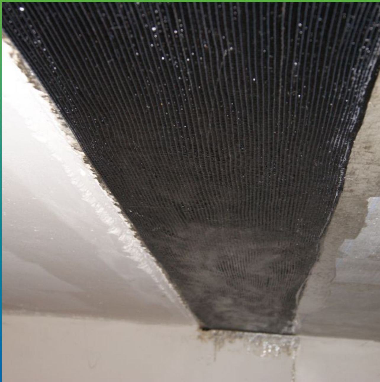
Монтаж полос Тайфо СЦХ
