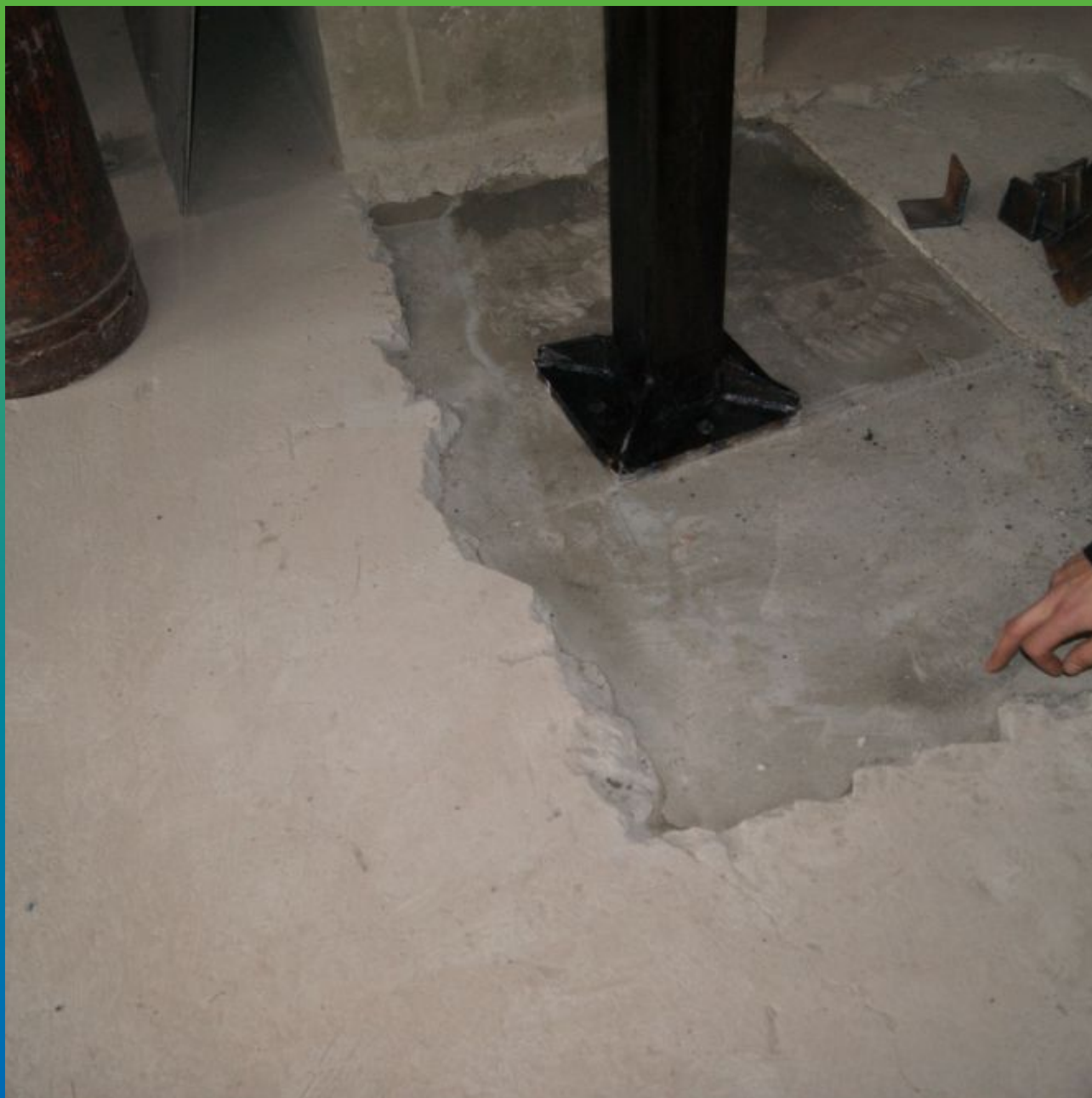
Крепление колонны, требующее фиксации подливочным составом Максграут
