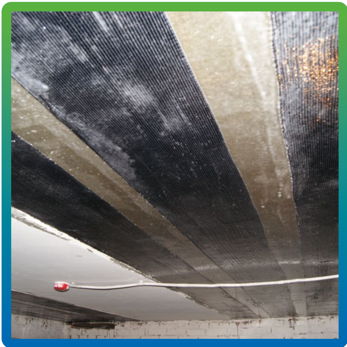
Монтаж полос Тайфо СЦХ, согласно расчётной схеме
