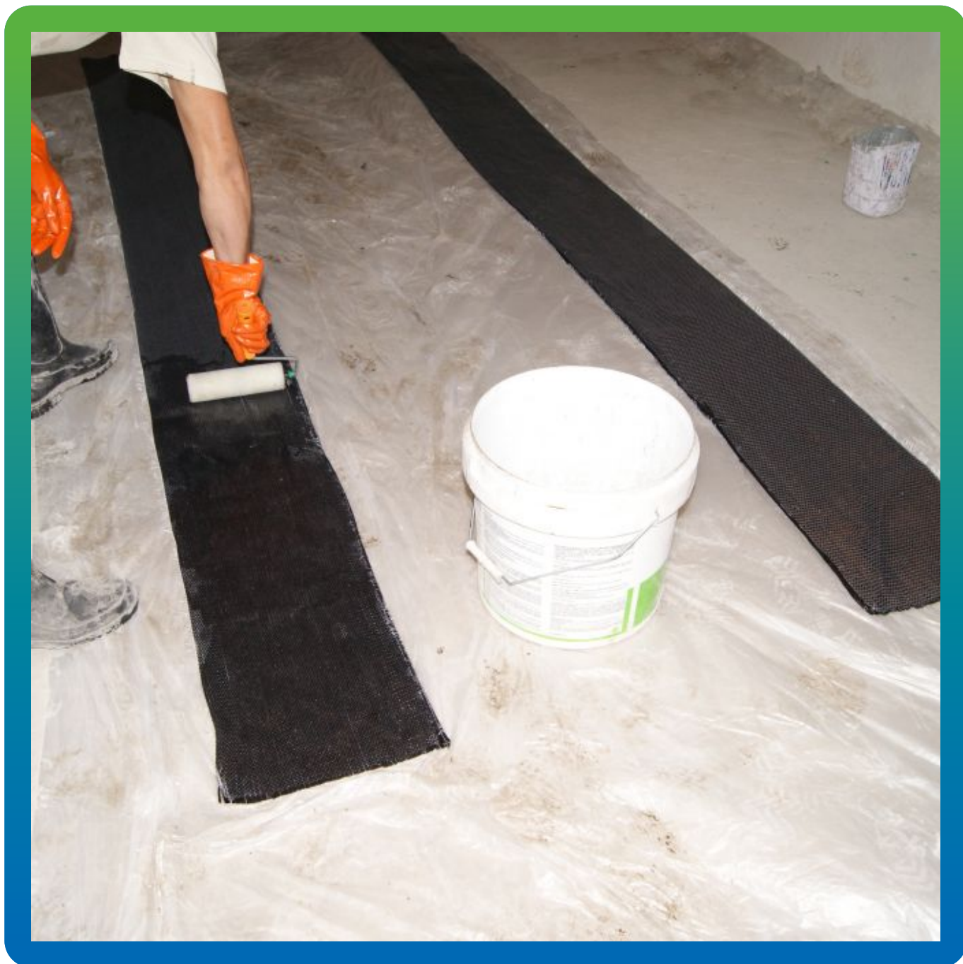
Пропитка адгезивом Тайфо С углеродного холста Тайфо СЦХ
