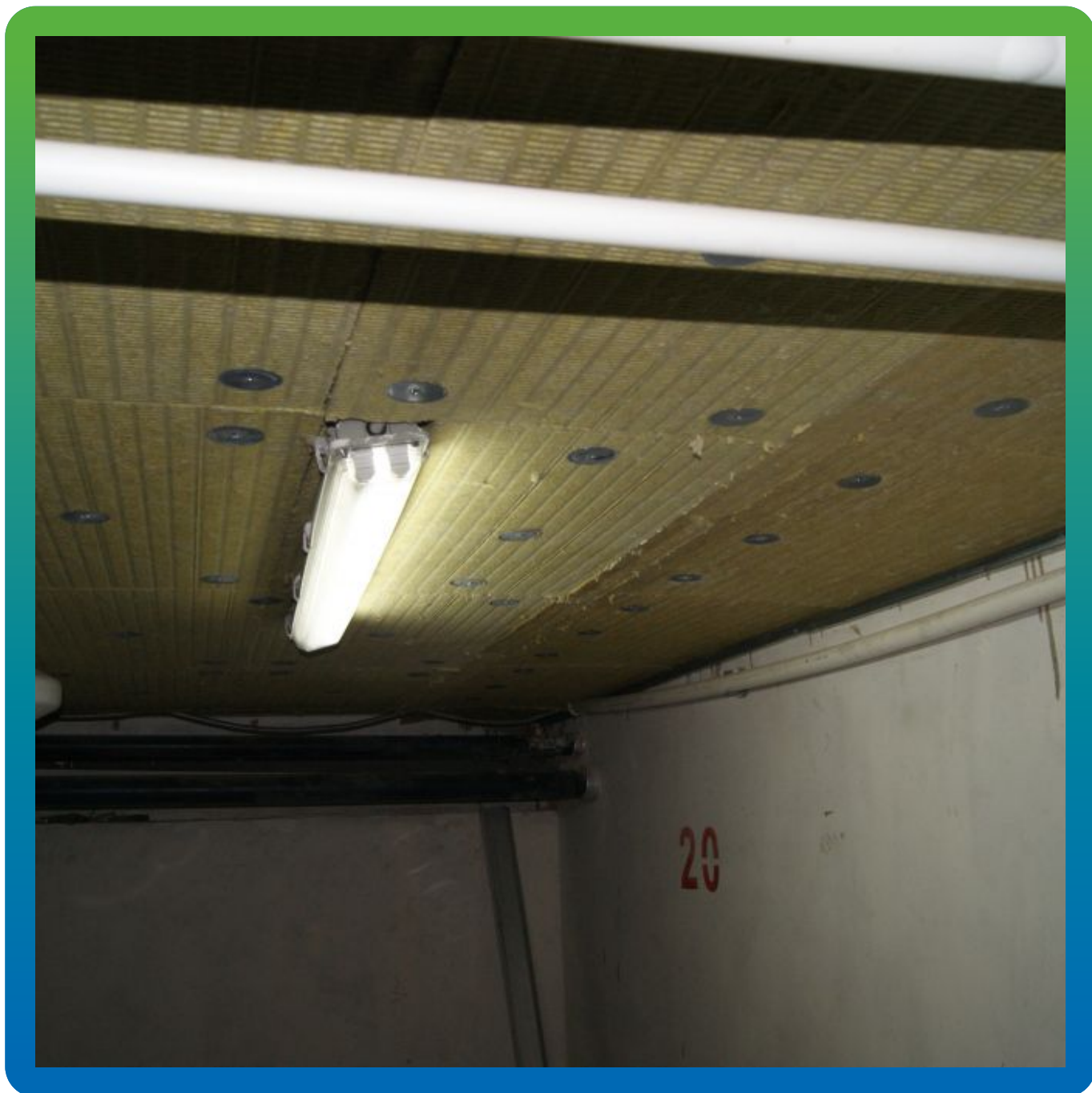
Установка теплозвукоизоляционных плит на основание, усиленное системой Файф
