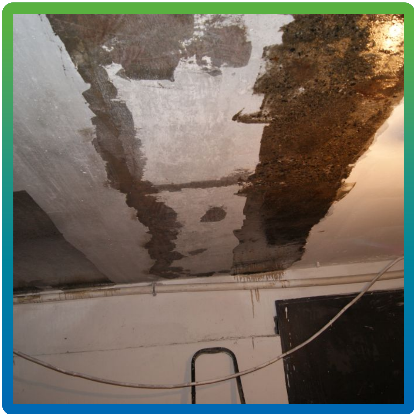
Грунтовка поверхности эпоксидным адгезивом Тайфо С
