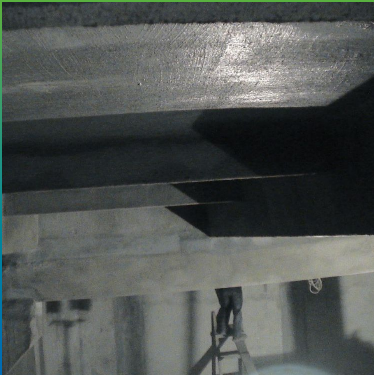
Устройство площадной гидроизоляции Макссил с добавлением Максрил
