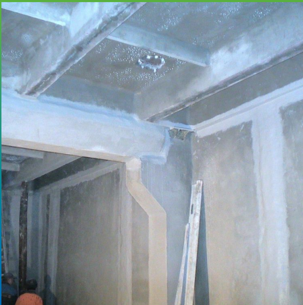
Нанесения Макссил Флекс на холодные и рабочие швы бетонирования
