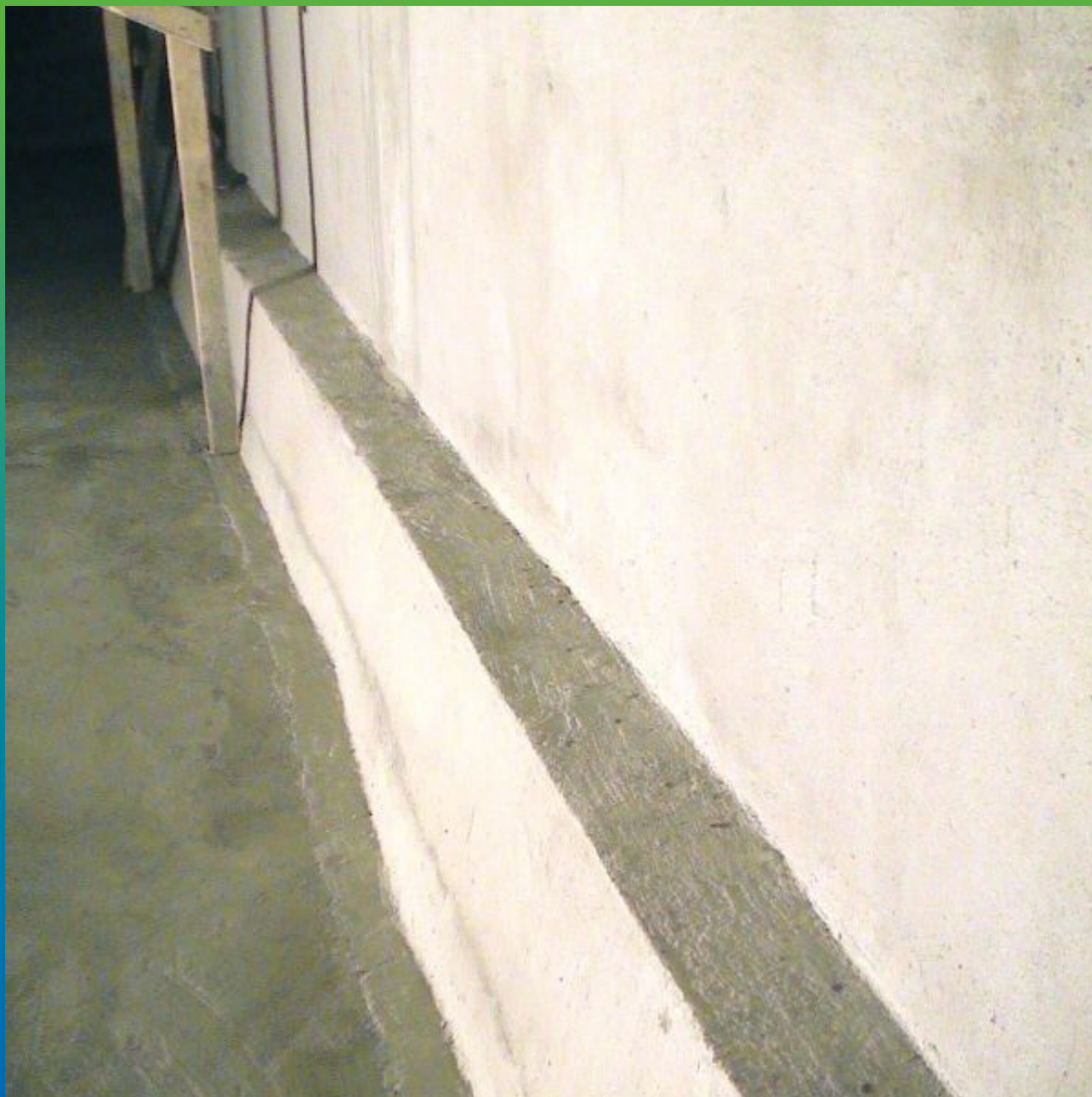
Вид объекта после выполнения ремонтных работ
