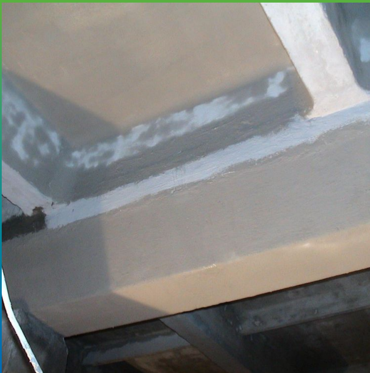
Устройство площадной гидроизоляции Макссил с добавлением Максрил
