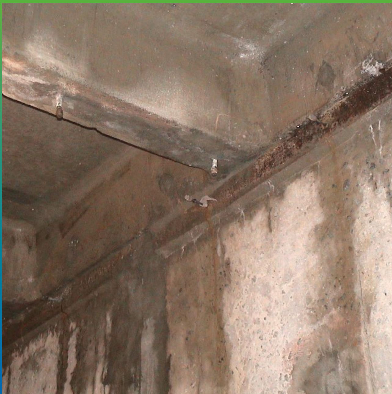
Инъектирование рабочих швов бетонирования
