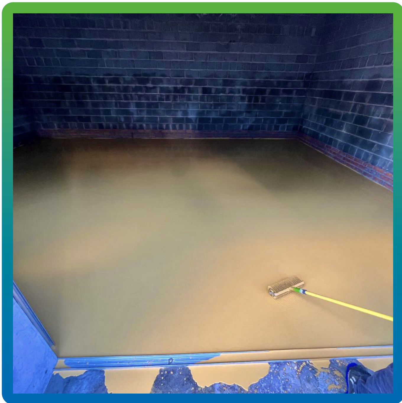
Финишный вид поверхности после укладки
