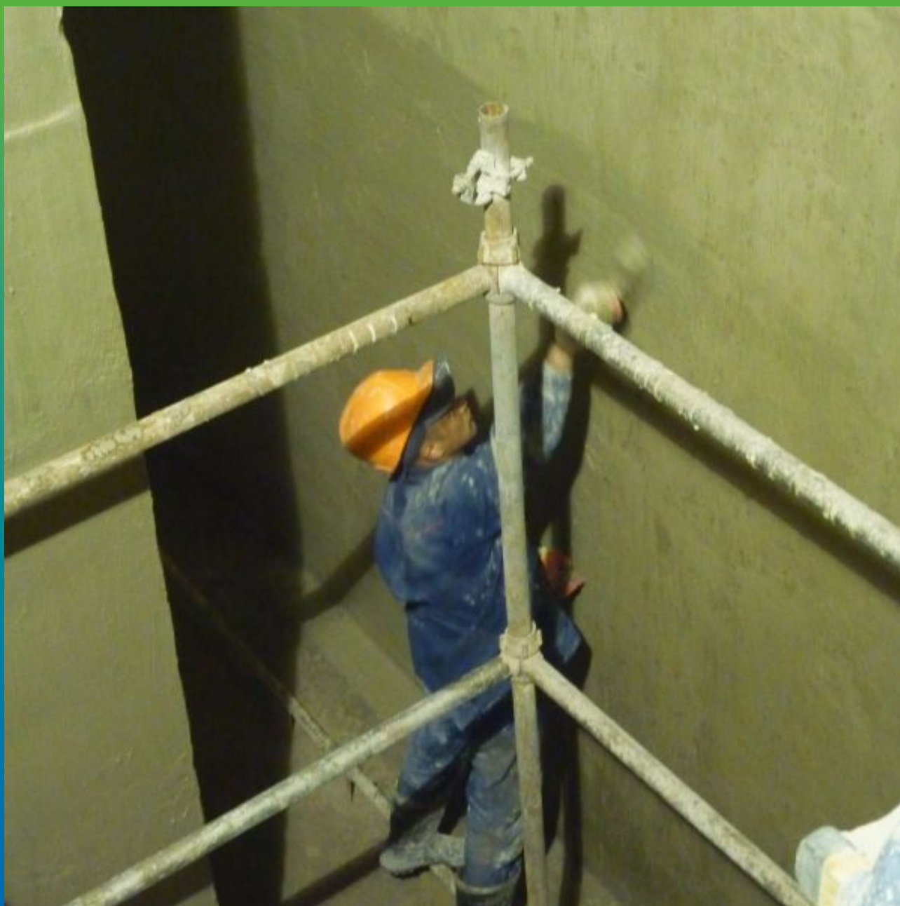
Нанесение Макссил Супер
