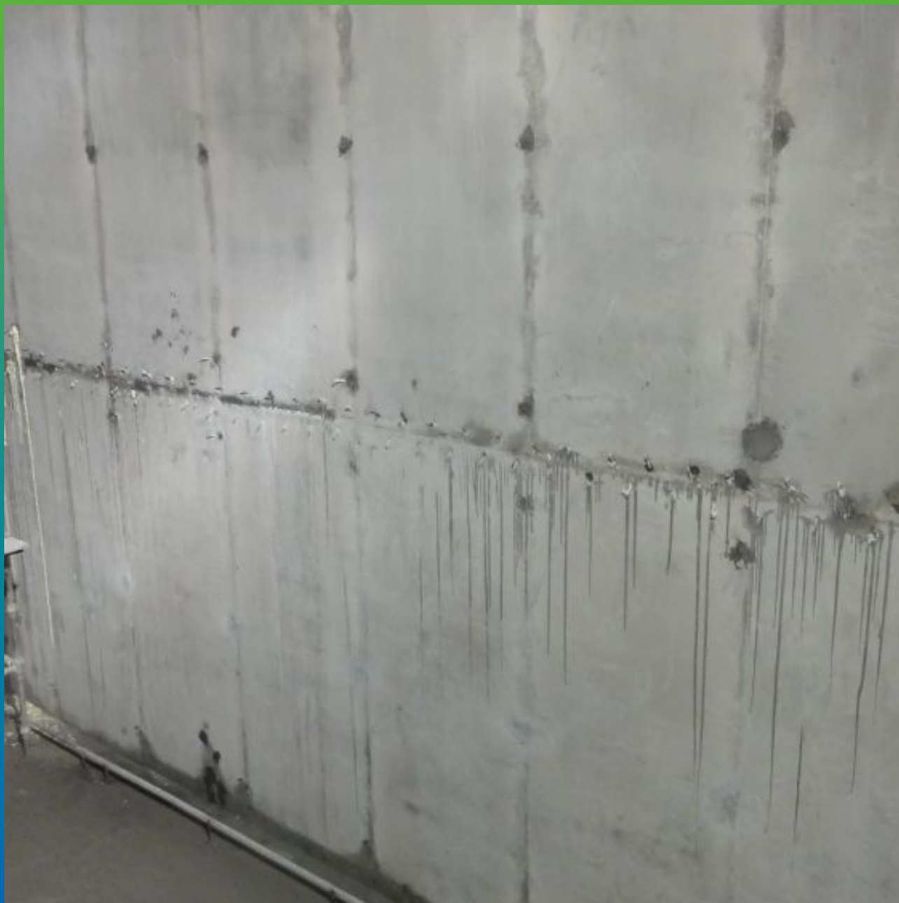
Подготовка поверхности резервуара перед нанесением Макссил Супер
