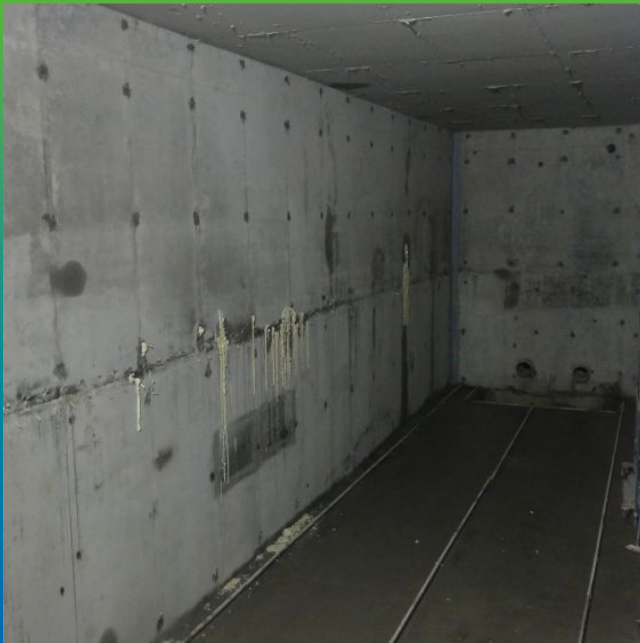
Монтаж гидроизоляционной ленты Манодил Гео
