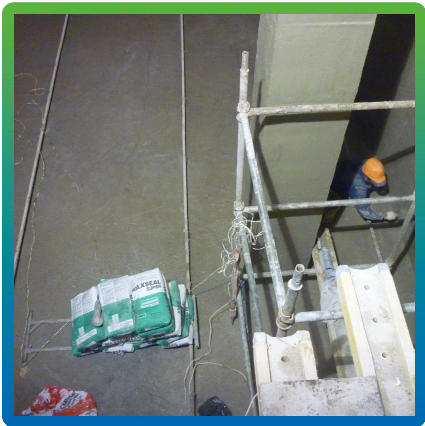
Нанесение Макссил Супер
