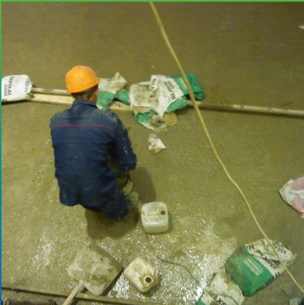
Приготовление материала Максил Супер
