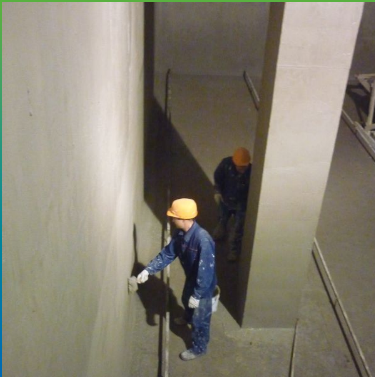
Нанесение Макссил Супер
