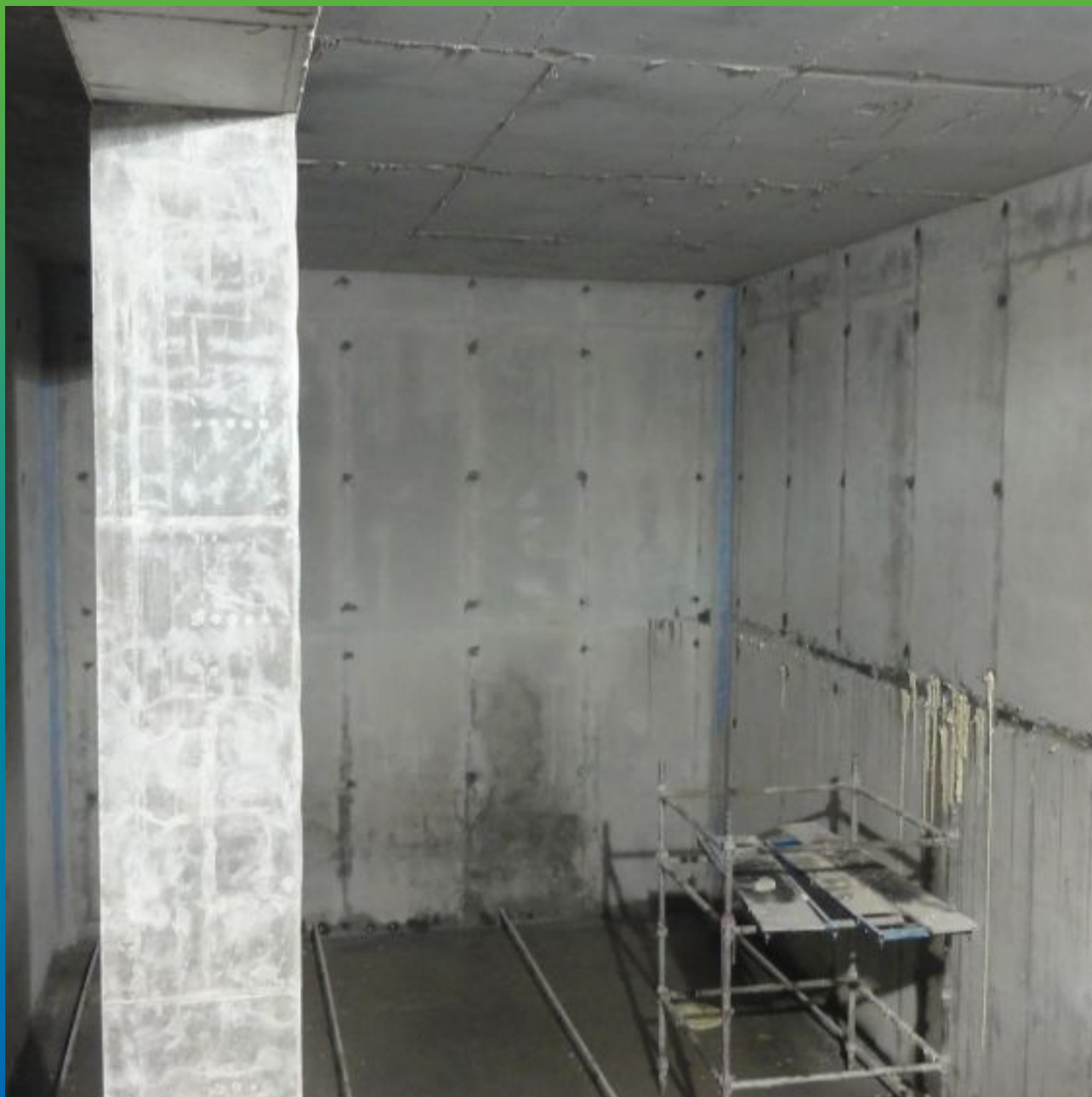
Монтаж гидроизоляционной ленты Манодил Гео
