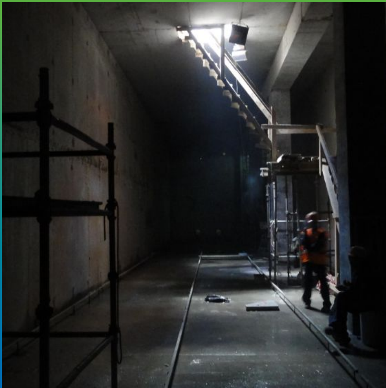
Общий вид резервуара
