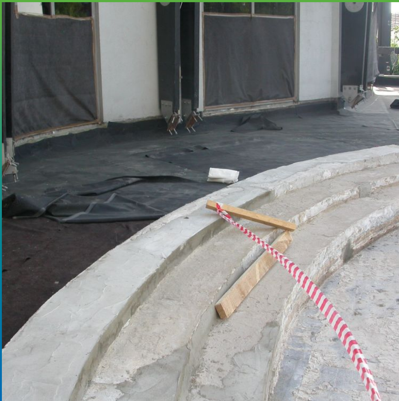
Монтаж мембраны Эластосил Т
