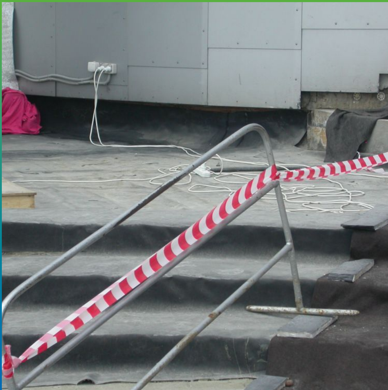
Монтаж мембраны Эластосил Т
