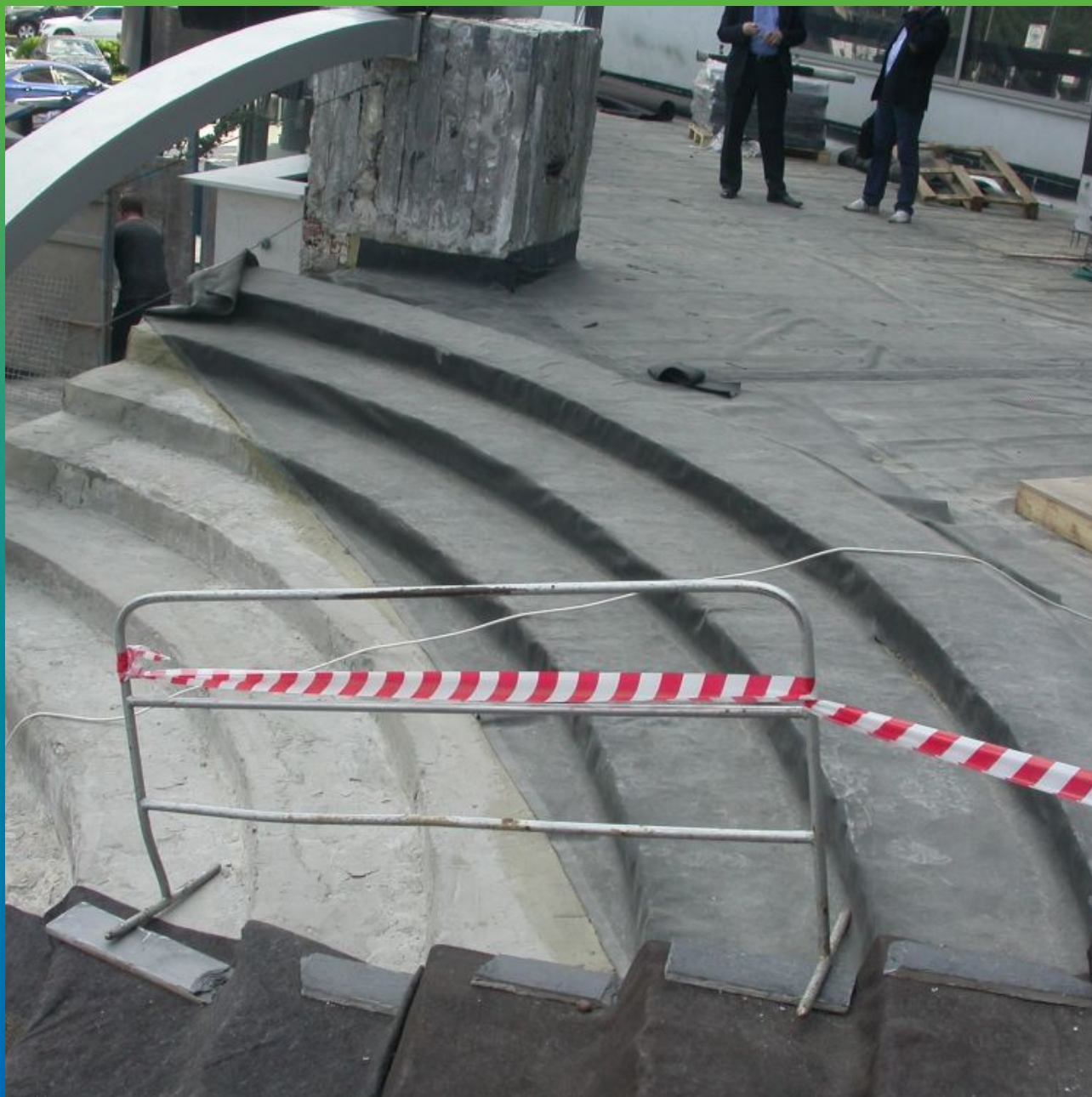
Монтаж мембраны Эластосил Т
