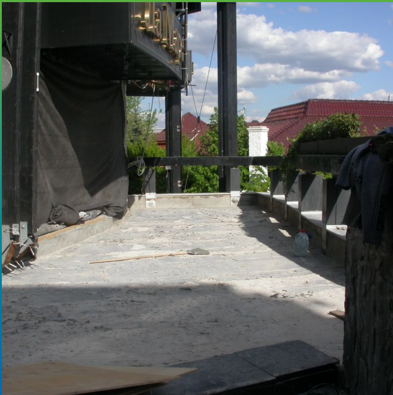
Подготовленное основание перед монтажом Эластосил Т
