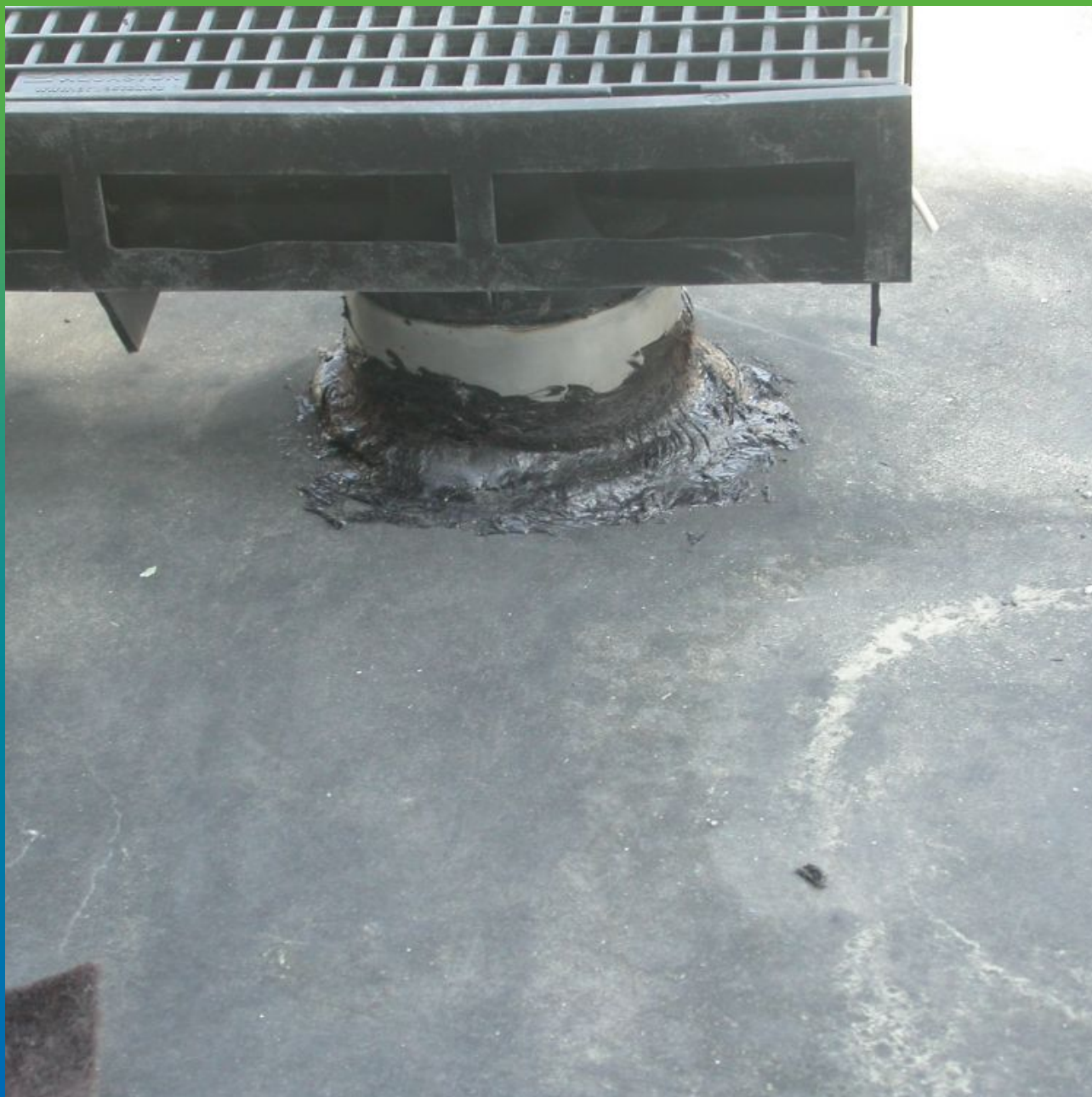
Устройство водоприемных воронок, нанесение герметика Витрафин Бонд
