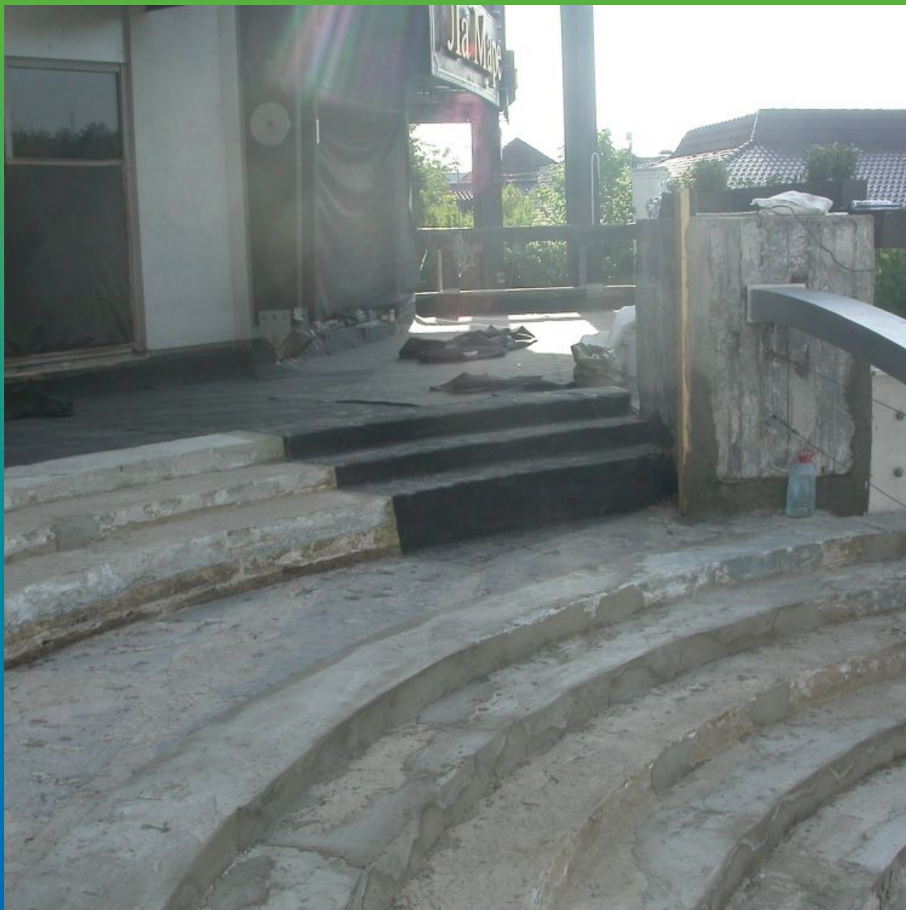
Монтаж мембраны Эластосил Т
