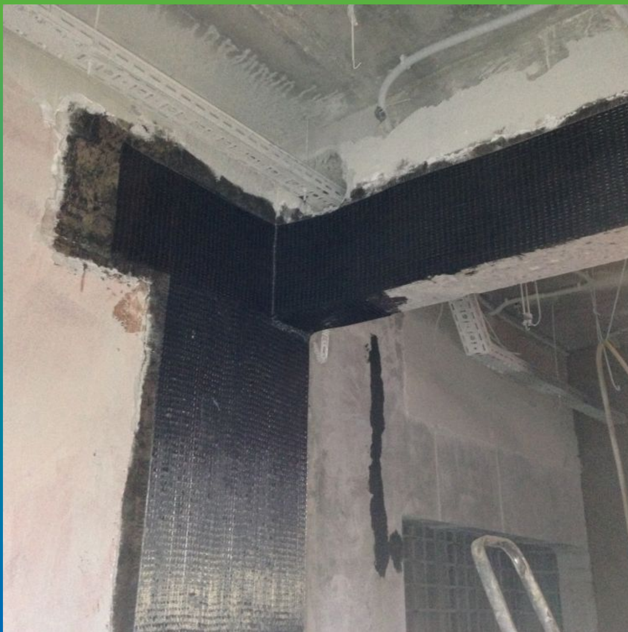
Монтаж Тайфо СЦХ-41
