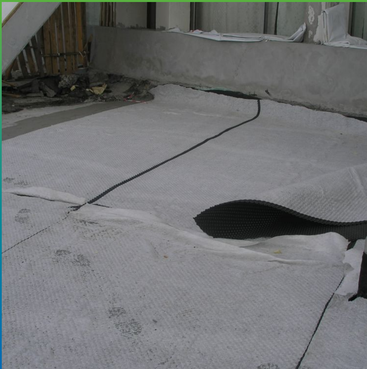
Укладка дренажного полотна Максдрейн 8ГТ
