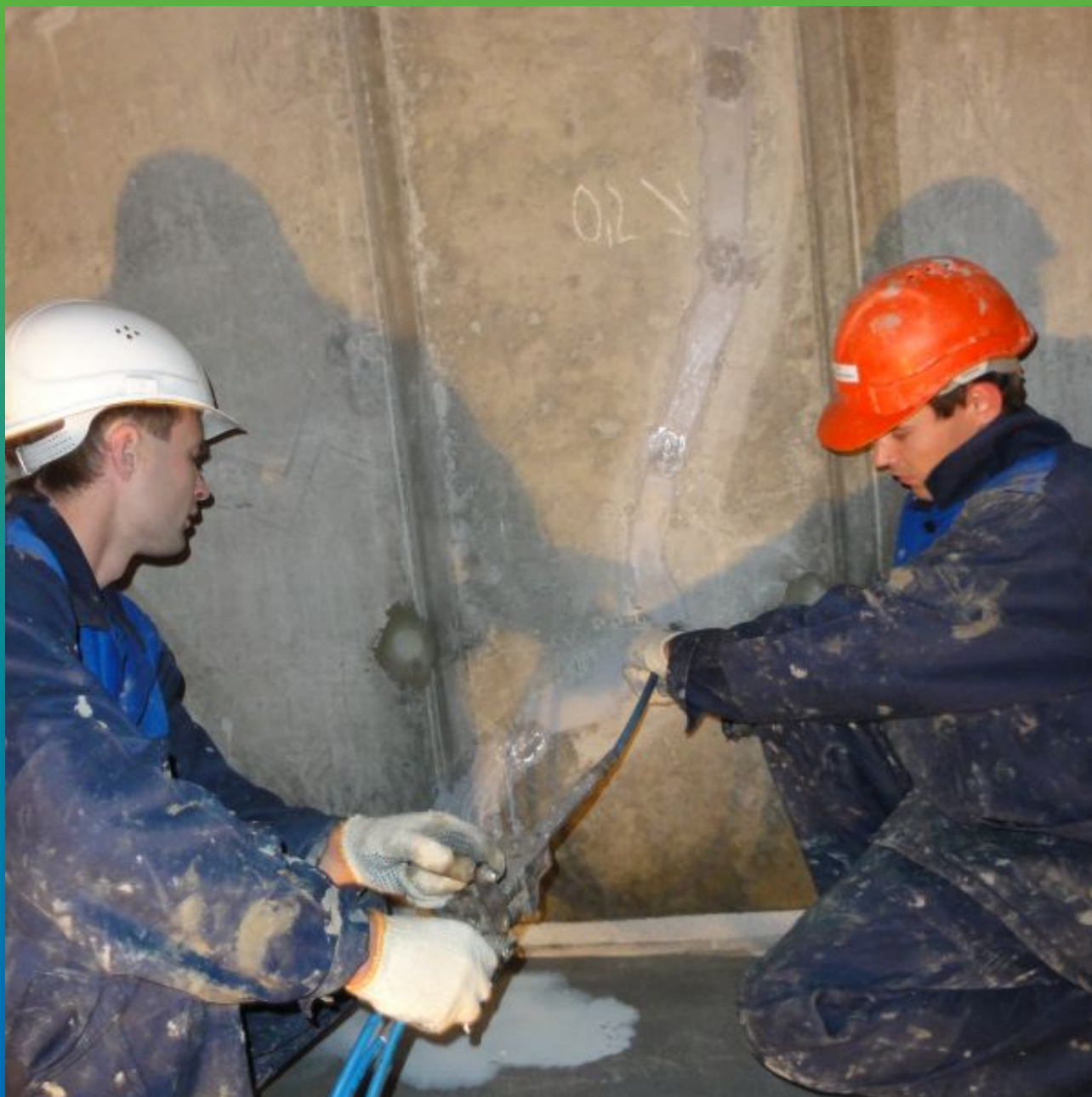
Процесс инъектирования
