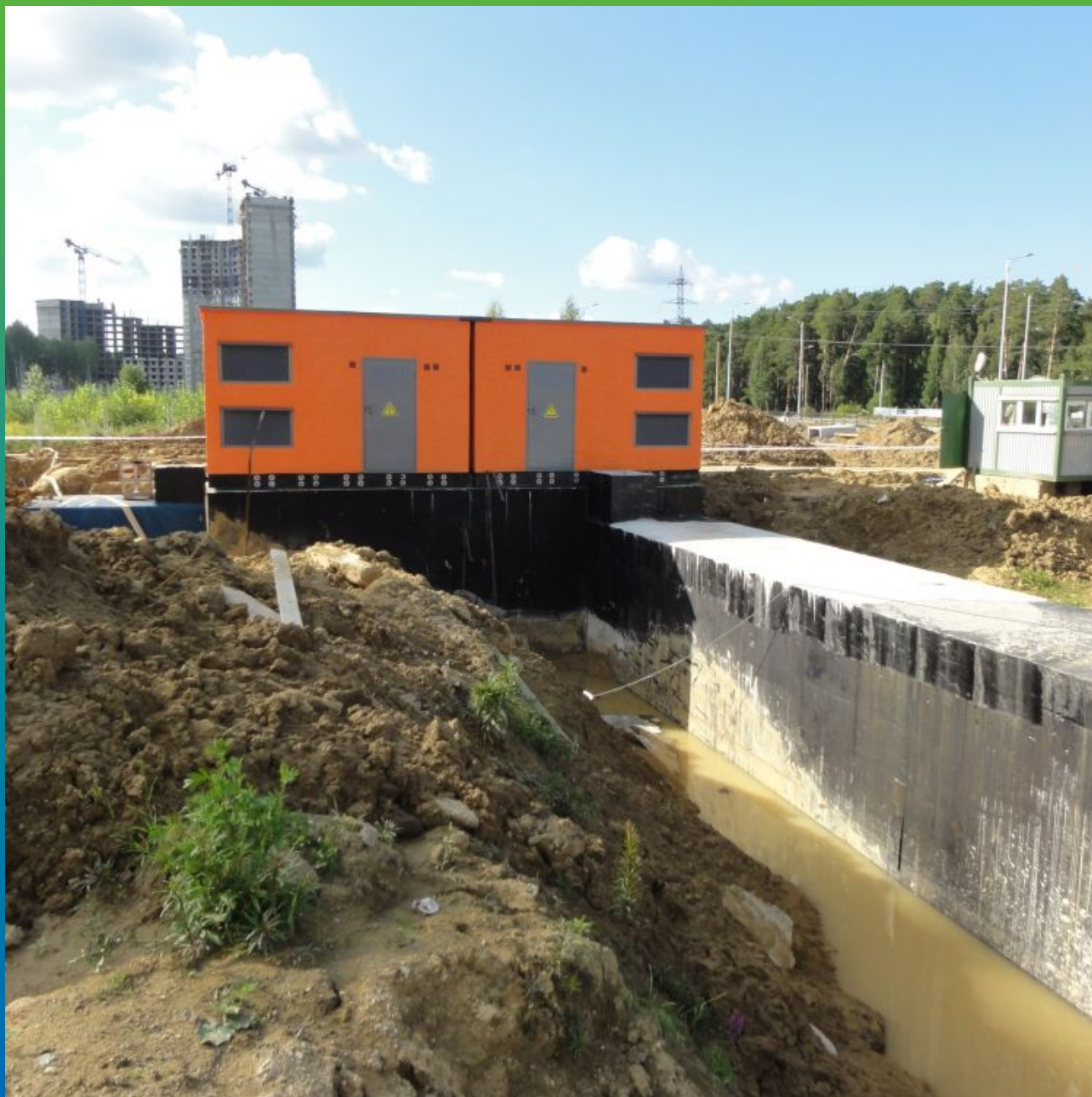
Вид кабельного канала
