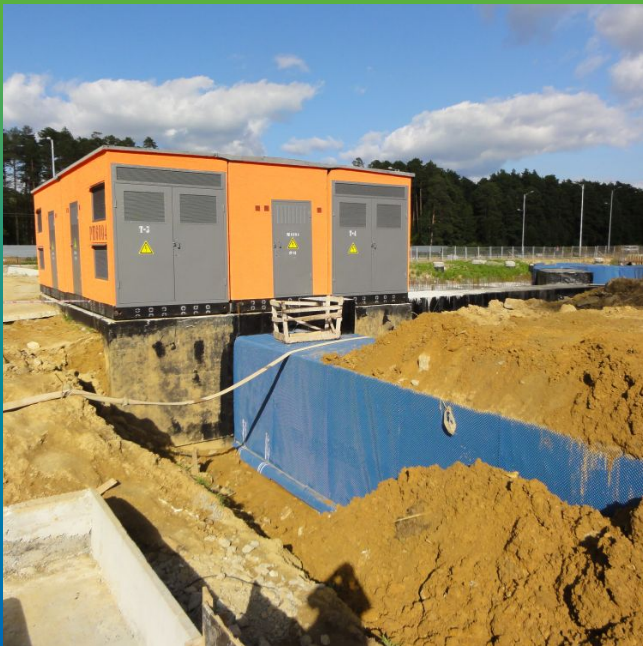
Финальный вид кабельного канала после монтажа Максдрейн 8
