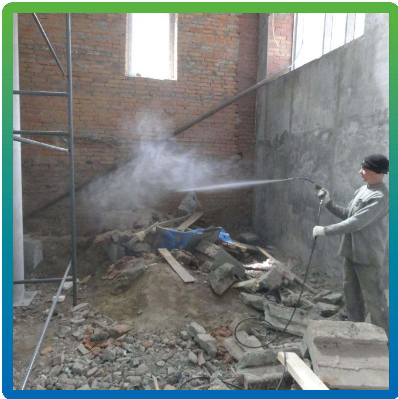
Проверка работоспособности насоса
