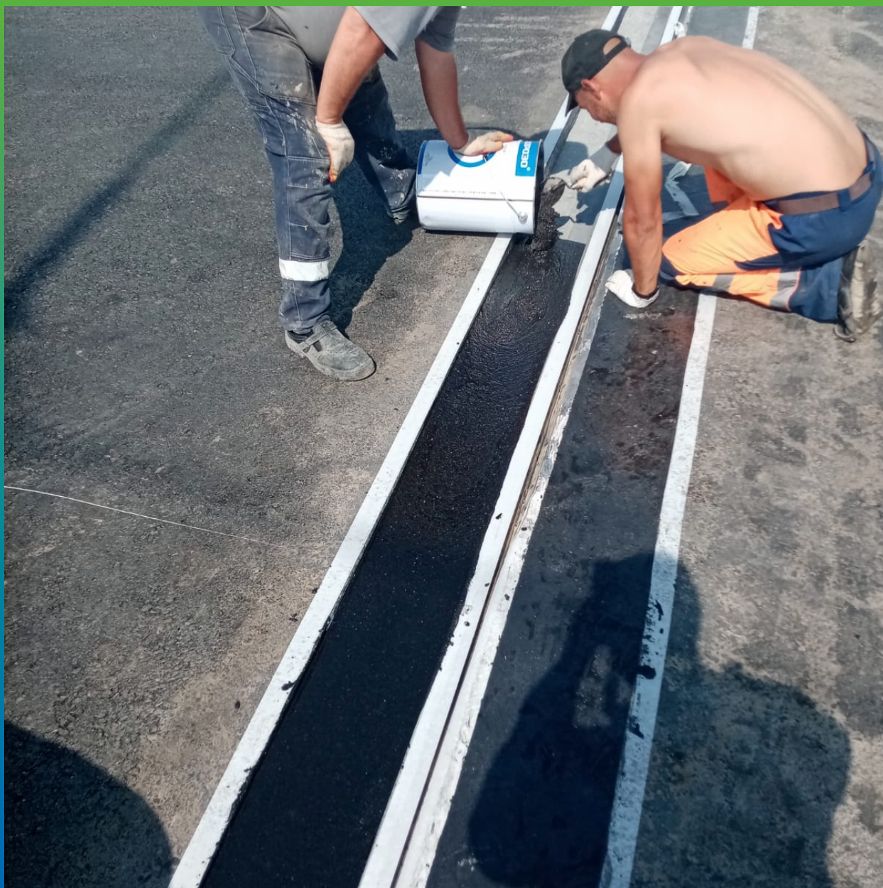
Укладка второй половины шва
