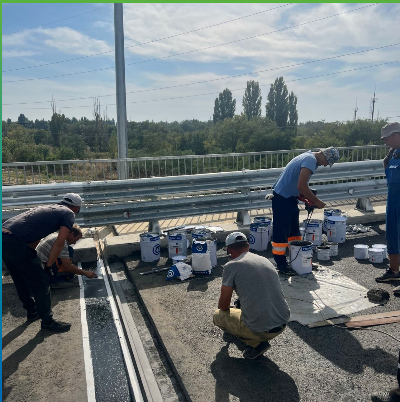
Начало укладки Манопура 336
