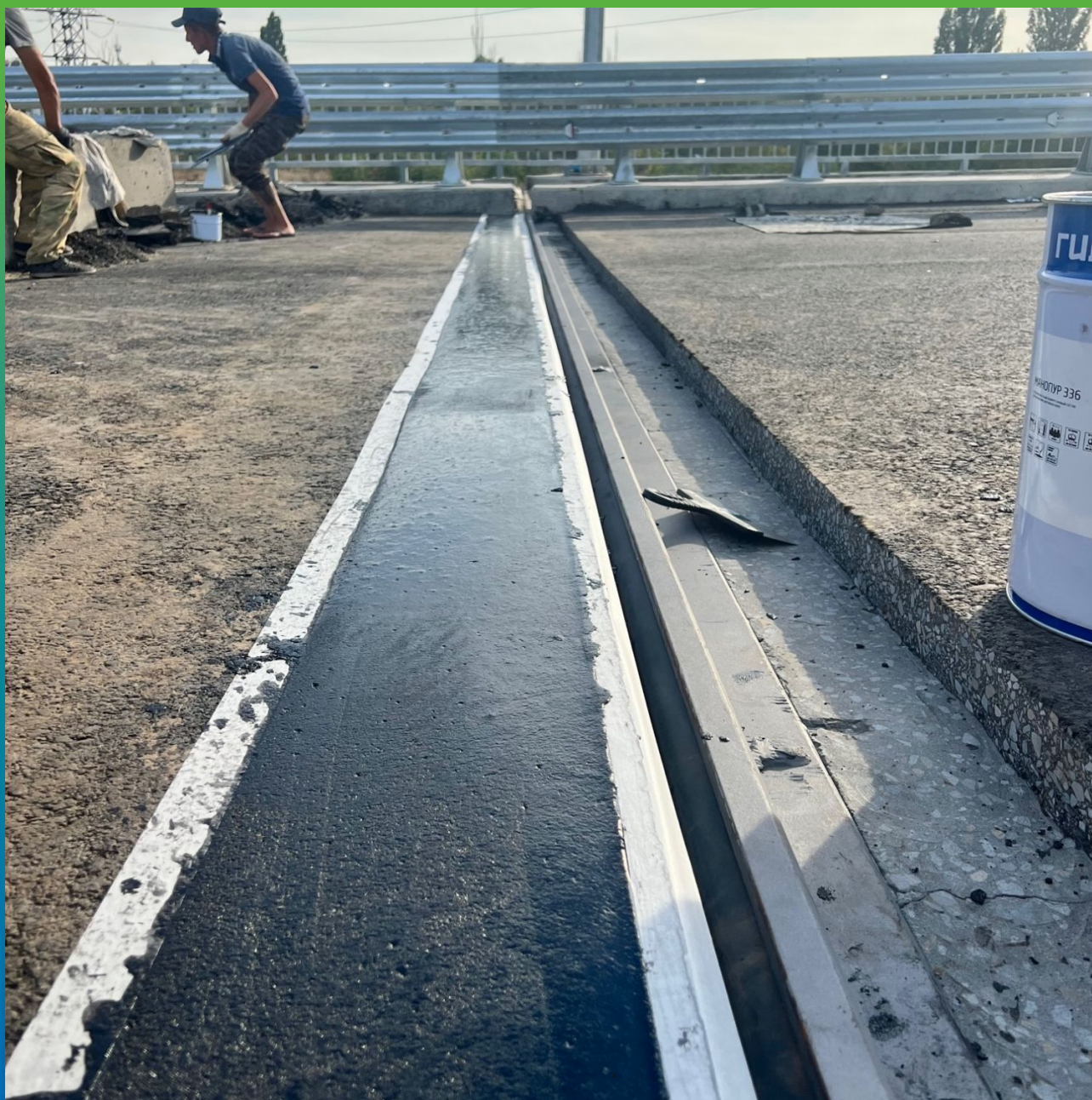
Общий вид половины швы после укладки и заглаживания
