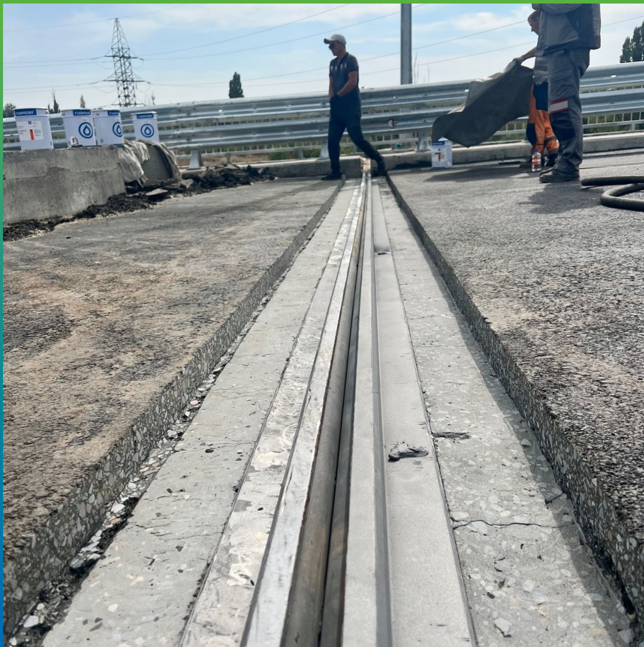
Вид подготовленного шва. Слева болгарка, справа пескоструй
