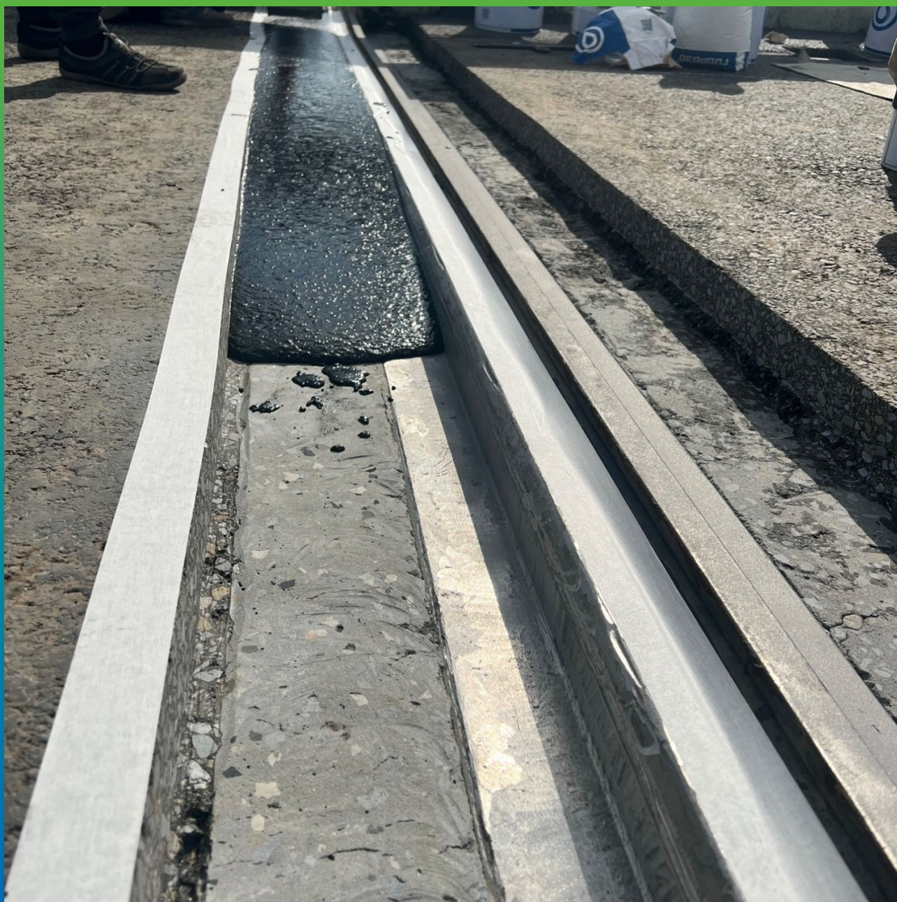
Рабочая зона, начало укладки Манопура 336
