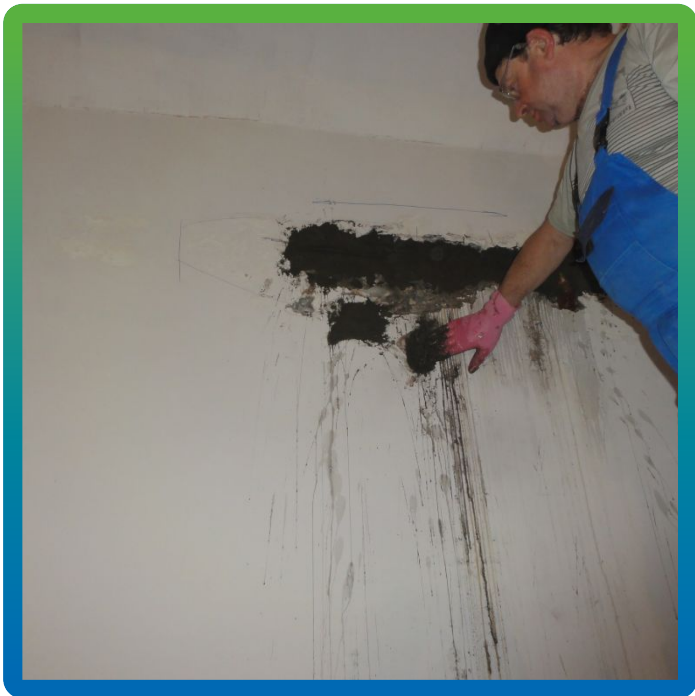
Зачеканка трещины с помощью Максбетон
