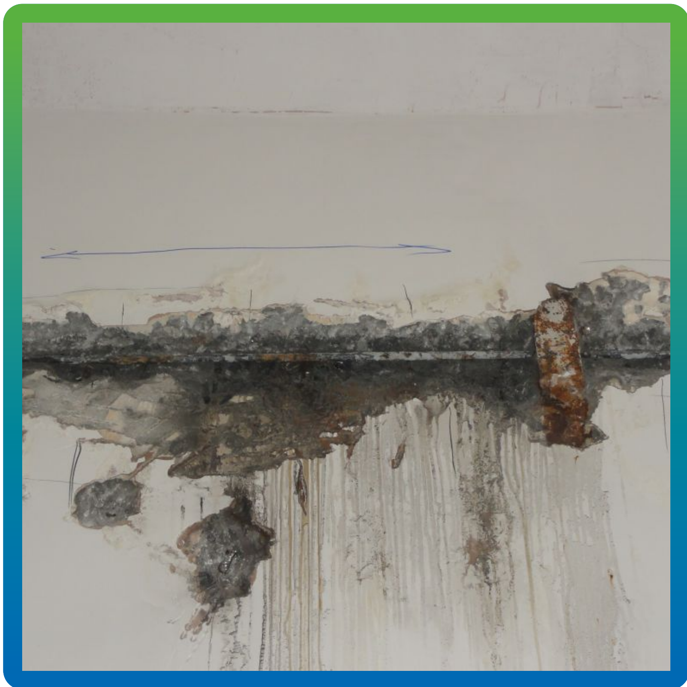
Расширяющаяся трещина
