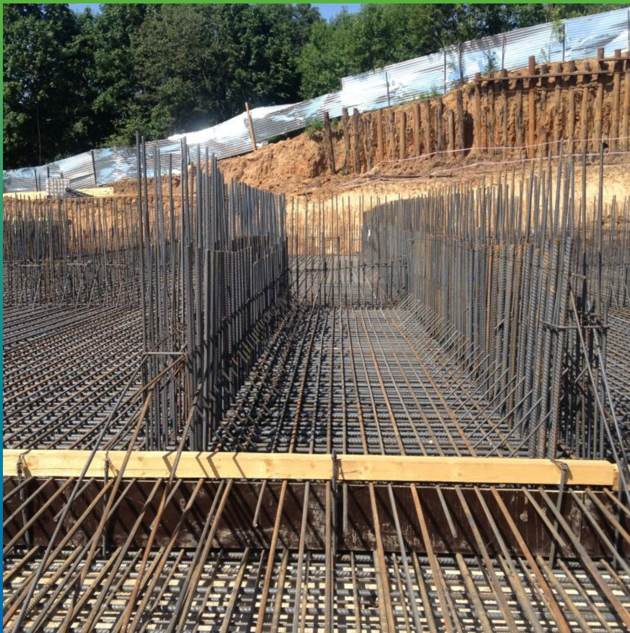
Вид объекта до начала гидроизоляционных работ
