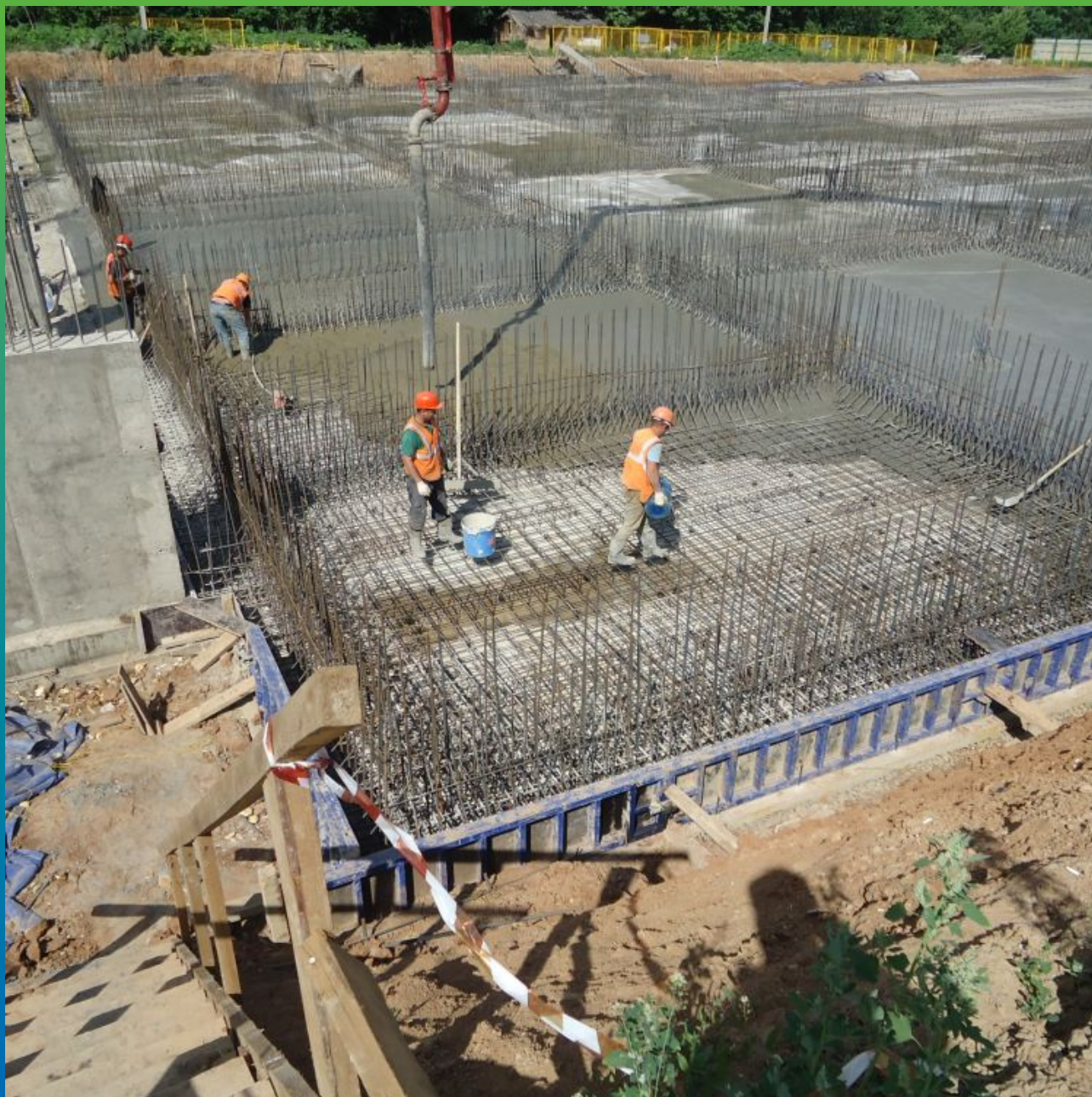
Увлажнение набетонки перед просыпкой материала Макссил Супер
