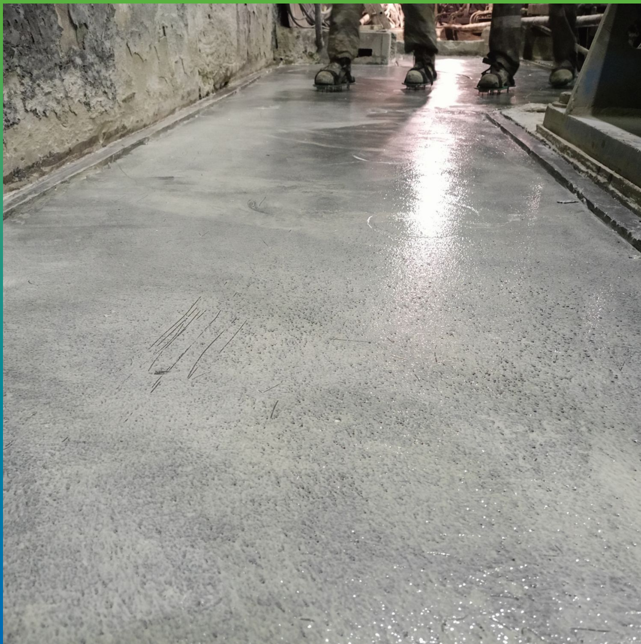
Вид загнутовоного основания цементн-полиуретановис составом ДенсТоп ПМ 600
