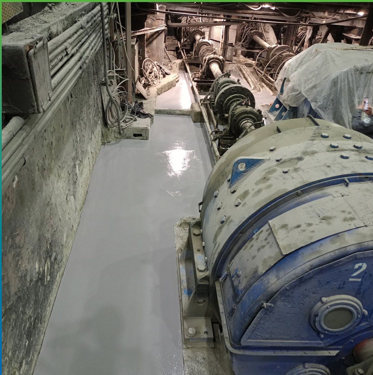
Вид нанесенного цементн-полиуретанового покрытия ДенсТоп ПМ 605 Тровел
