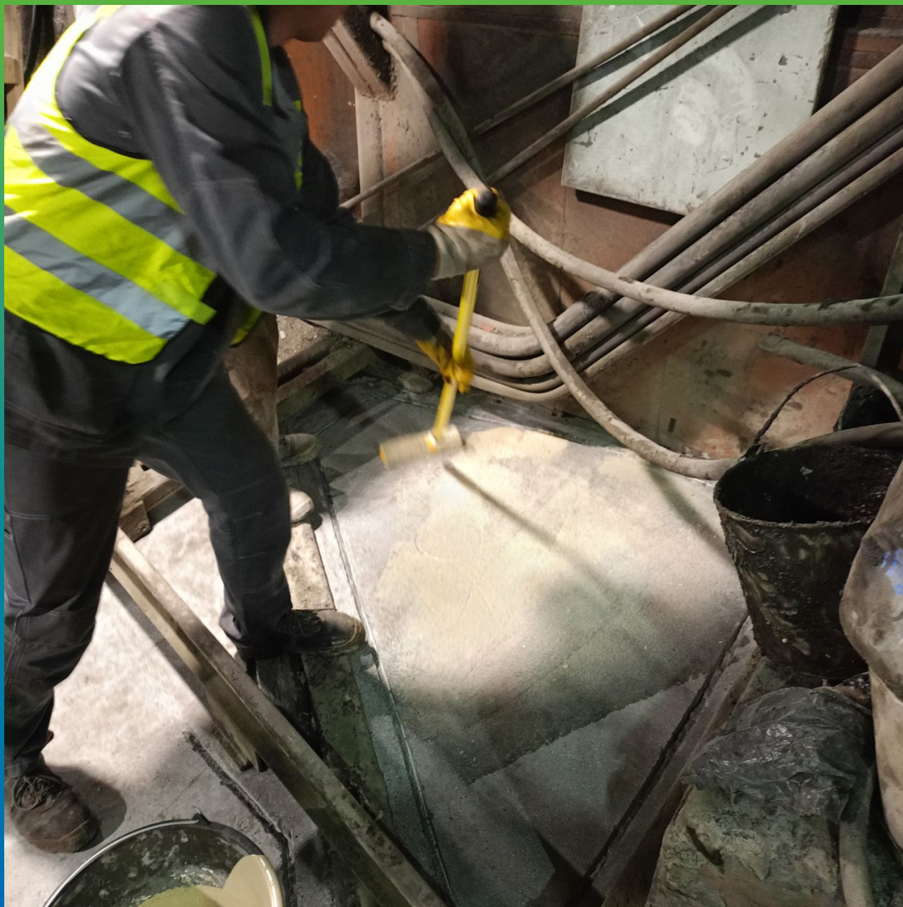
Нанесение цементно-полиуретановый грунтовочного состава ДенсТоп ПМ 600
