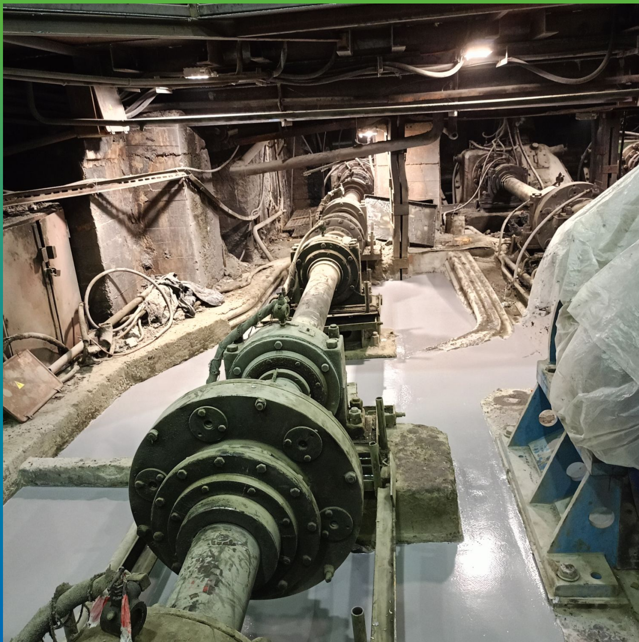
Вид нанесенного цементн-полиуретанового покрытия ДенсТоп ПМ 605 Тровел
