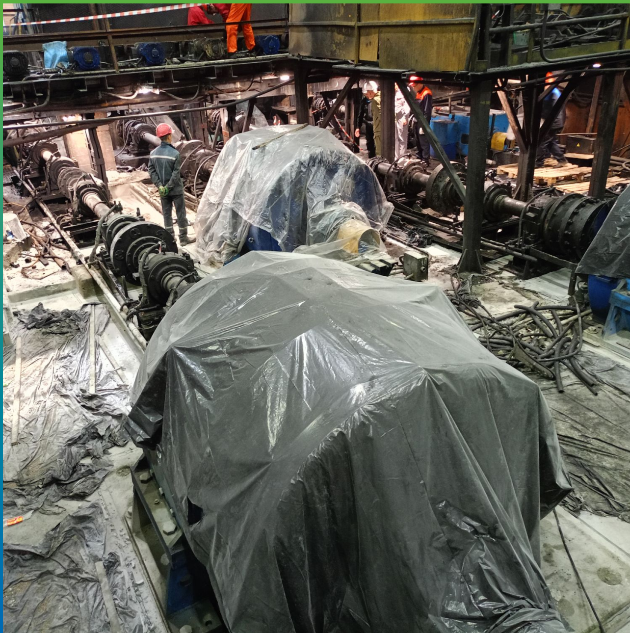
Вид подготовленного основания для последующего нанесения ДенТоп ПМ 600
