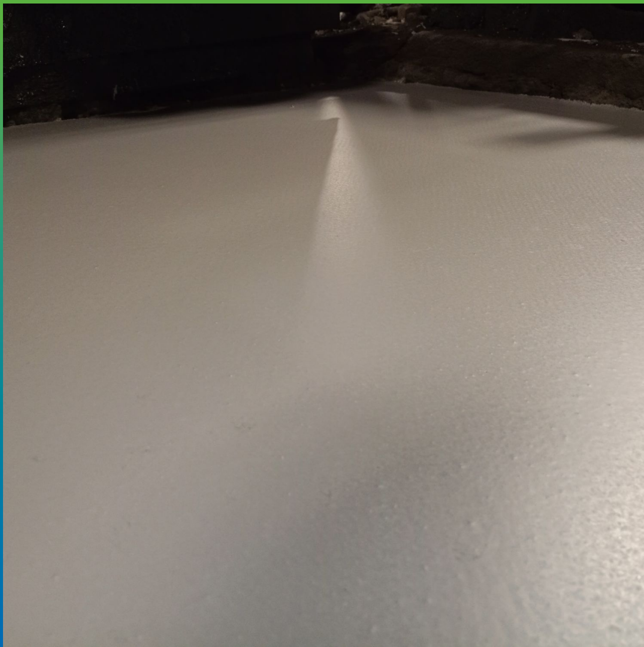
Вид нанесенного цементн-полиуретанового покрытия ДенсТоп ПМ 605 Тровел
