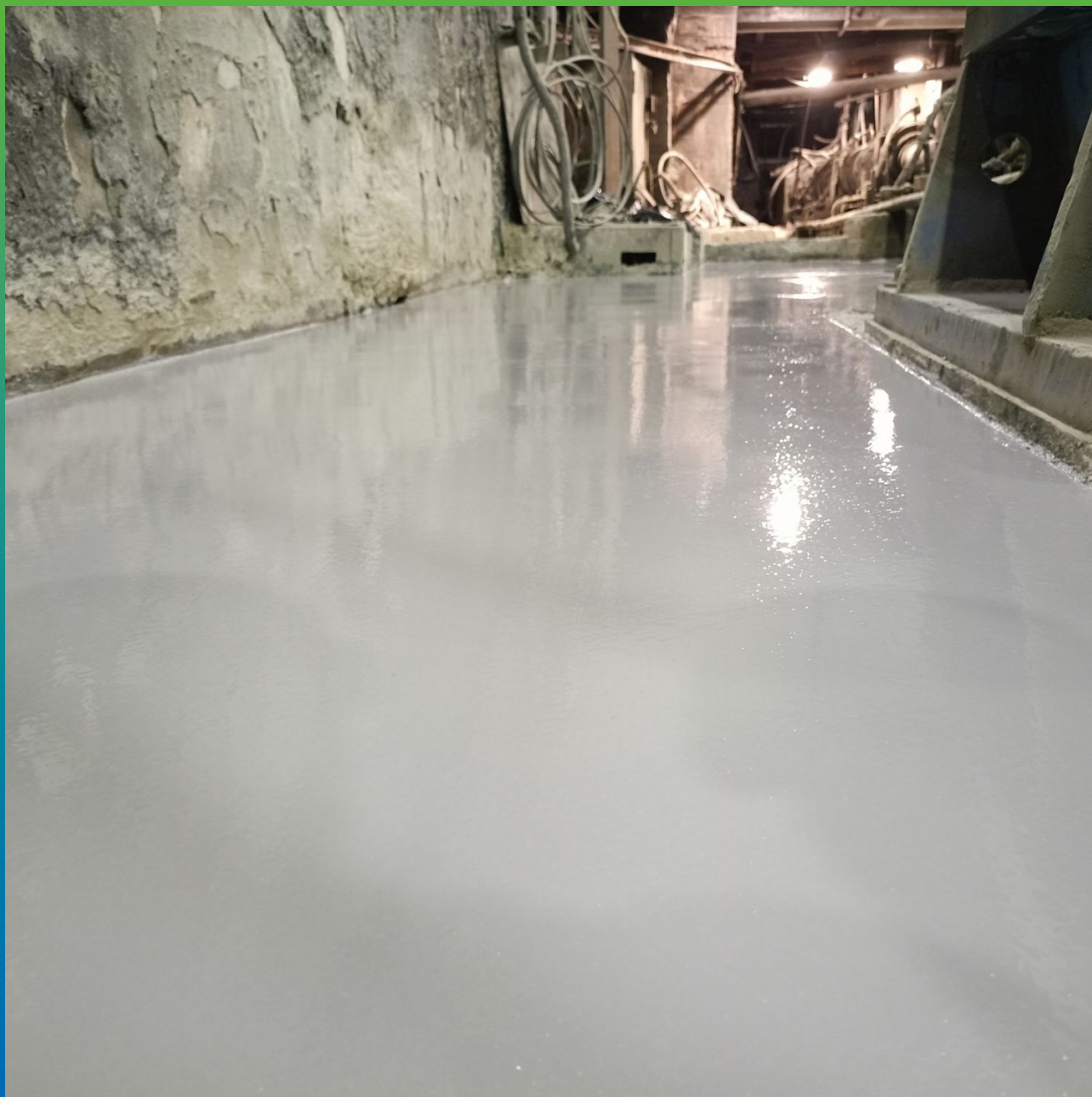
Вид нанесенного цементн-полиуретанового покрытия ДенсТоп ПМ 605 Тровел
