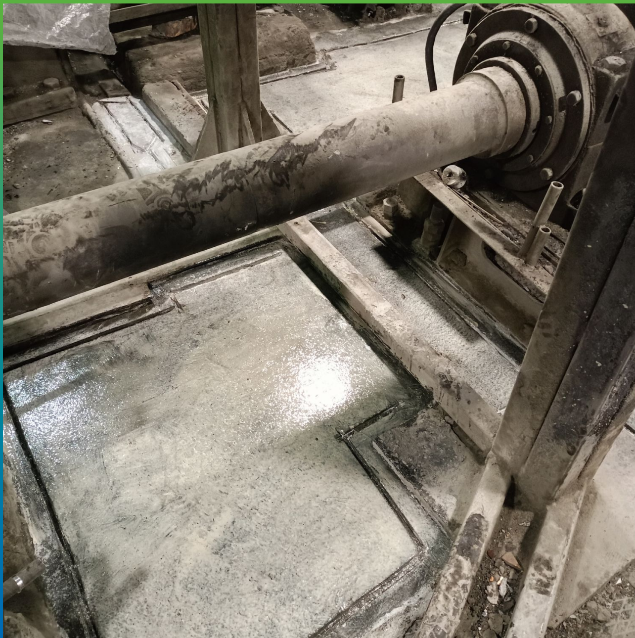
Вид загрузочного основания цементно-полиуретановым составом ДенТоп ПМ 600
