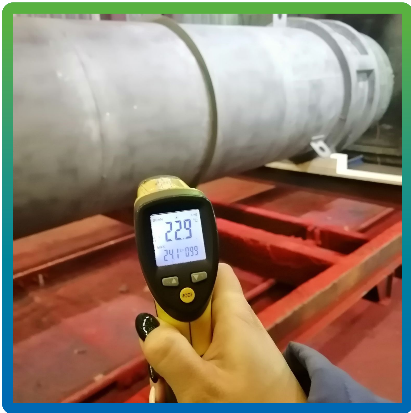
Замер температуры основания силоса, перед нанесением грунтовочного слоя ДенсТоп ПУ 113
