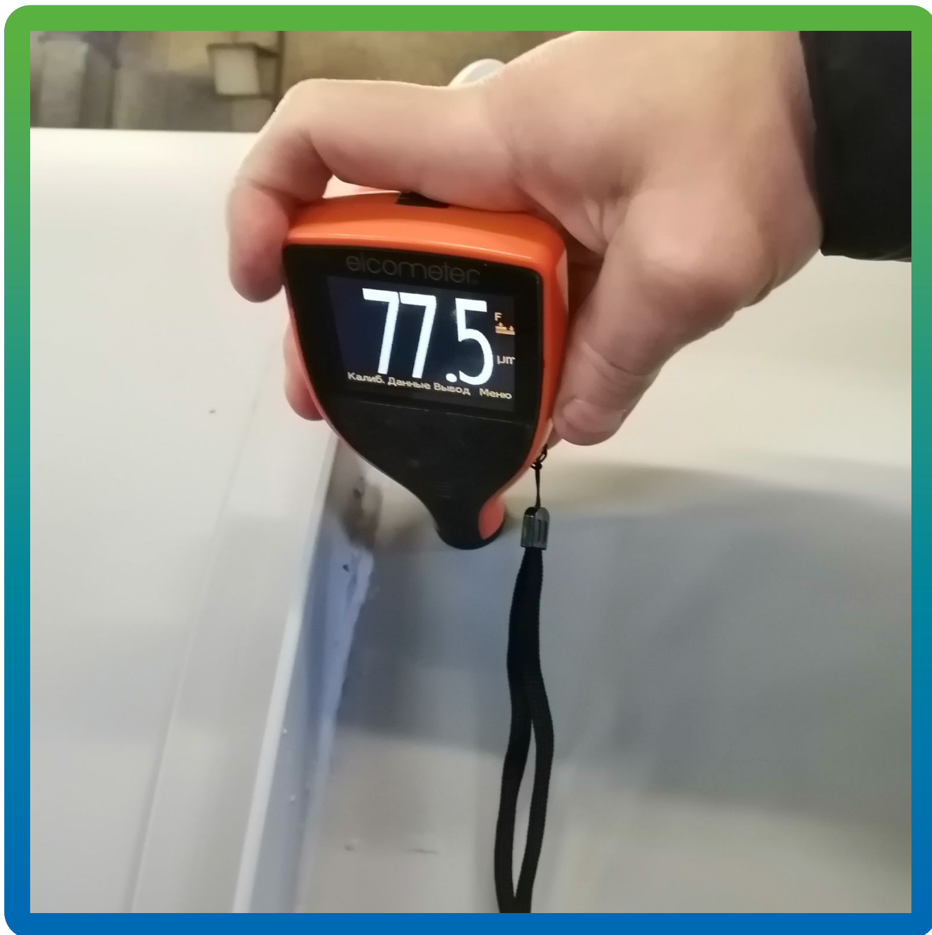
Контроль качества, замер толщины сухой пленки грунтовочного слоя, перед нанесением промежуточного слоя ДенсТоп ПУ 302
