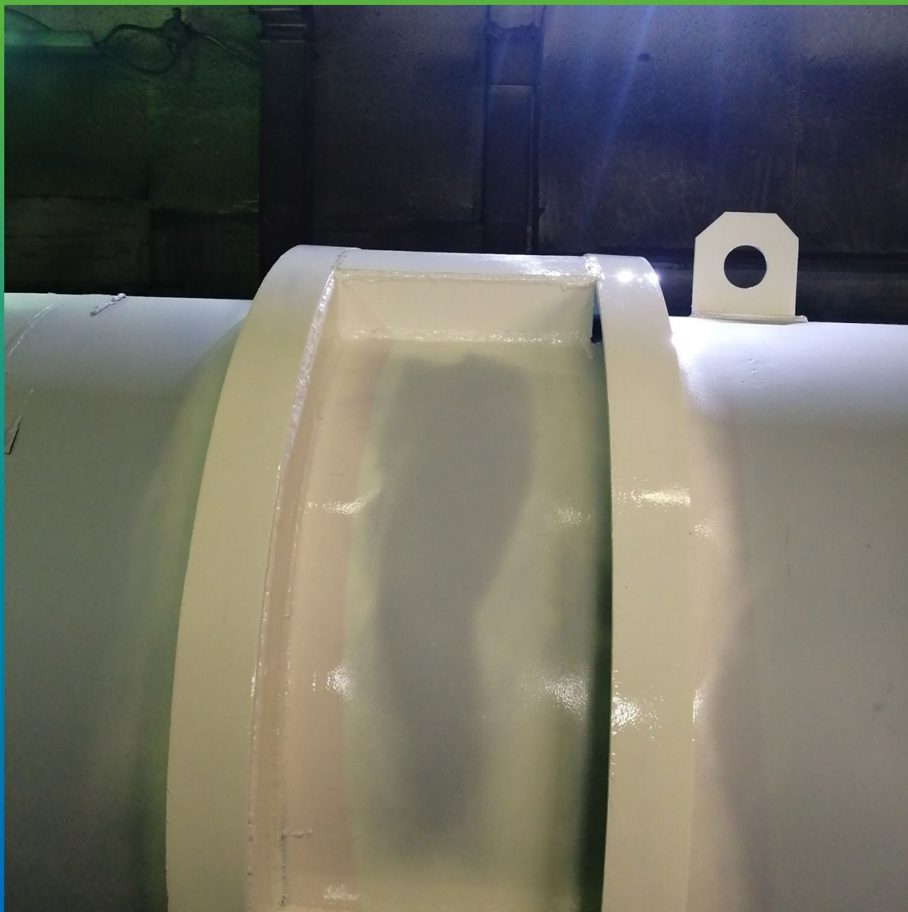
Нанесение промежуточного слоя ДенсТоп ПУ 302 в трудно доступные места, рёбра жесткости
