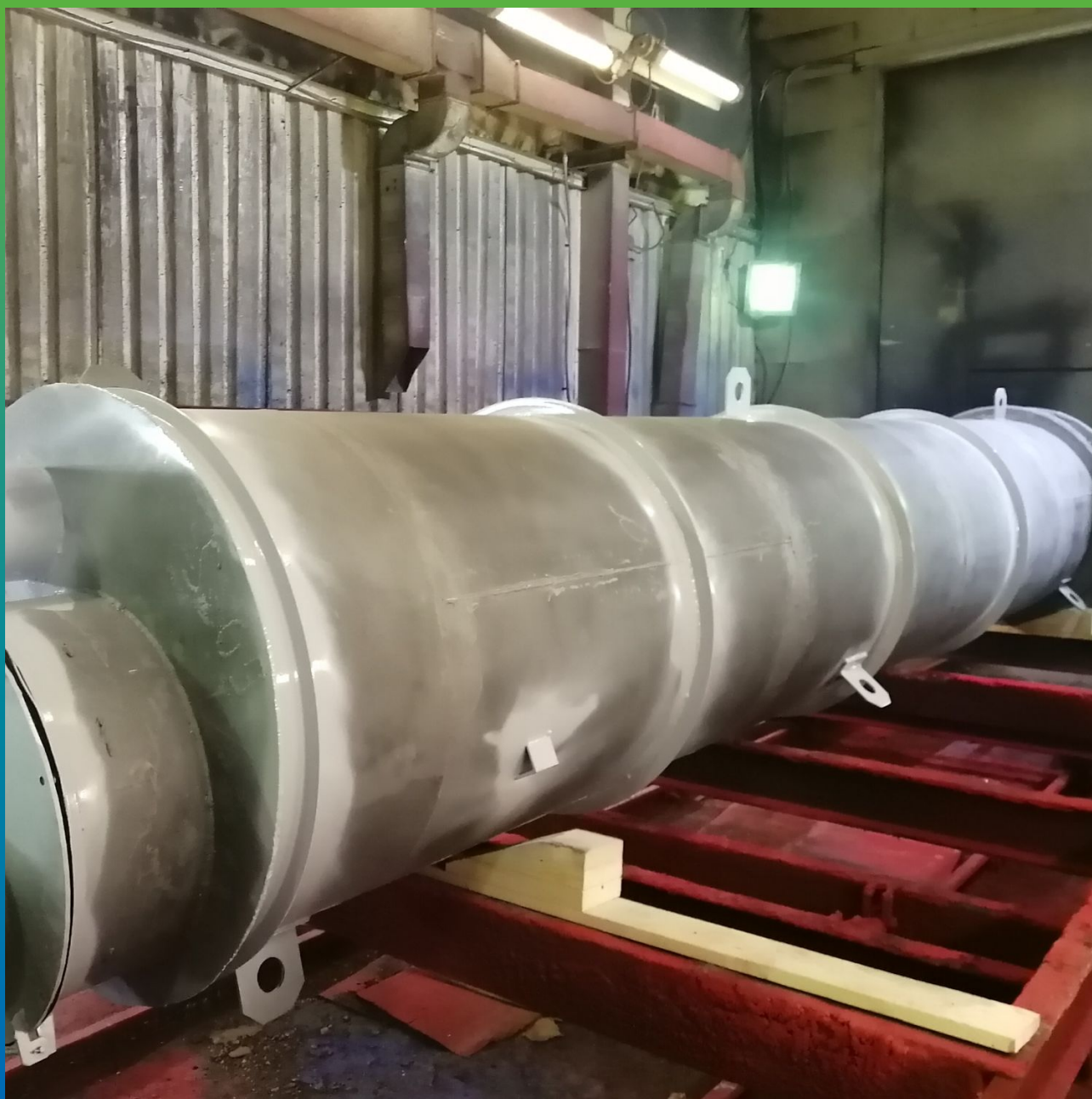
Нанесение грунтовочного слоя ДенсТоп ПУ 113 в трудно доступные места, рёбра жесткости
