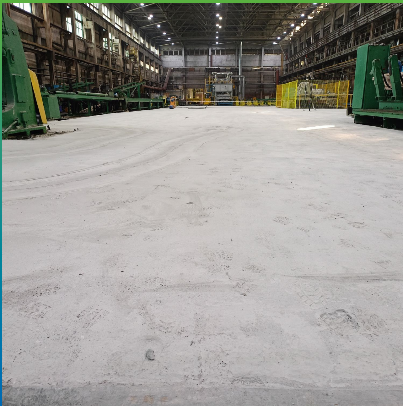
Шлифовка бетонного основания
