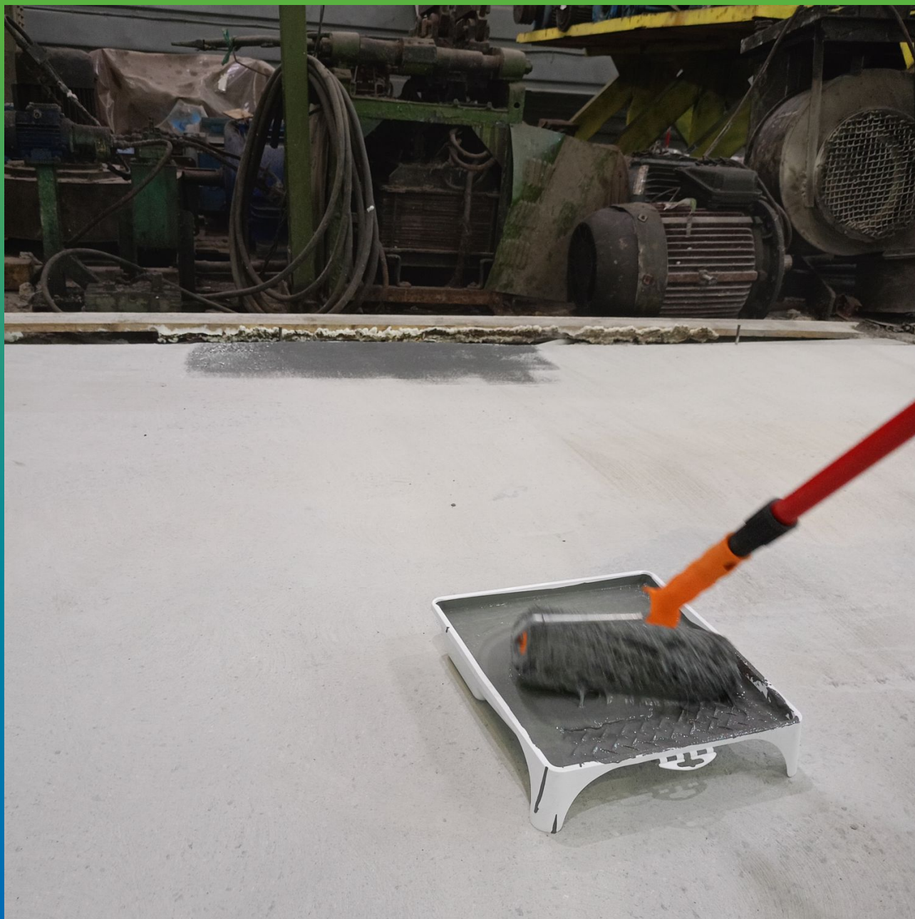
Ручное нанесение 1 слоя состава ДенсТоп ЭП 205
