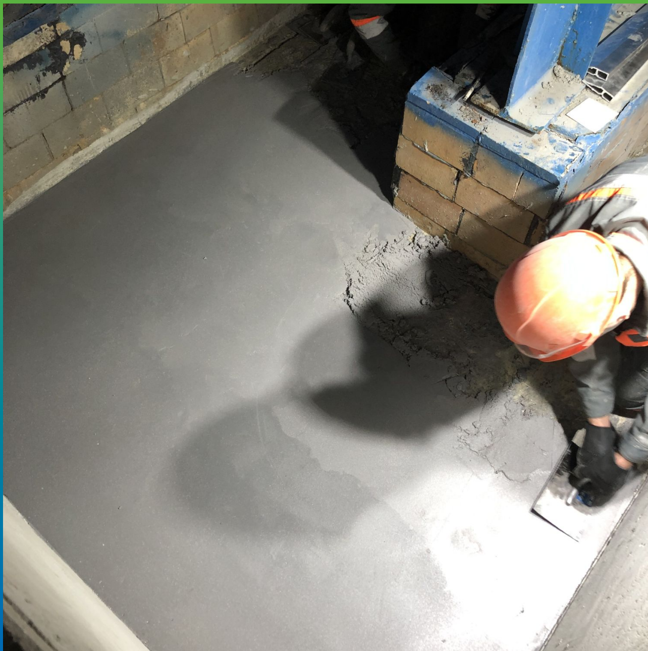
Разравнивание материала кельмой
