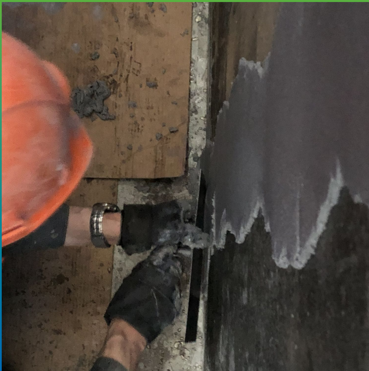
Разравнивание материала кельмой на вертикальной поверхности
