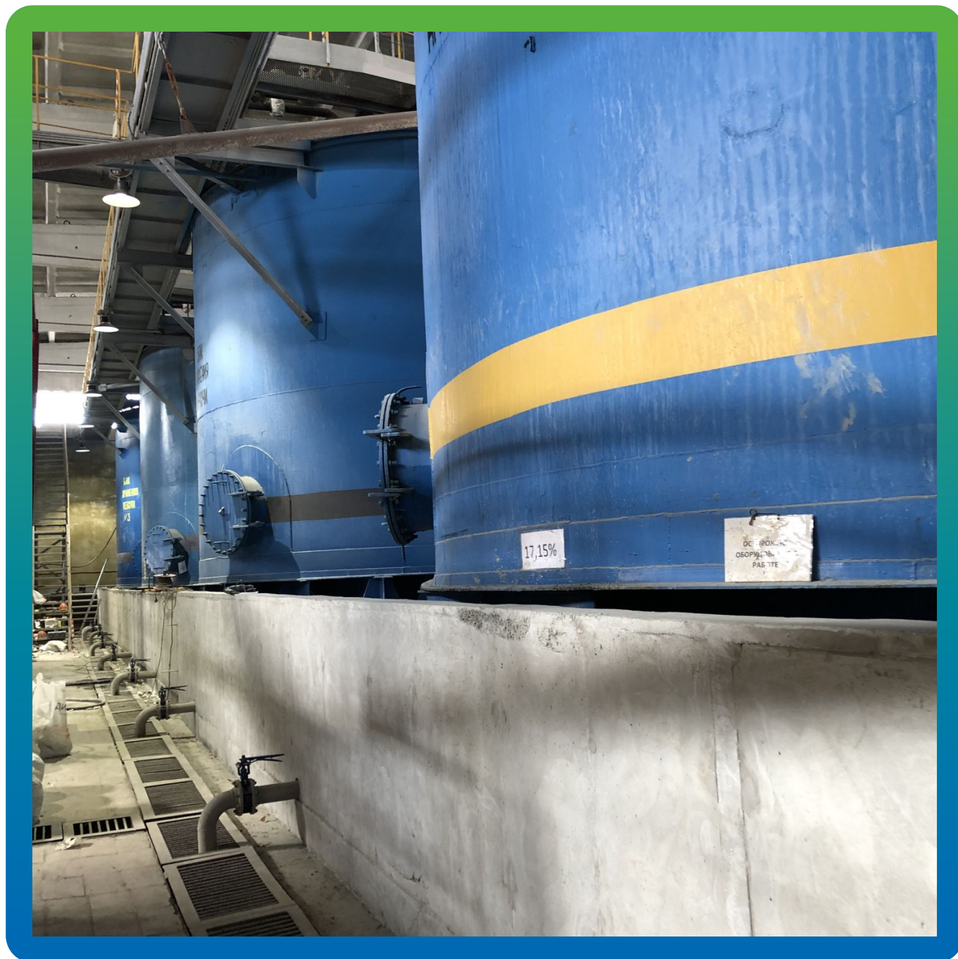
Вид участка работ по хим защите
