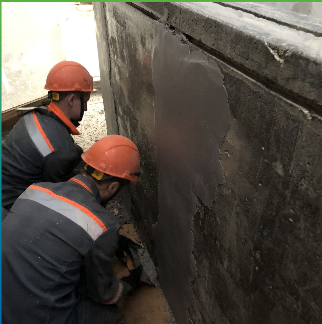
Укладка материала на вертикаль
