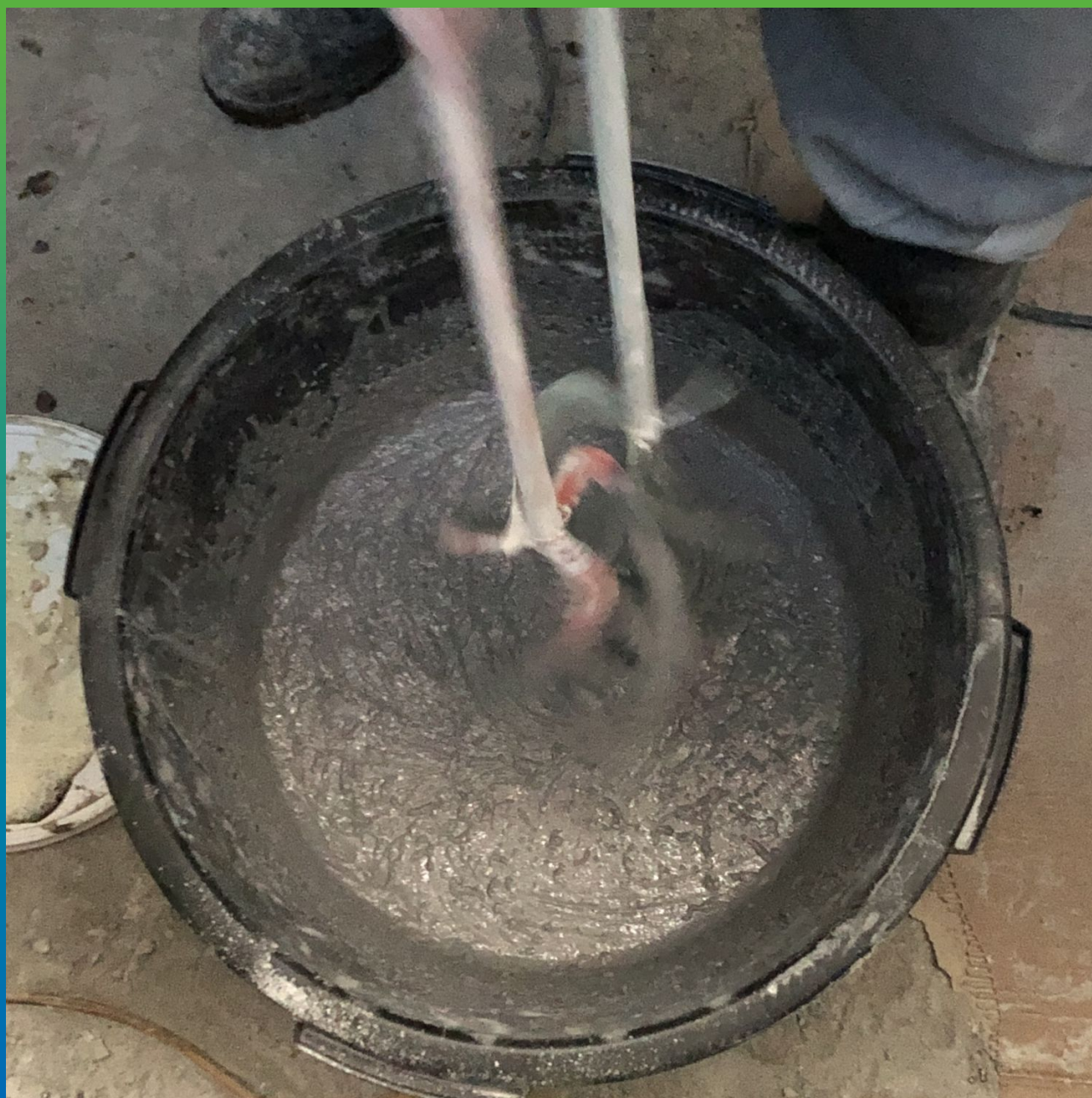
Смешивание компонентов основного покрытия
