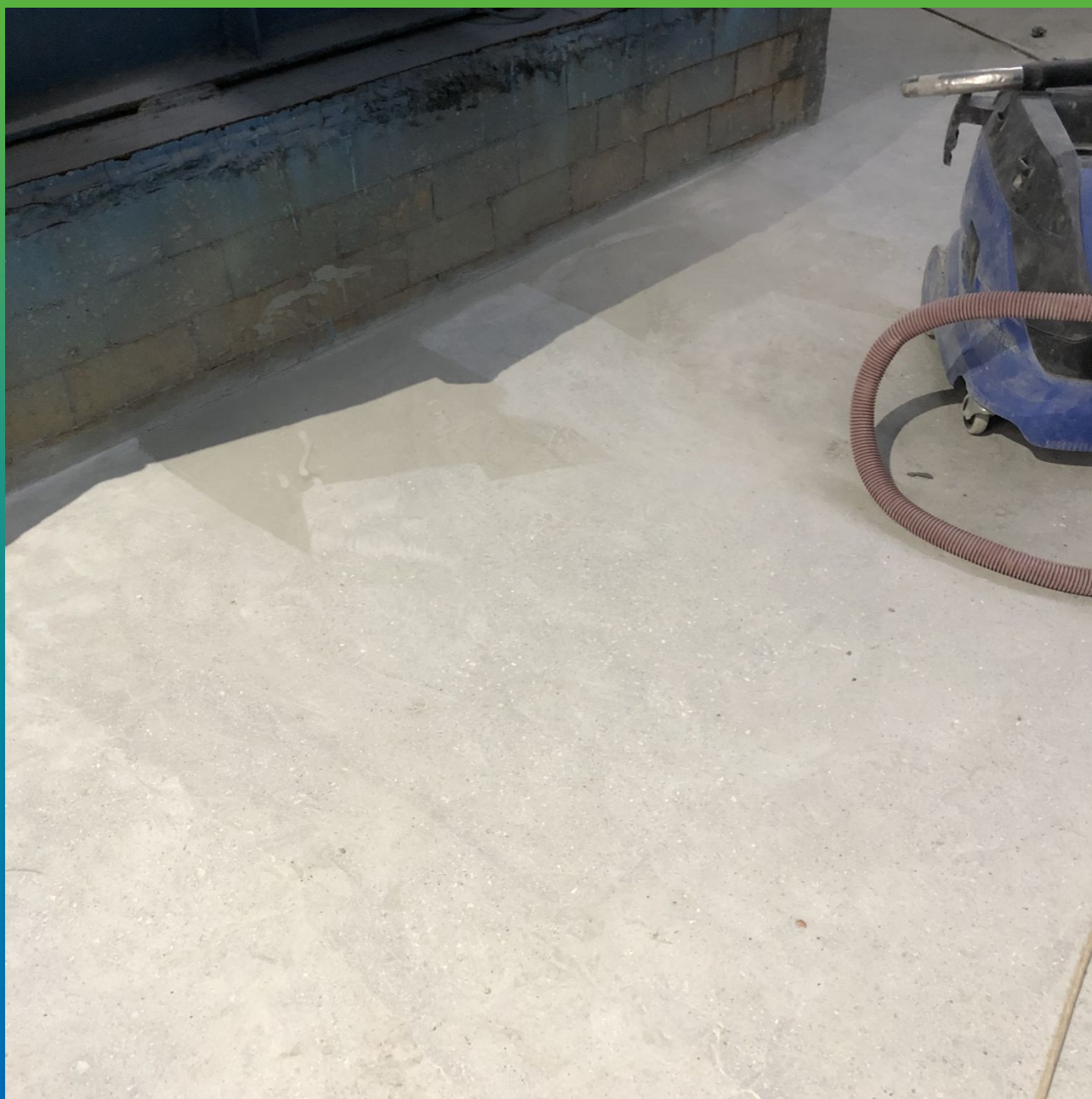
Подготовка основания. Шлифовка. Нарезка анкерных пропилов
