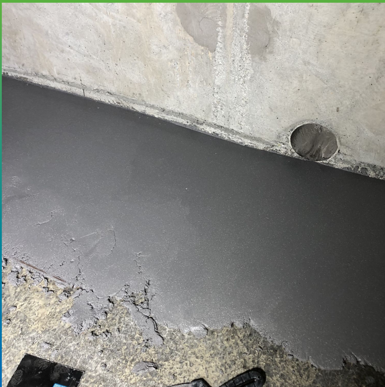
Укладка материала на горизонтальную поверхность. Другой вид
