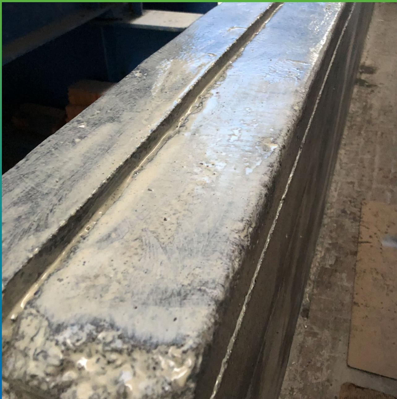
Загрунтованная поверхность ДенсТоп ПМ 600
