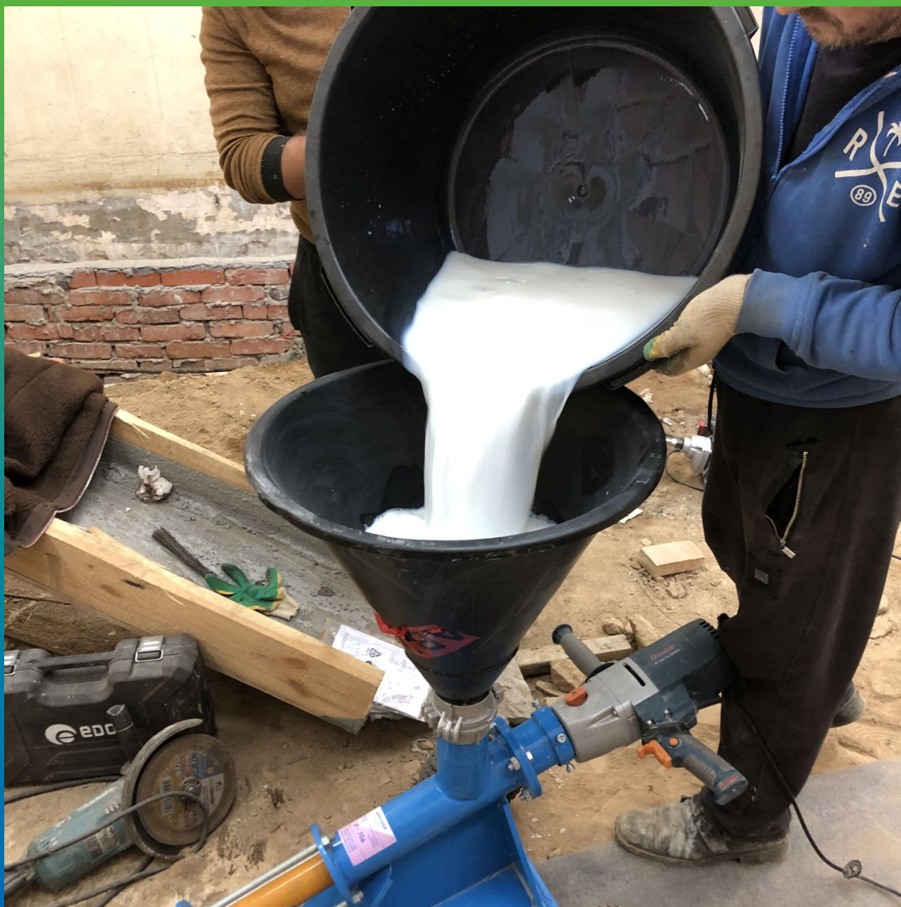
Загрузка готовой микроэмульсии в бункер оборудования
