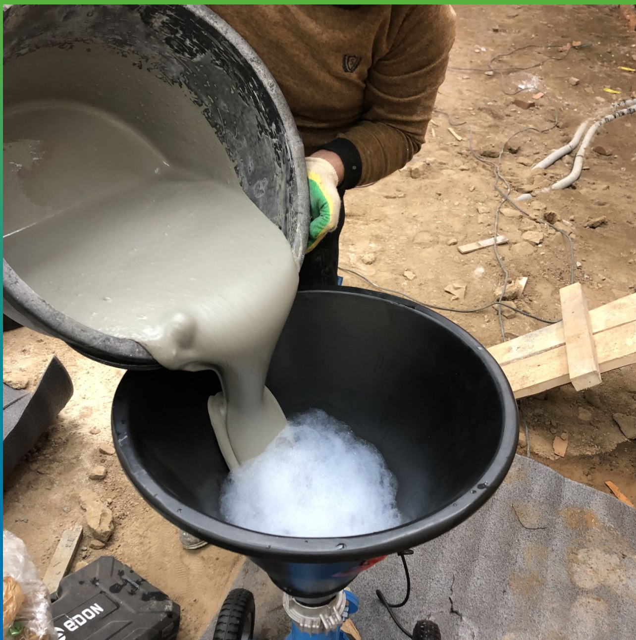
Заливка готового состава в бункер оборудования
