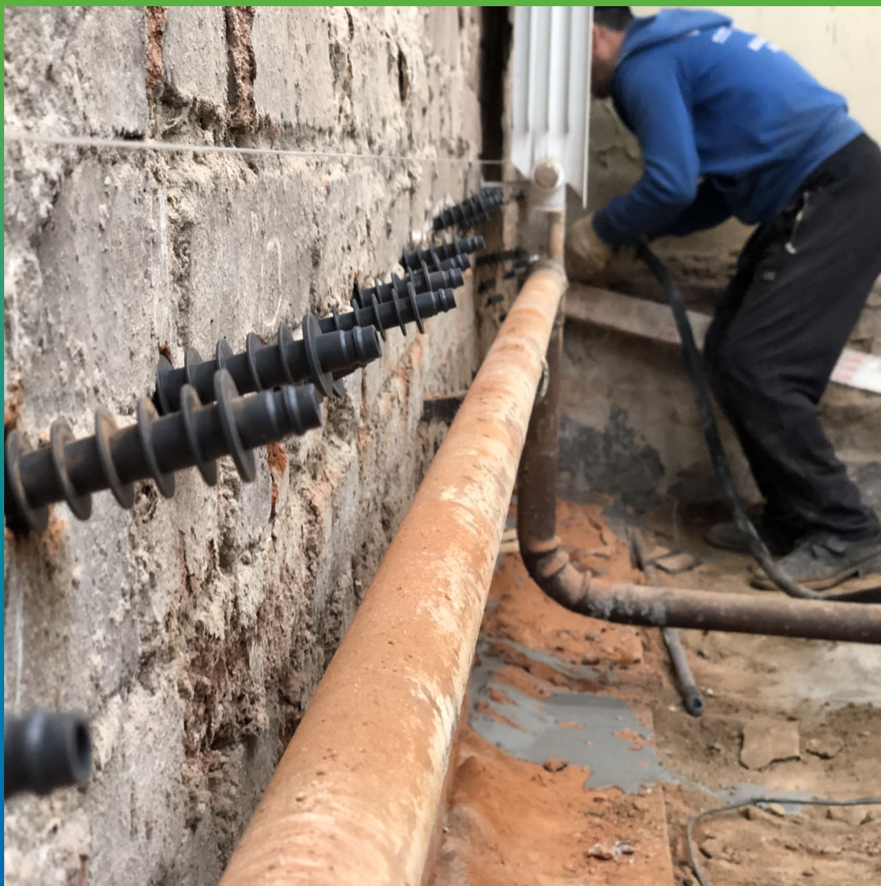
Процесс инъектирования. Другой ракурс
