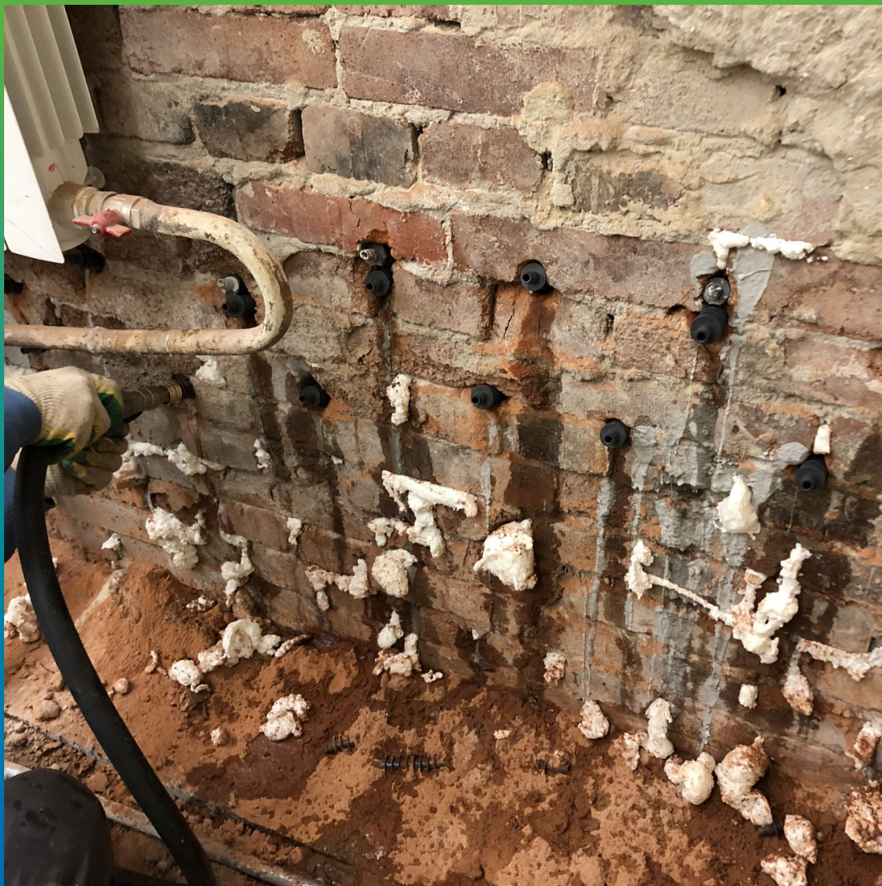
Процесс инъектирования гидроизоляционного состава Маноксан 150
