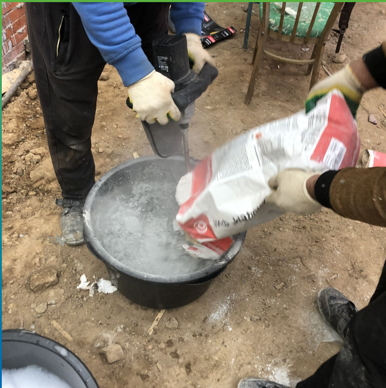
Замешивание инъекционного минерального состава Маноцем Фил
