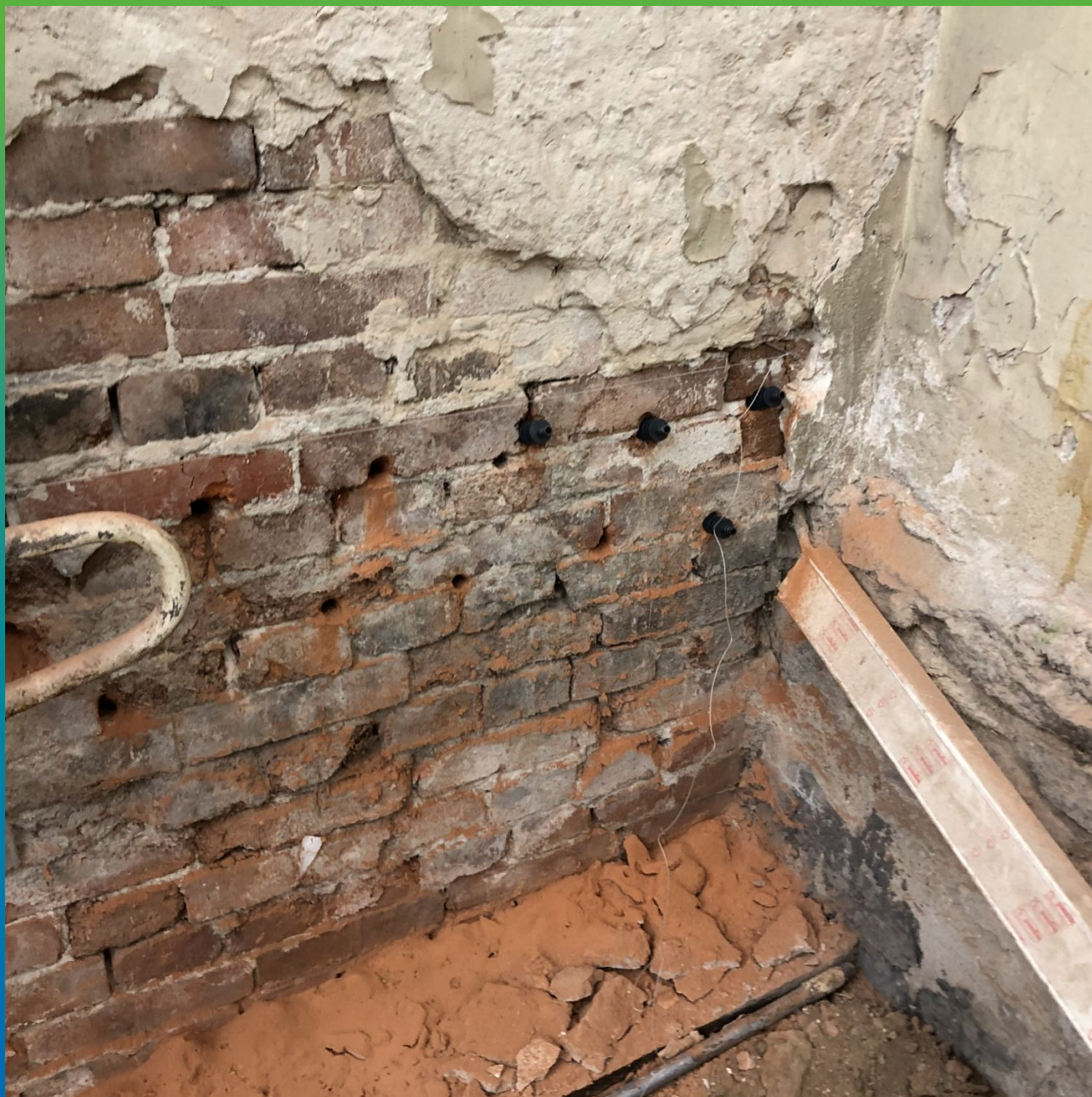
Бурение отверстий и их подготовка
