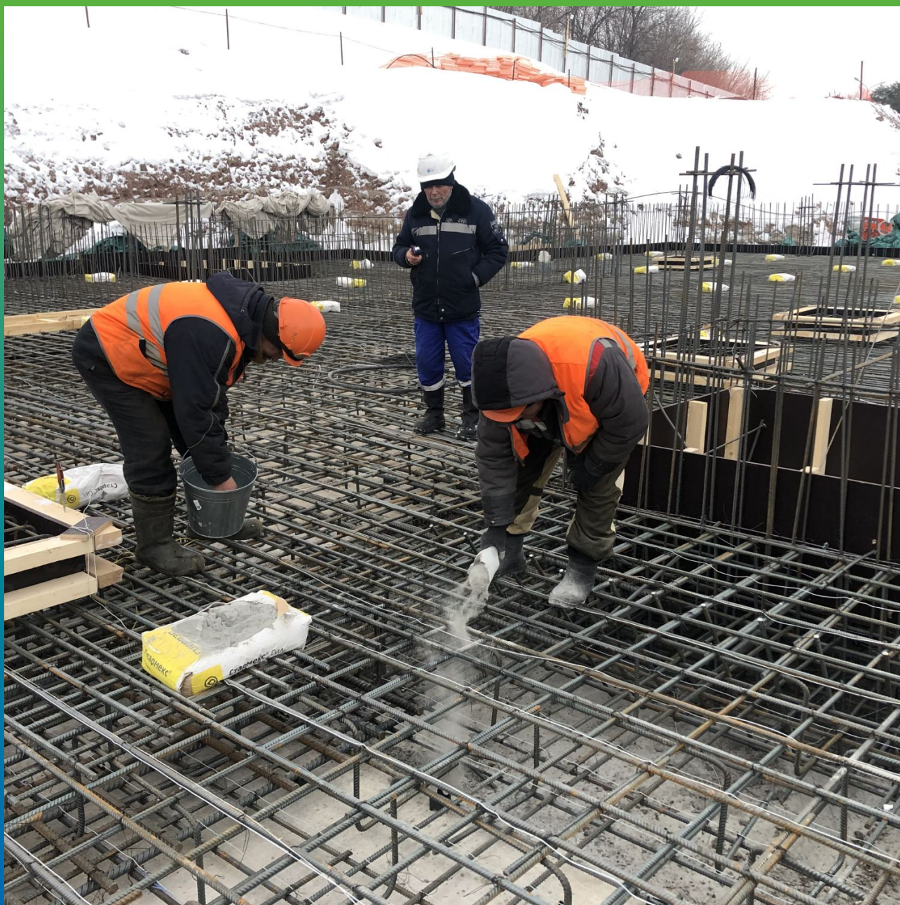
Процесс просыпки гидроизоляции. Другой вид
