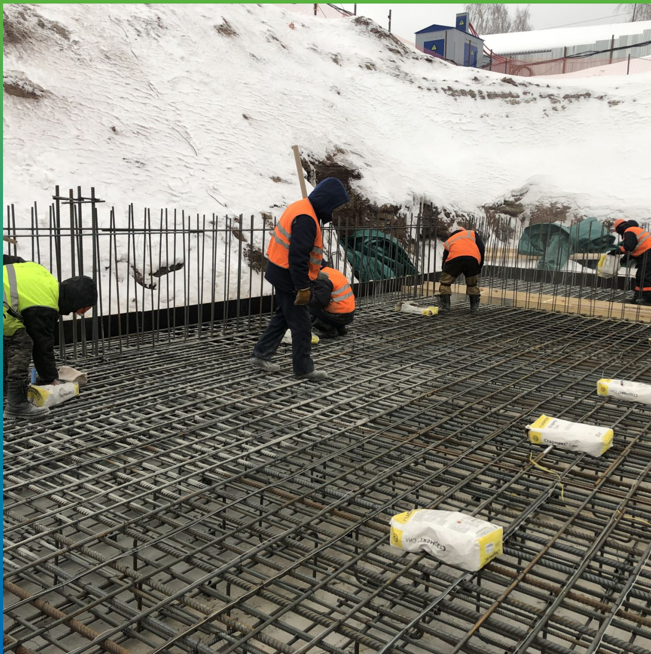
Процесс просыпки гидроизоляции
