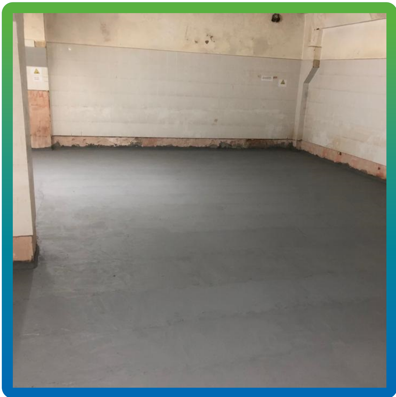
Вид на готовое покрытие
