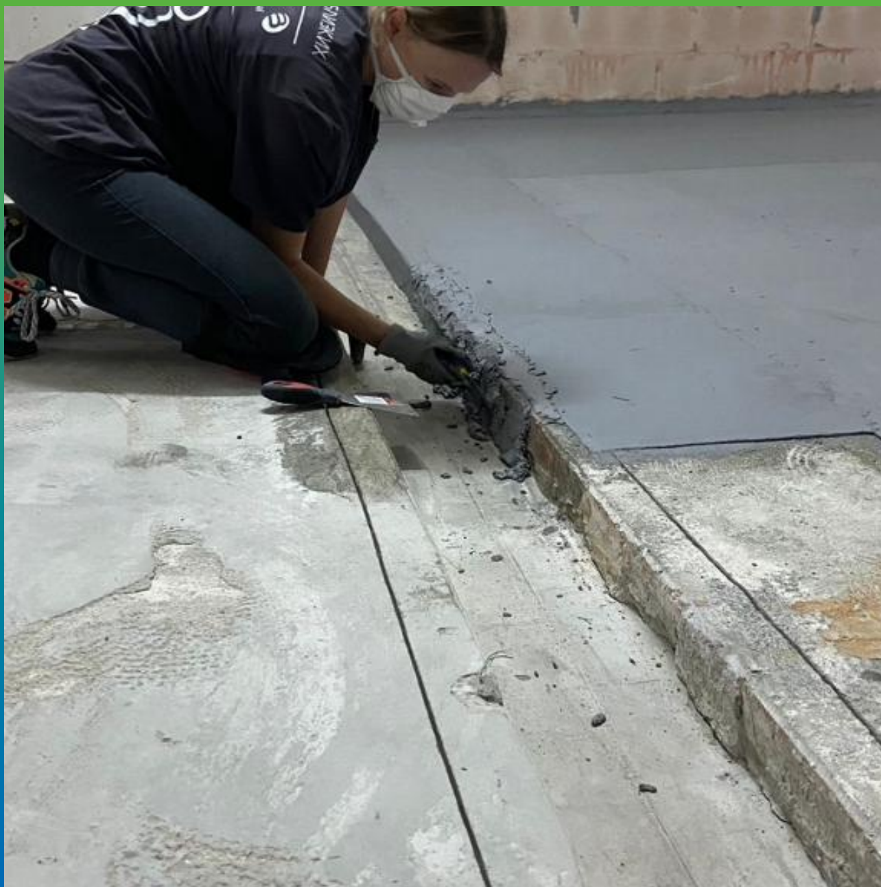
Укладка защитного покрытия ДенТоп ПМ 605 ФК
