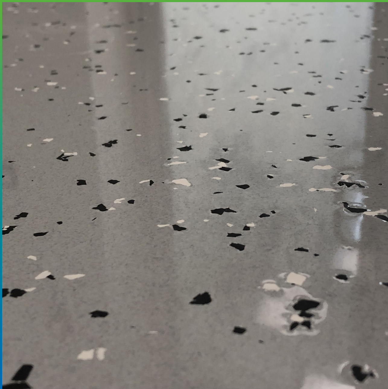
Уложенное финишное покрытие ДенТоп ЭП 500 + ДенТоп Флокс СТ
