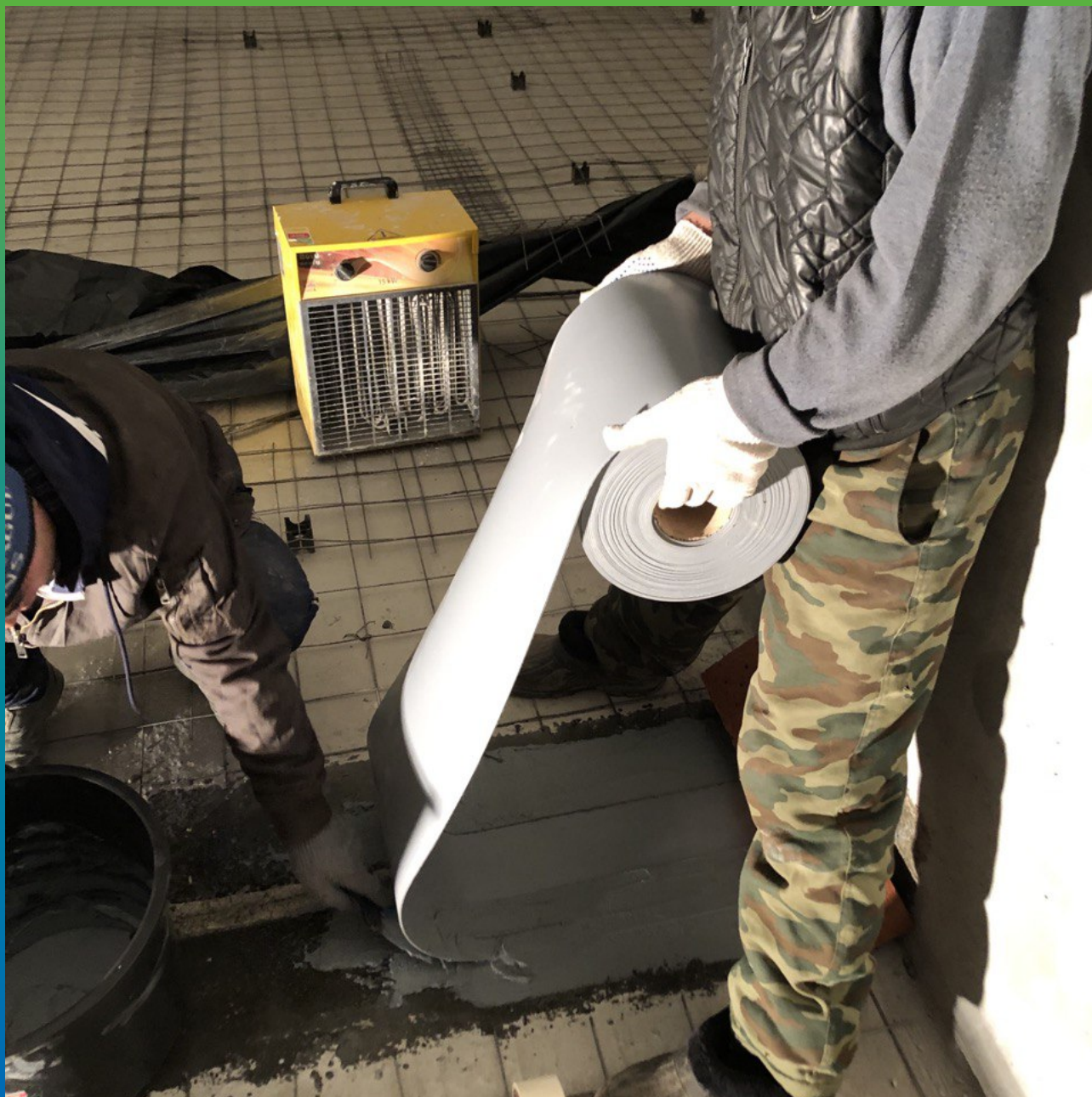
Укладка гидроизоляционной ленты Манодил Про
