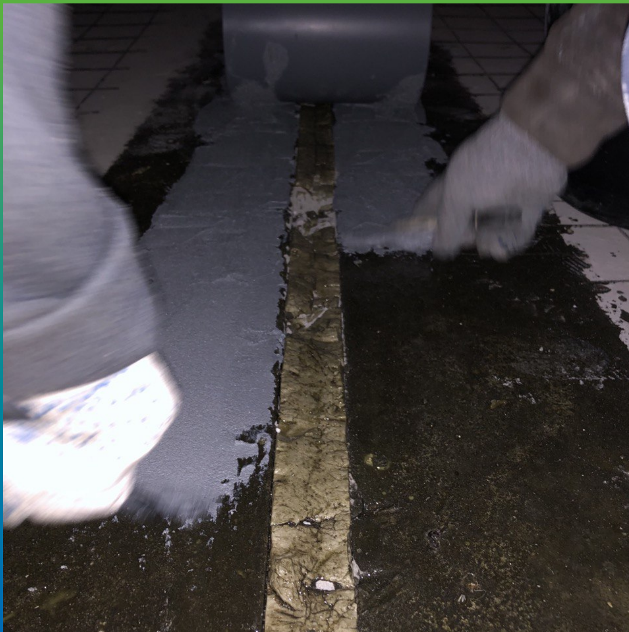
Укладка клея Манопокс 331 на загрунтованную поверхность
