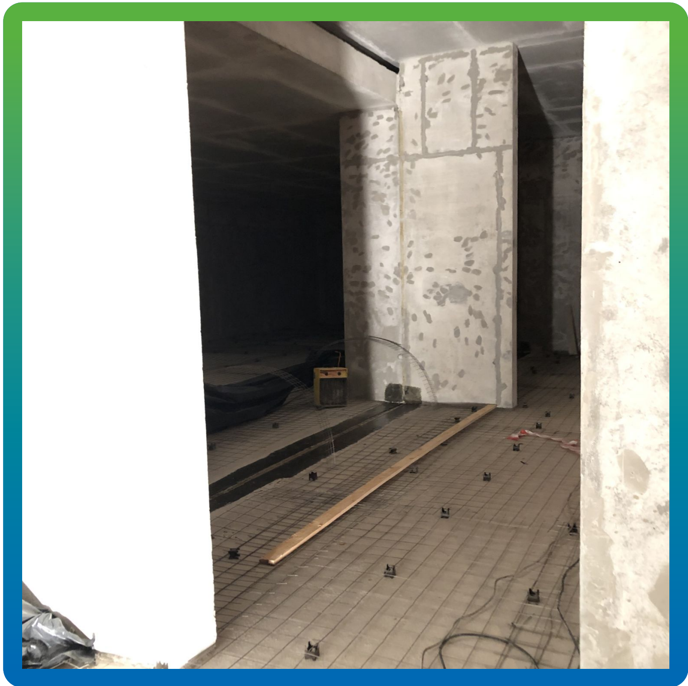
Вид на участок работ
