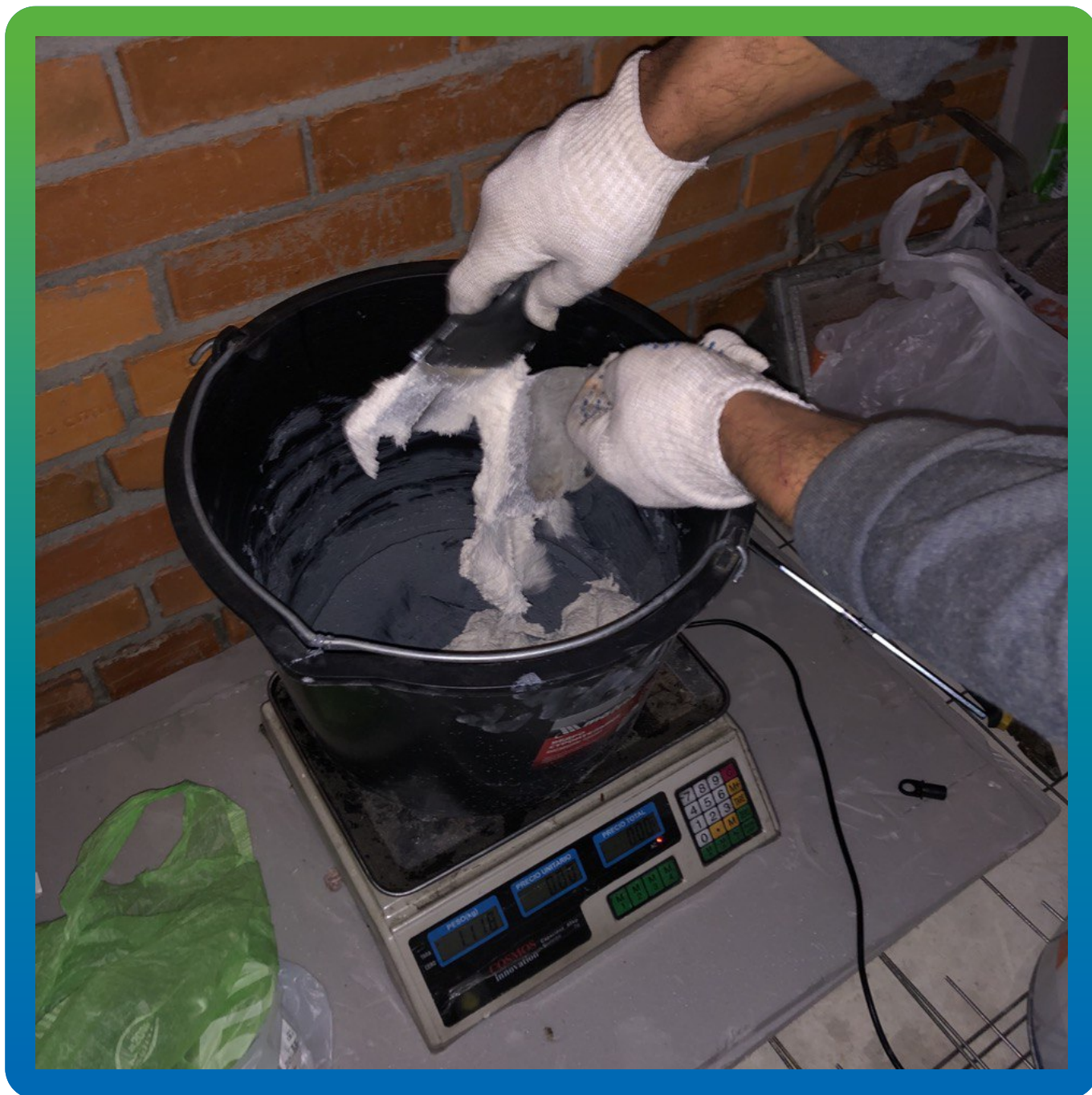
Змешивание компонентов клея Манопокс 331
