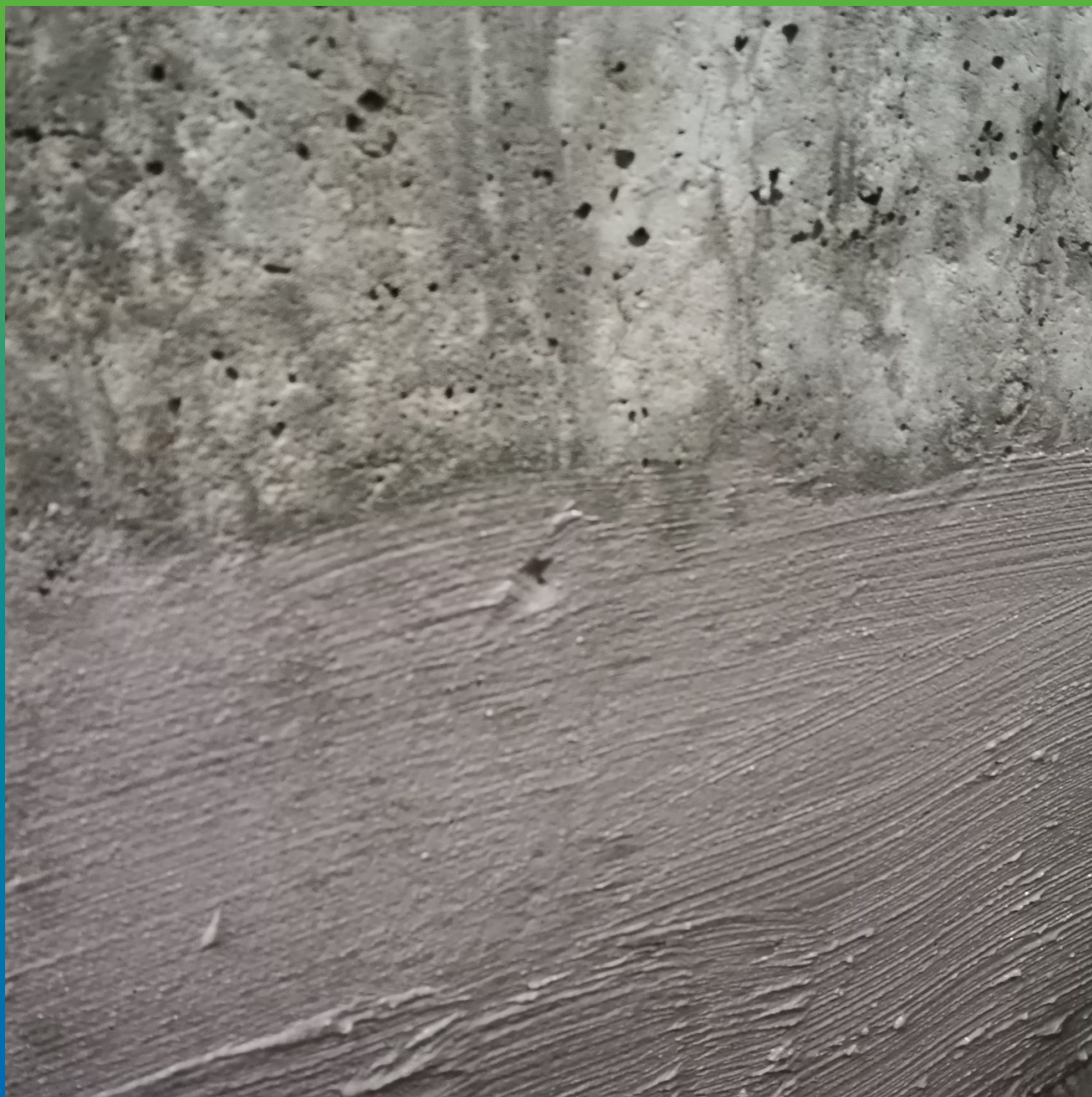
Нанесение первого слоя эластичной гидроизоляции Стармекс Эласт
