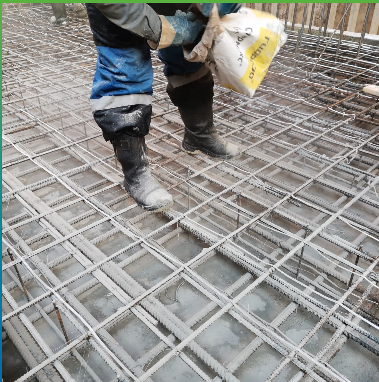
Визуальный контроль качества просыпки материала, допросыпка участков
