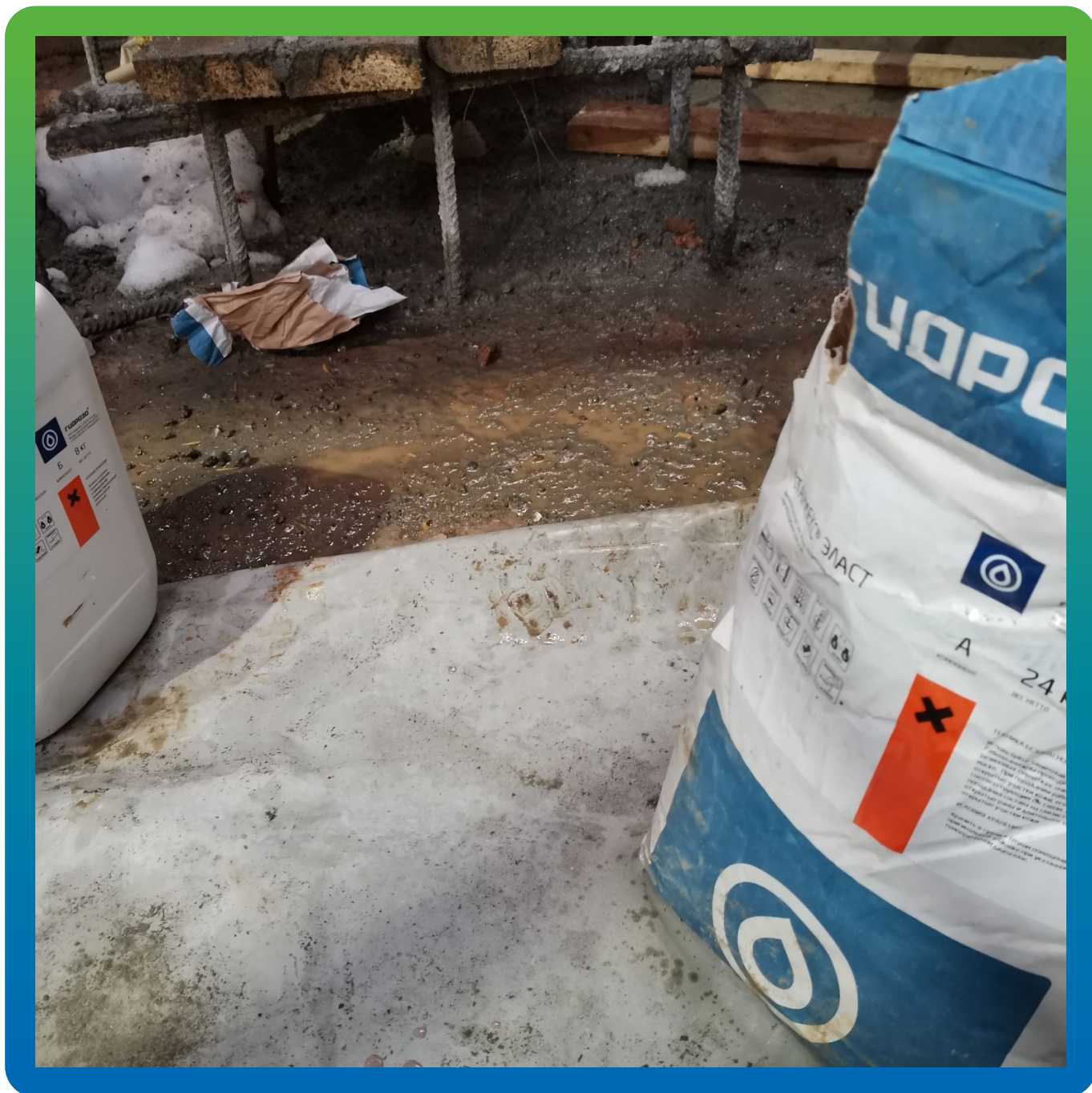
Эластичный материал для нанесения по площади приямка
