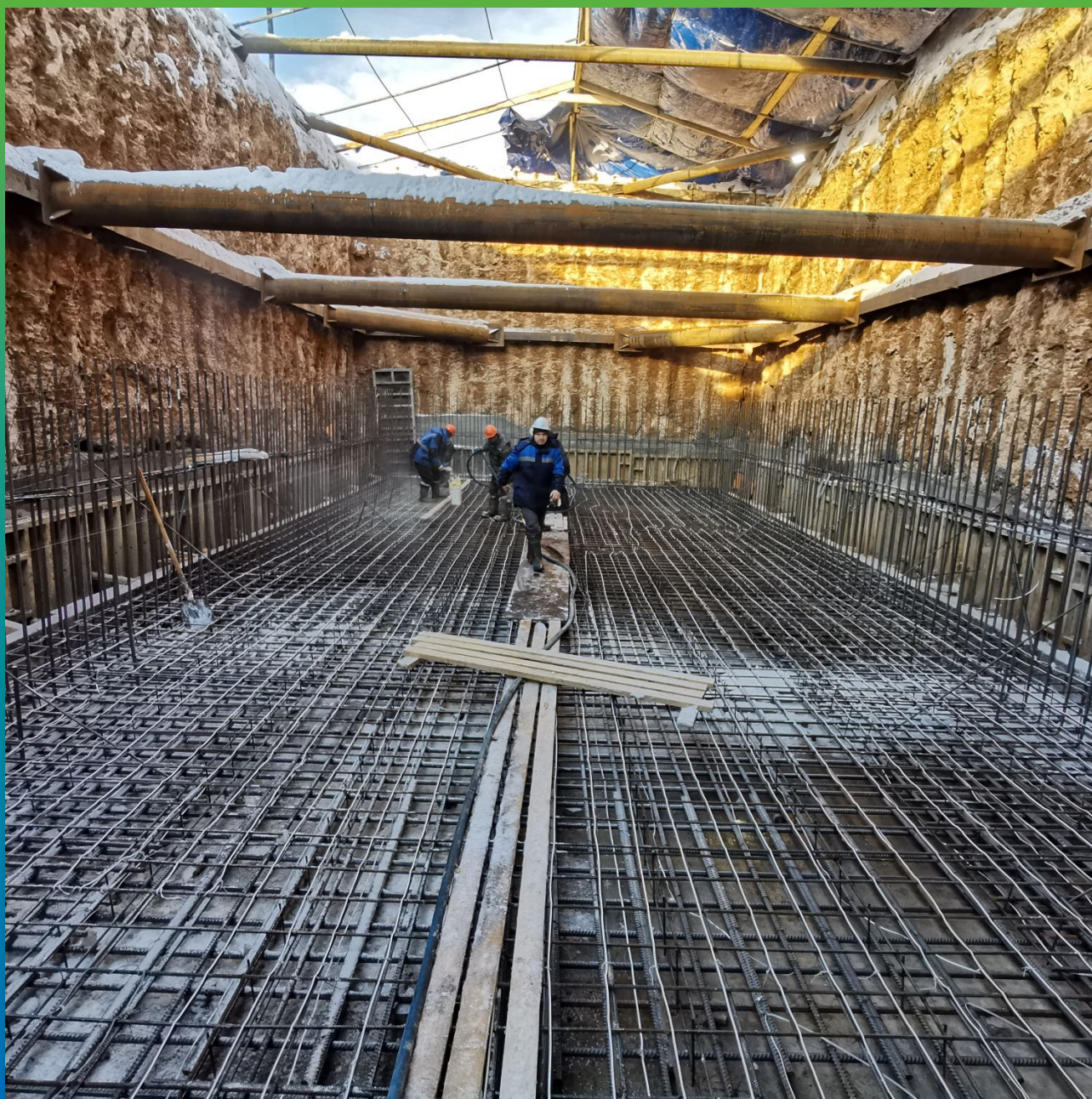
Подготовка к просыпке, очистка от льда
