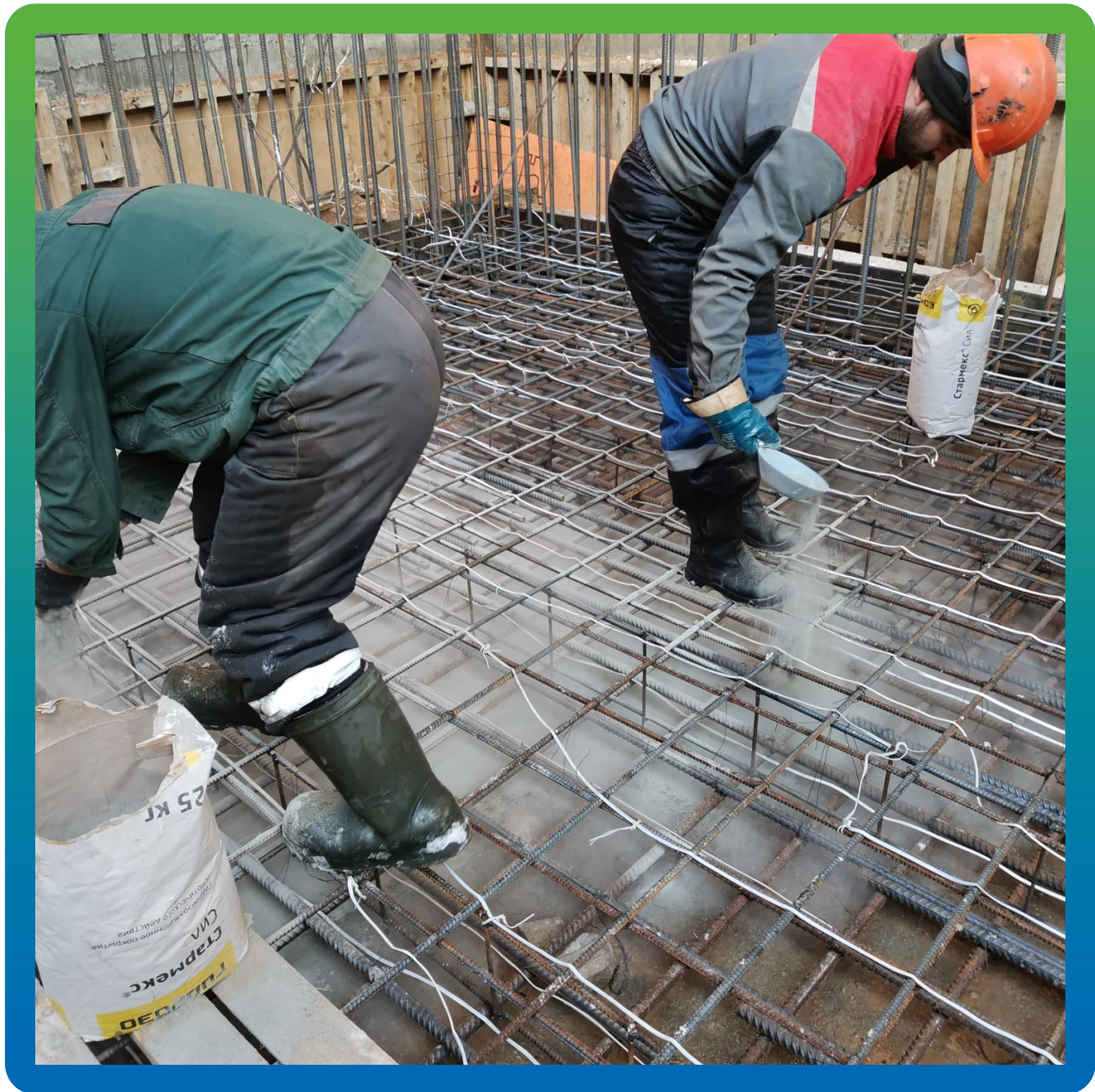
Просыпка материалов для гидроизоляции плиты основания при отрицательных температурах
