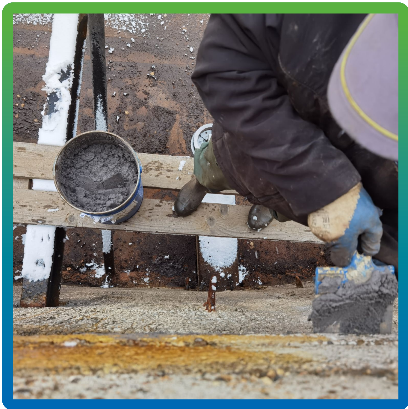
Ремонт дефектов ж/б при отрицательных температурах
