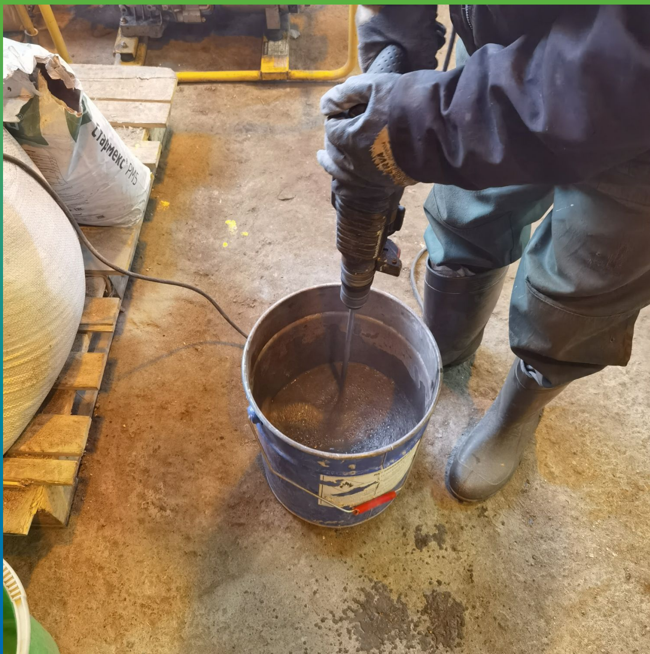
Перемешивание состава до однородного состояния
