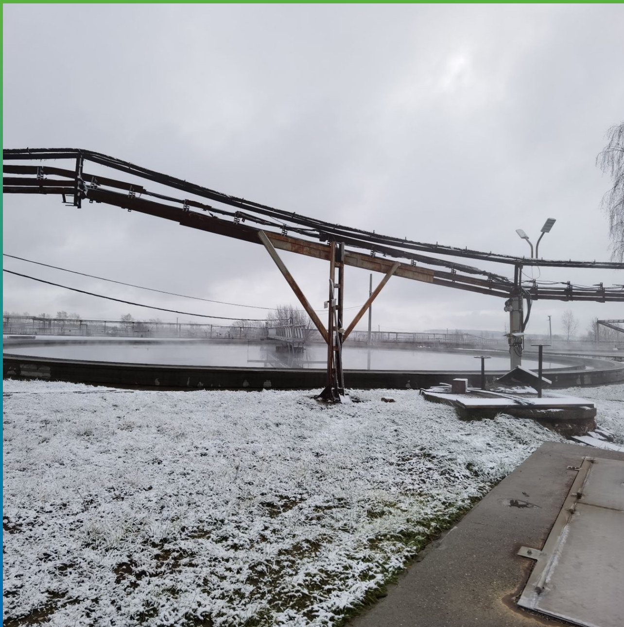
Объекты после гидроиспытаний
