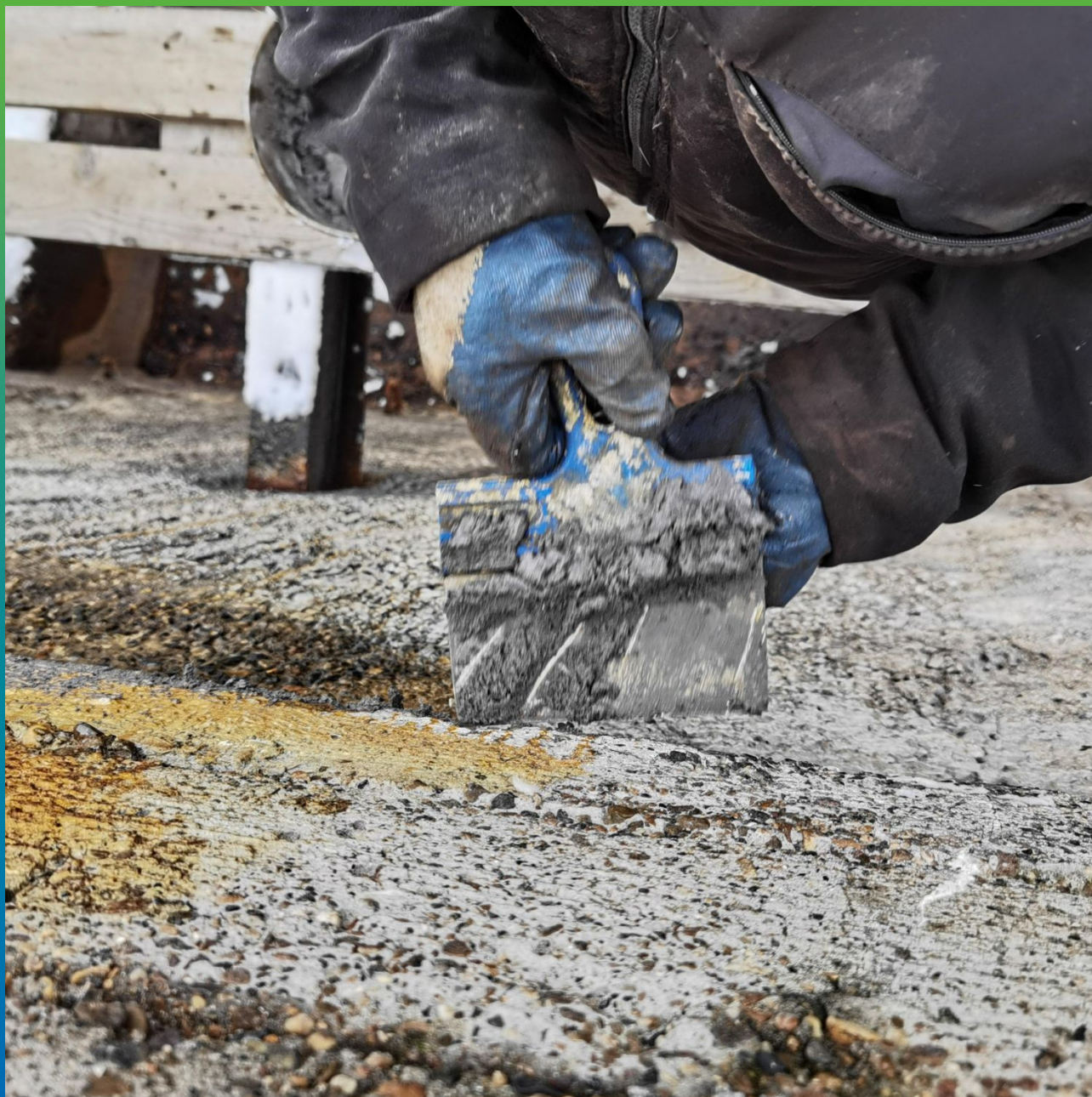
Ремонт рабочего шва при отрицательных температурах
