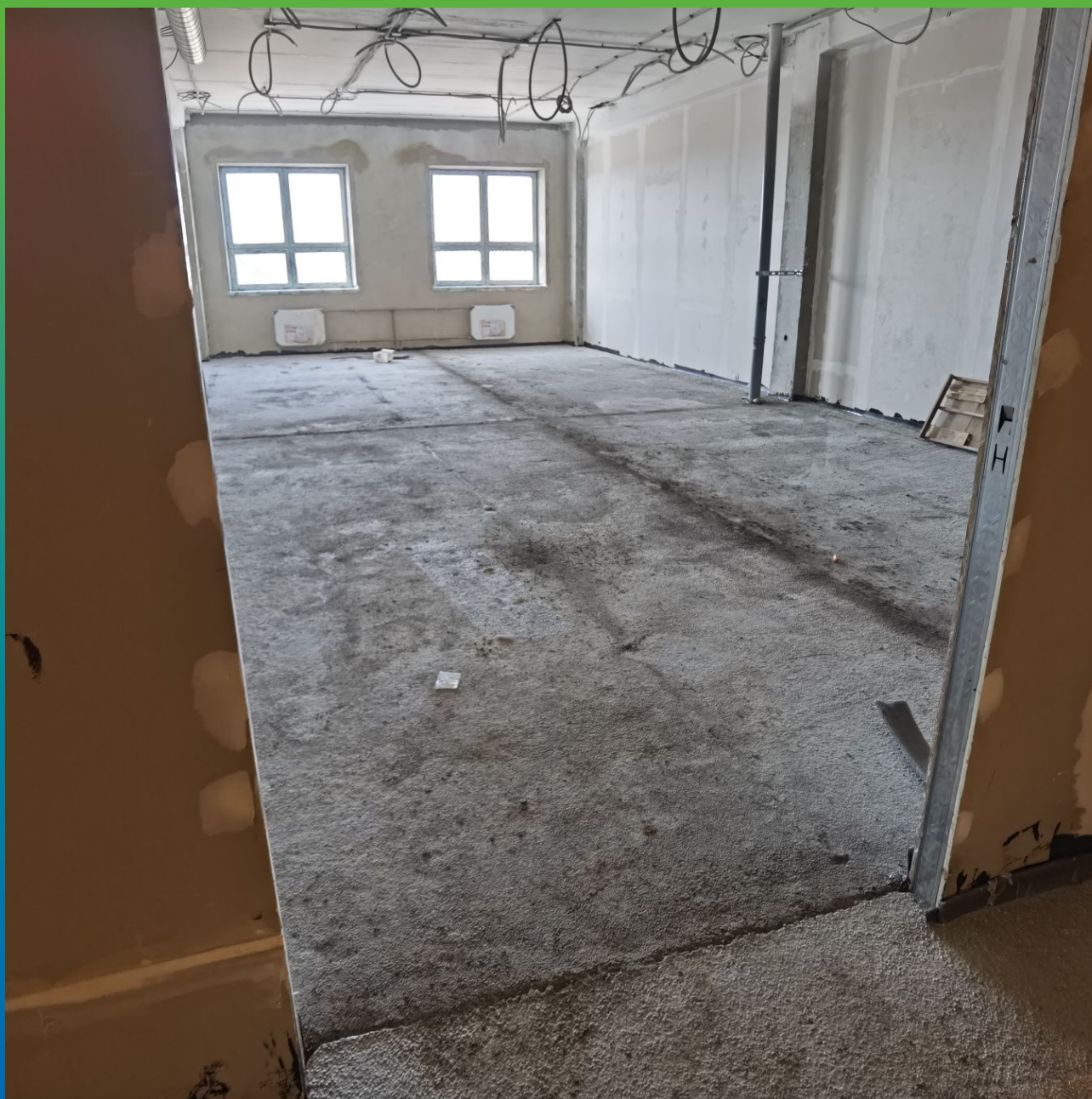
Общий вид после приемки на объекте
