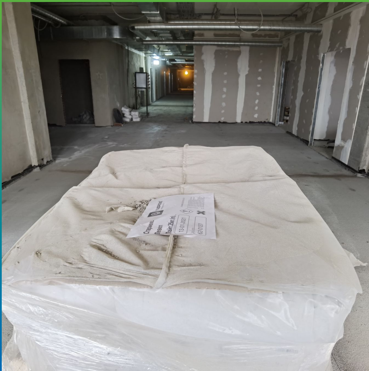
Общий вид после укладки
