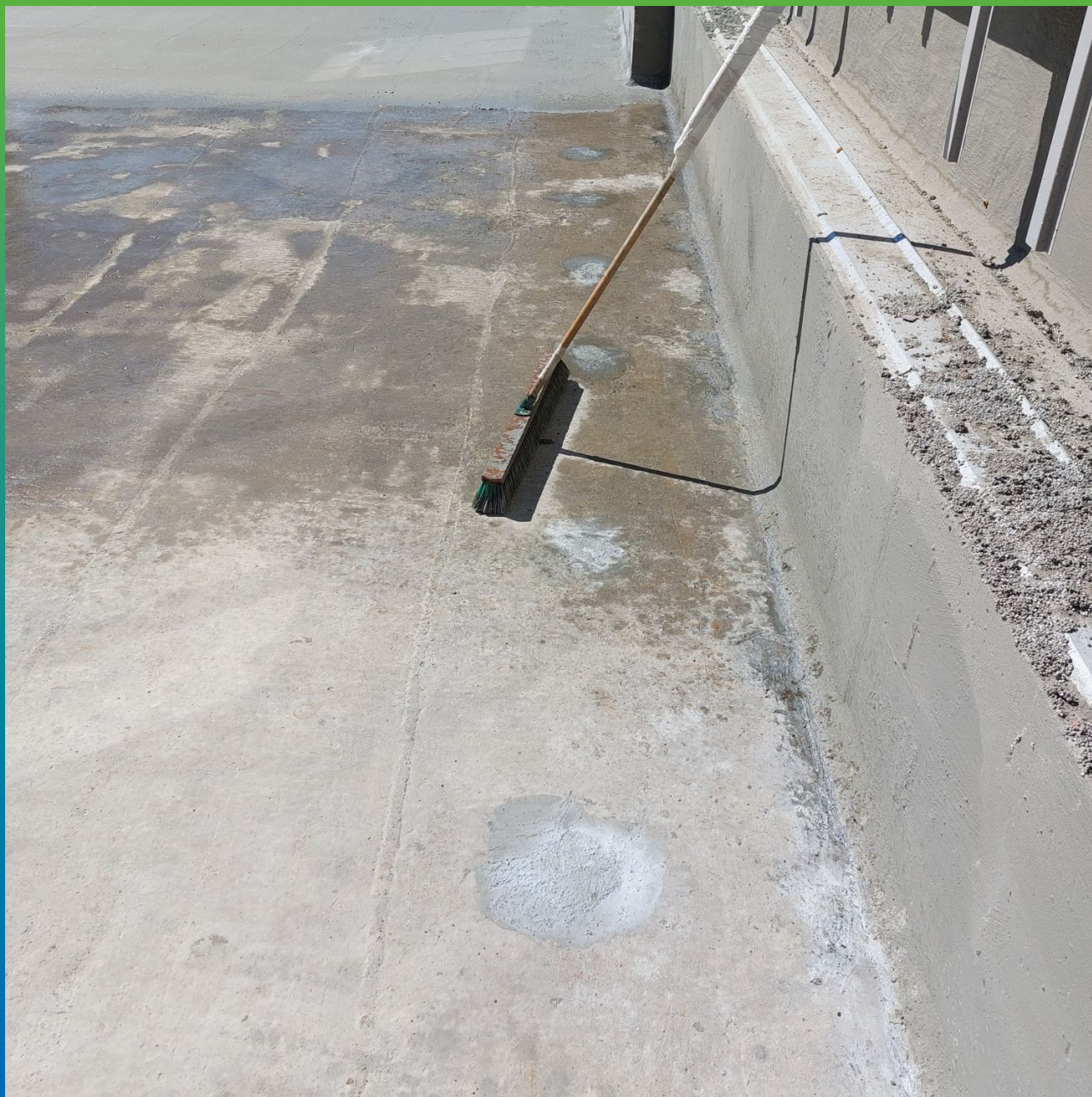
Выполненная галтель из ремсостава Стармекс РМЗ и покрытие парапета гидроизоляцией
