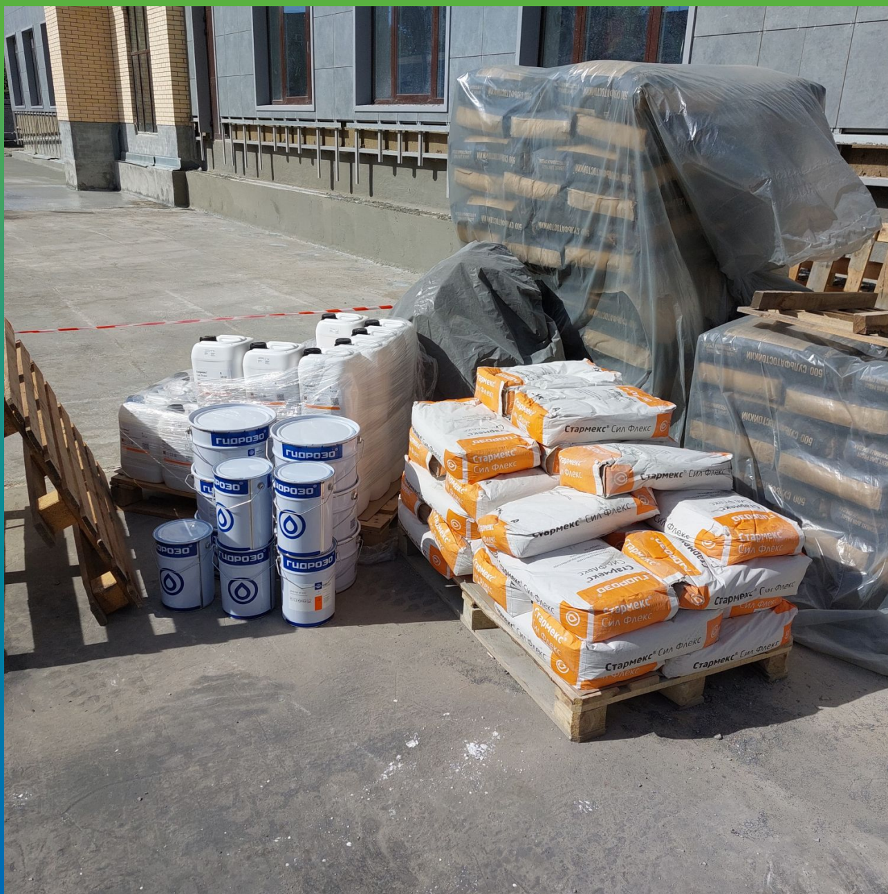
Материалы Гидрозо на объекте
