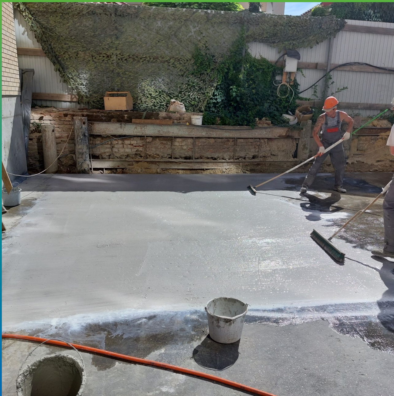
Нанесение гидроизоляции щетками по плите
