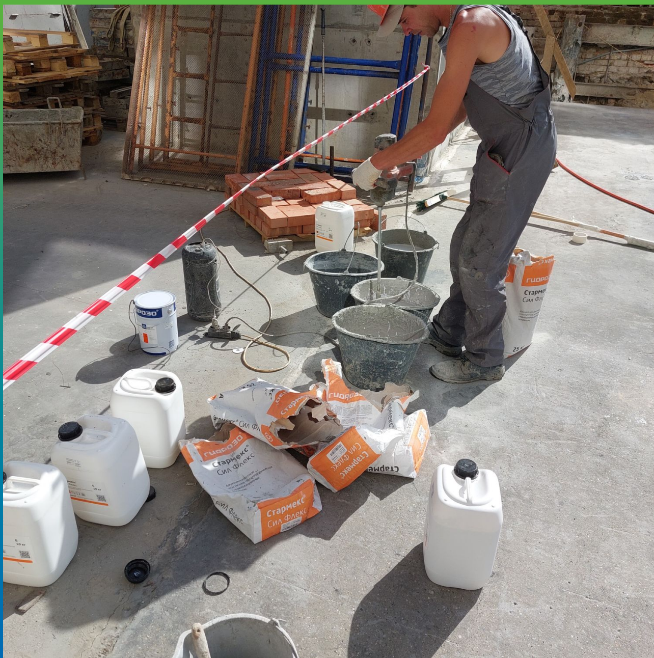
Приготовление эластичной гидроизоляции Стармекс Сил Флекс
