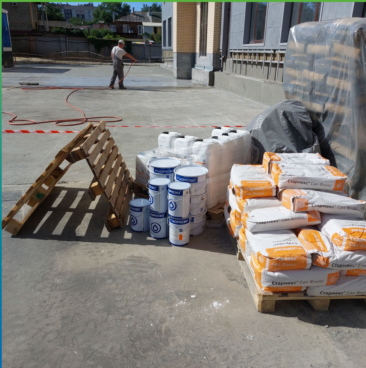
Увлажнение поверхности бетонной плиты эксплуатируемой кровли
