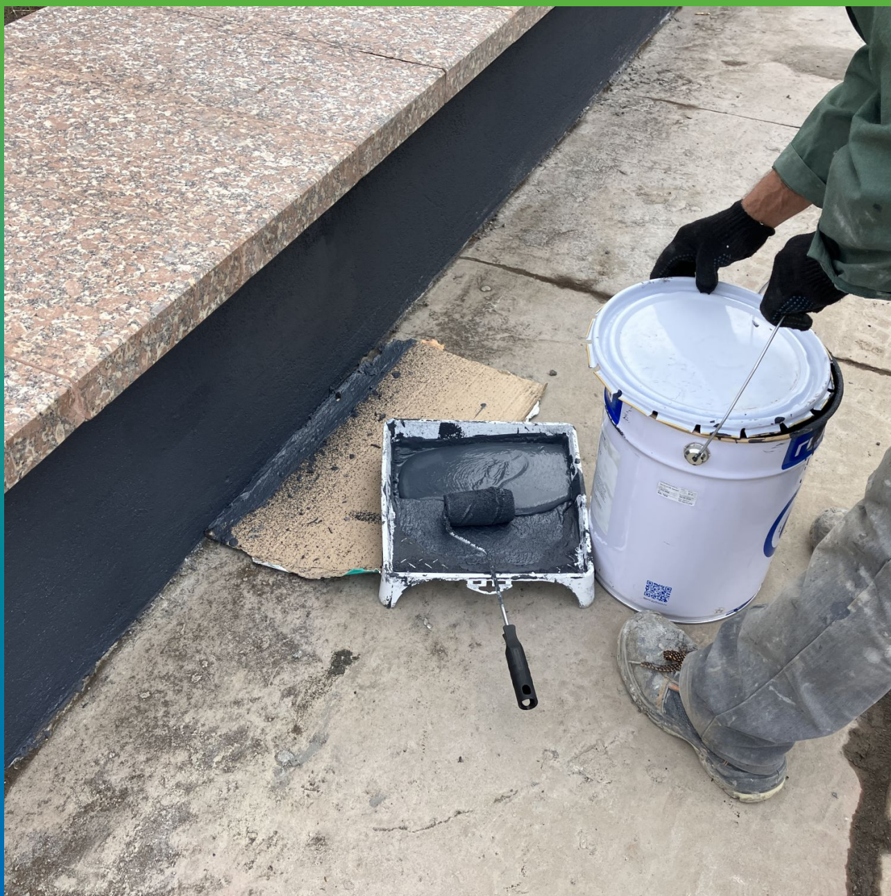
Нанесение Денстоп АК 225 Текстурик валиком на вертикальную поверхность
