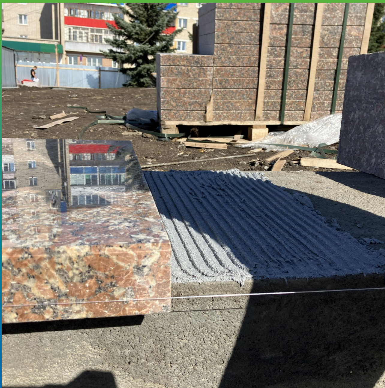
Монтаж гранитных плит на Манопокс 331
