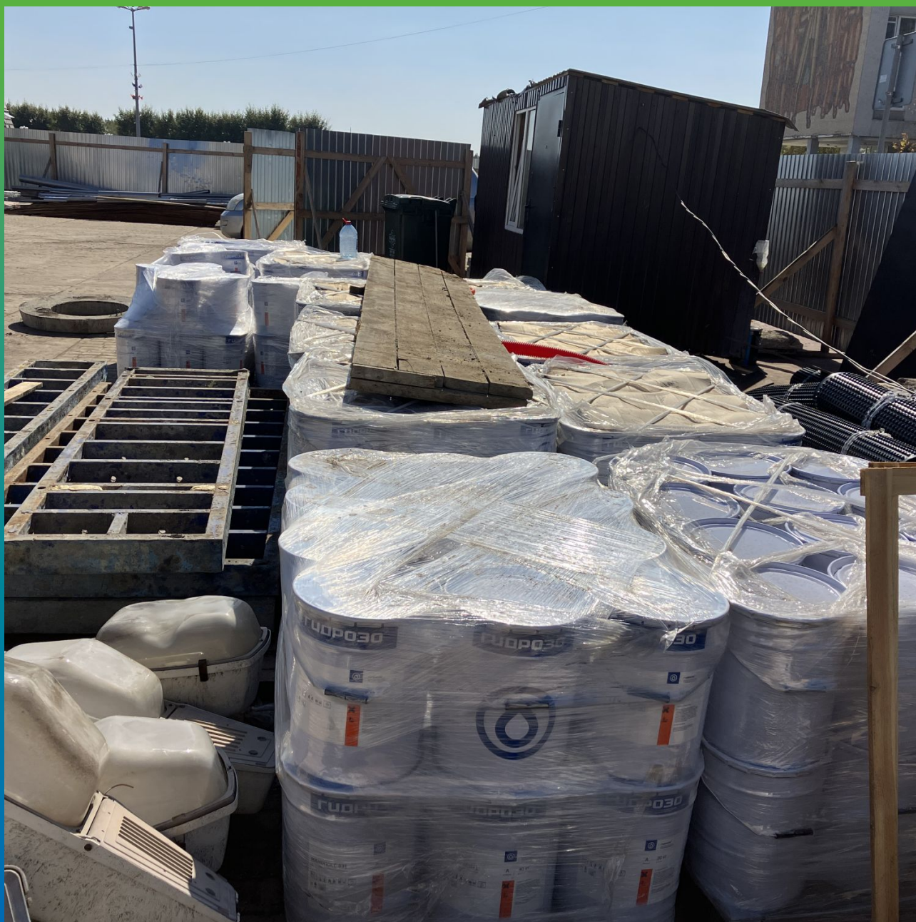
Манопокс 331 на объекте
