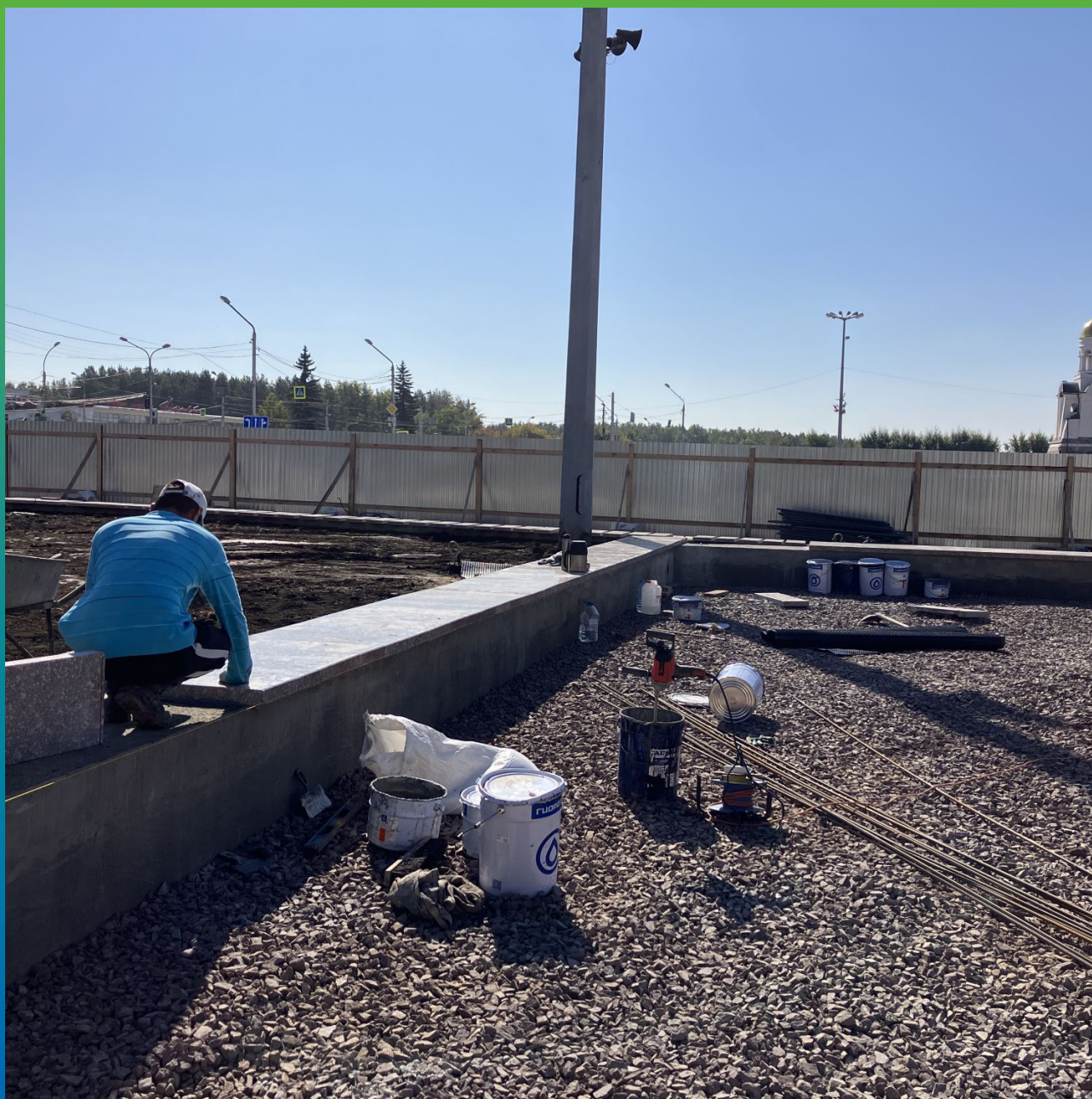
Монтаж гранитных плит на Манопокс 331
