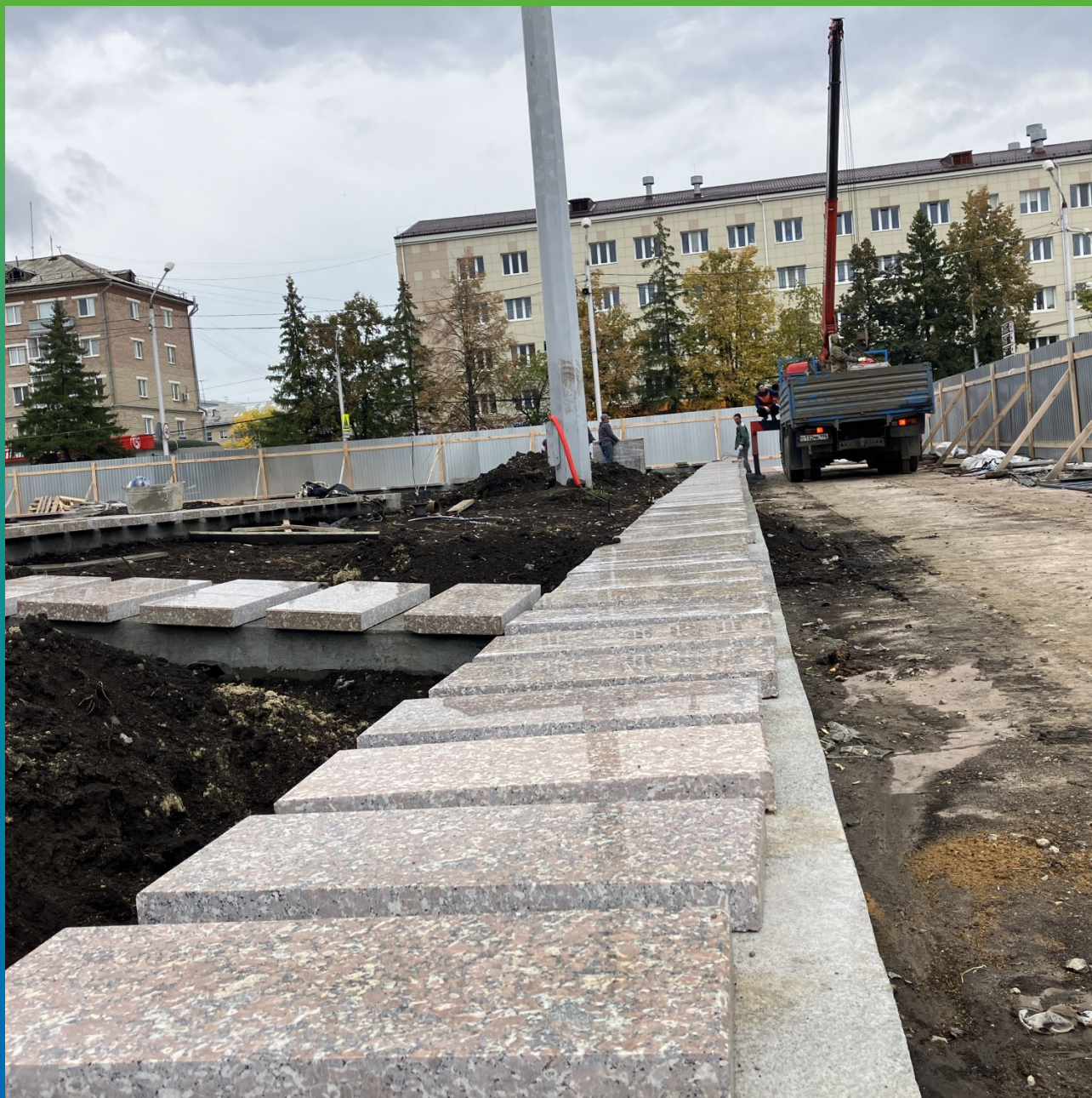
Подготовка к монтажу гранитных плит с помощью Манопокс 331
