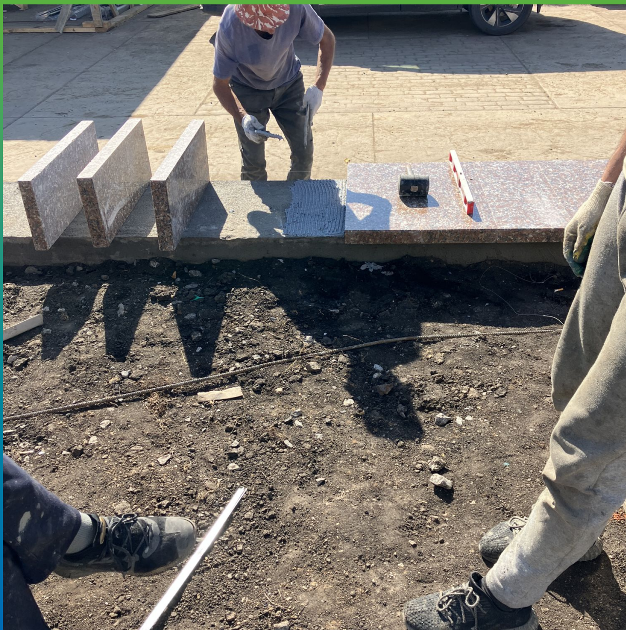
Монтаж гранитных плит на Манопокс 331
