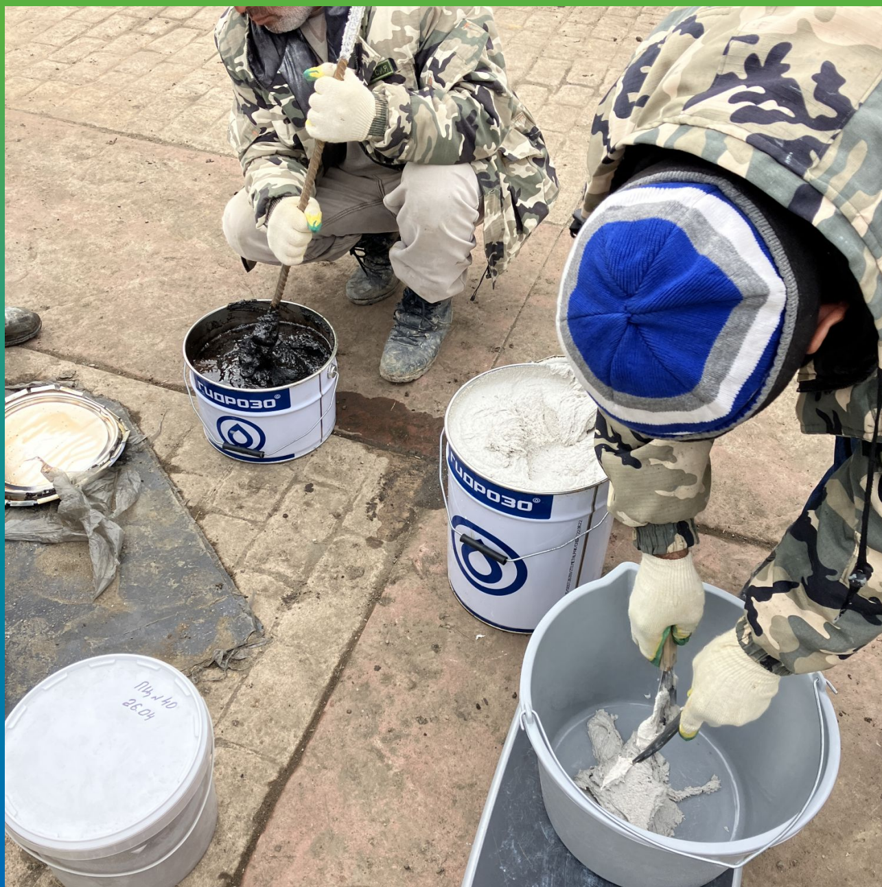
Подготовка материала к нанесению
