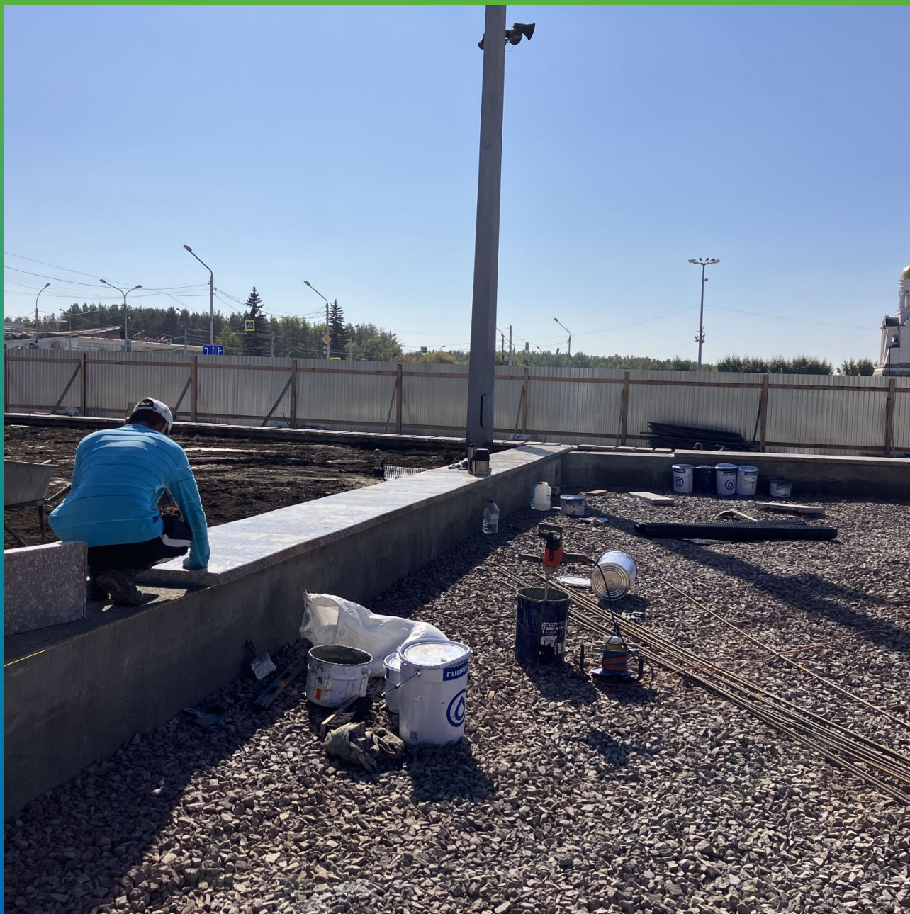
Монтаж гранитных плит на Манопокс 331
