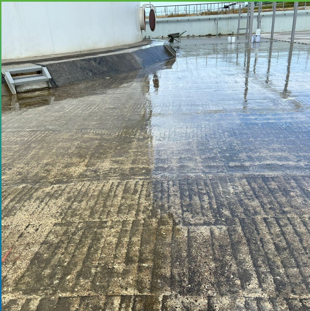
Общий вид ж/б поверхности, загрунтованной ДенсТоп ЭП 106.
