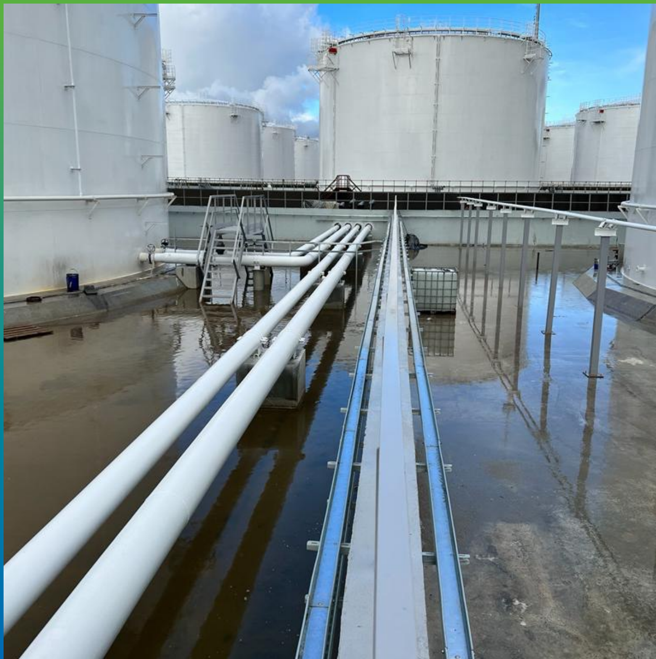
Общий вид поверхности, загрунтованной ДенсТоп ЭП 106.
