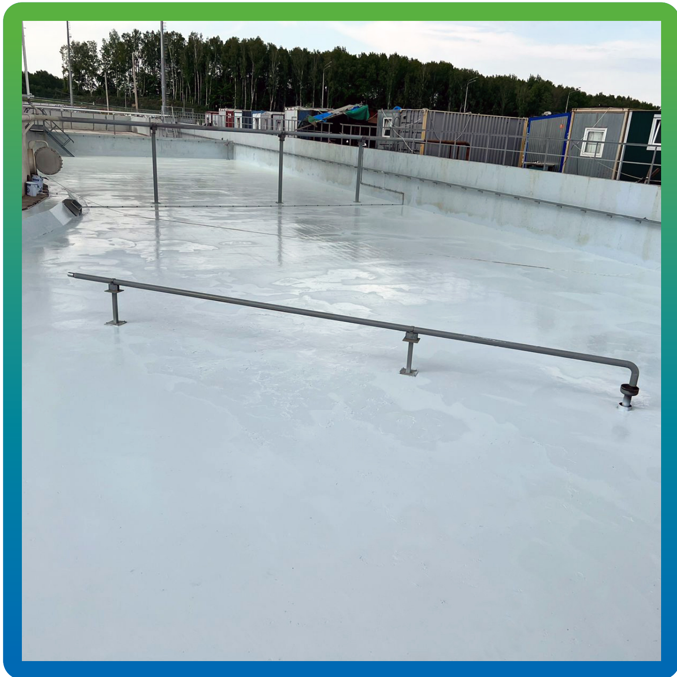
Общий вид готового покрытия ДенТоп ПУ 302.
