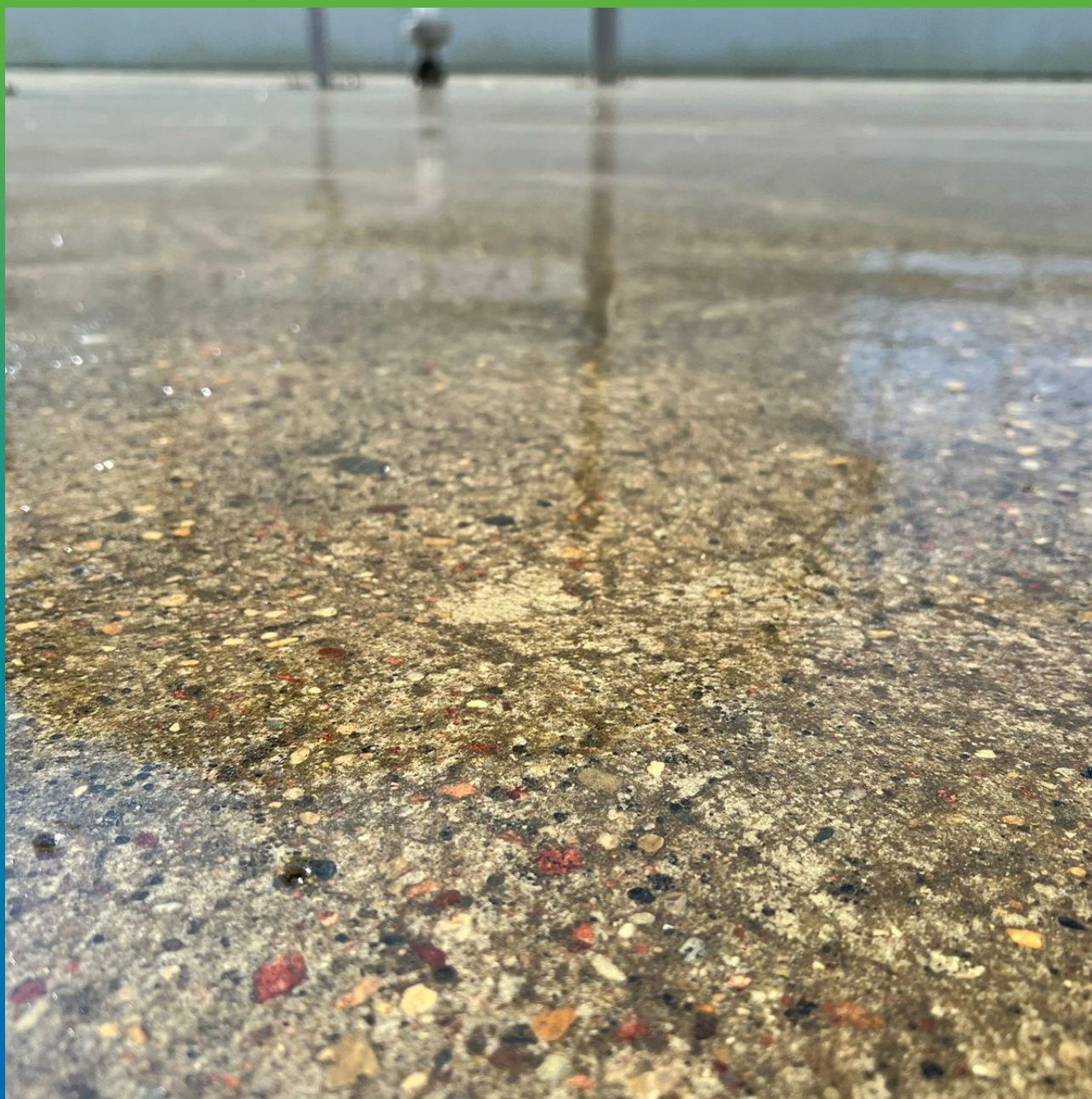
Крупный план поверхности, загрунтованной ДенсТоп ЭП 106.
