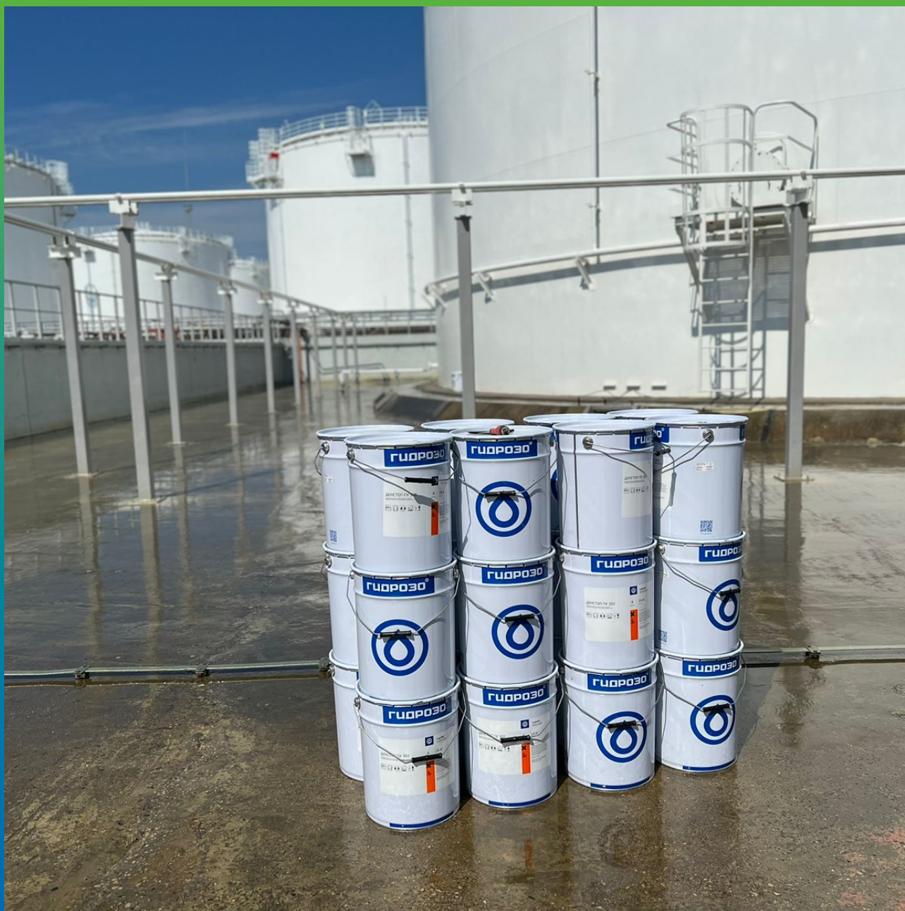
Подготовленный материал ДенСтоп ПУ 302 перед нанесением на объекте.
