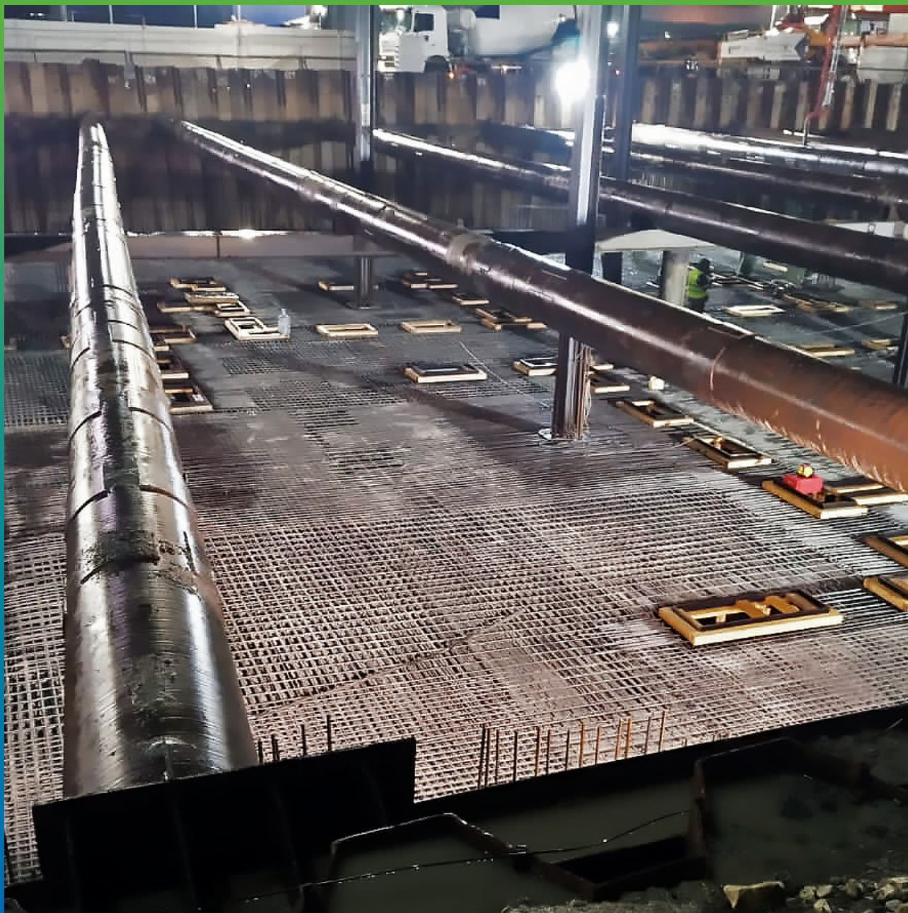
Общий вид котлована со связанным арматурным каркасом перед гидроизоляционными работами.
