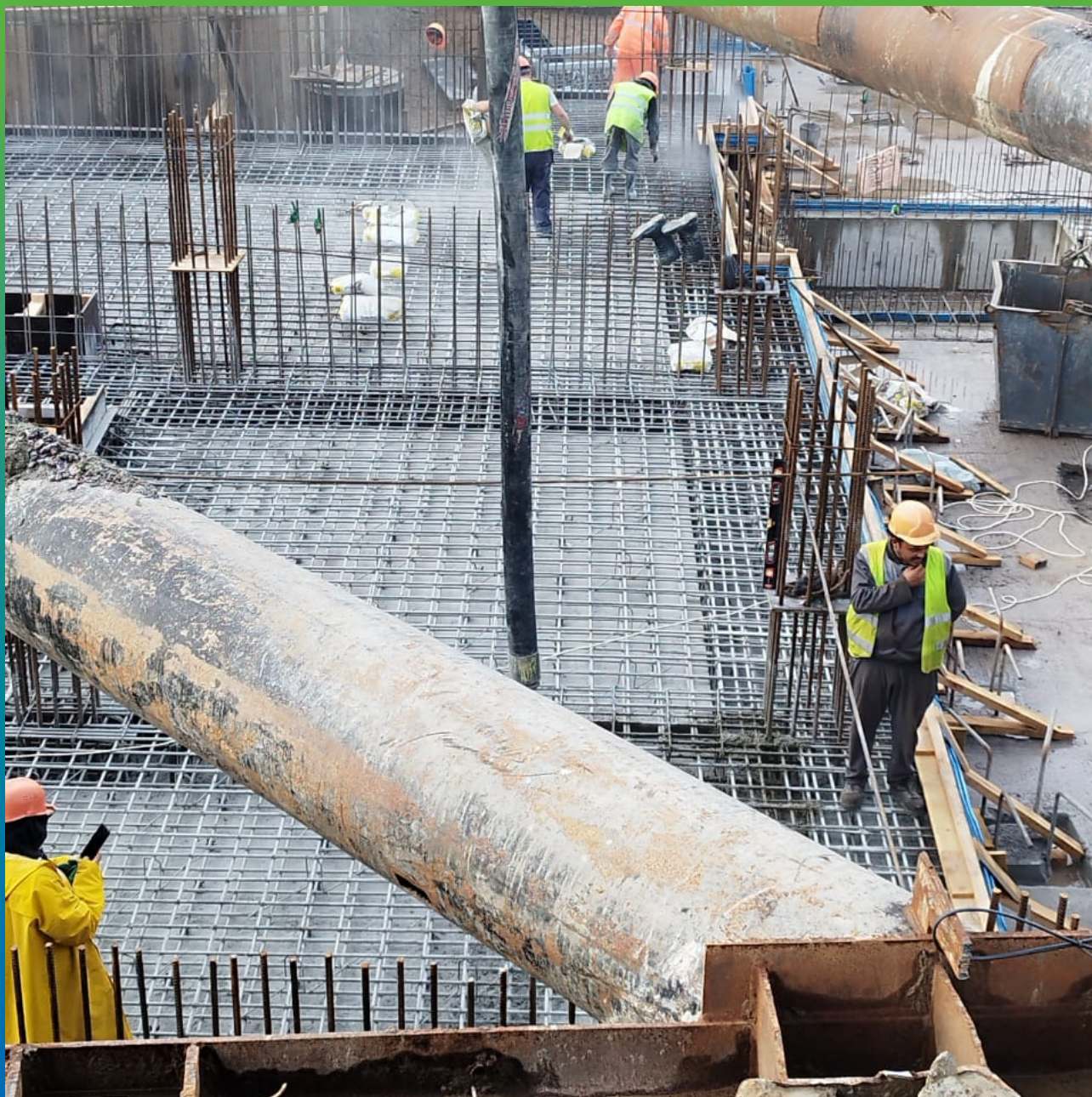
Начало подачи бетона для заливки фундаментной плиты.
