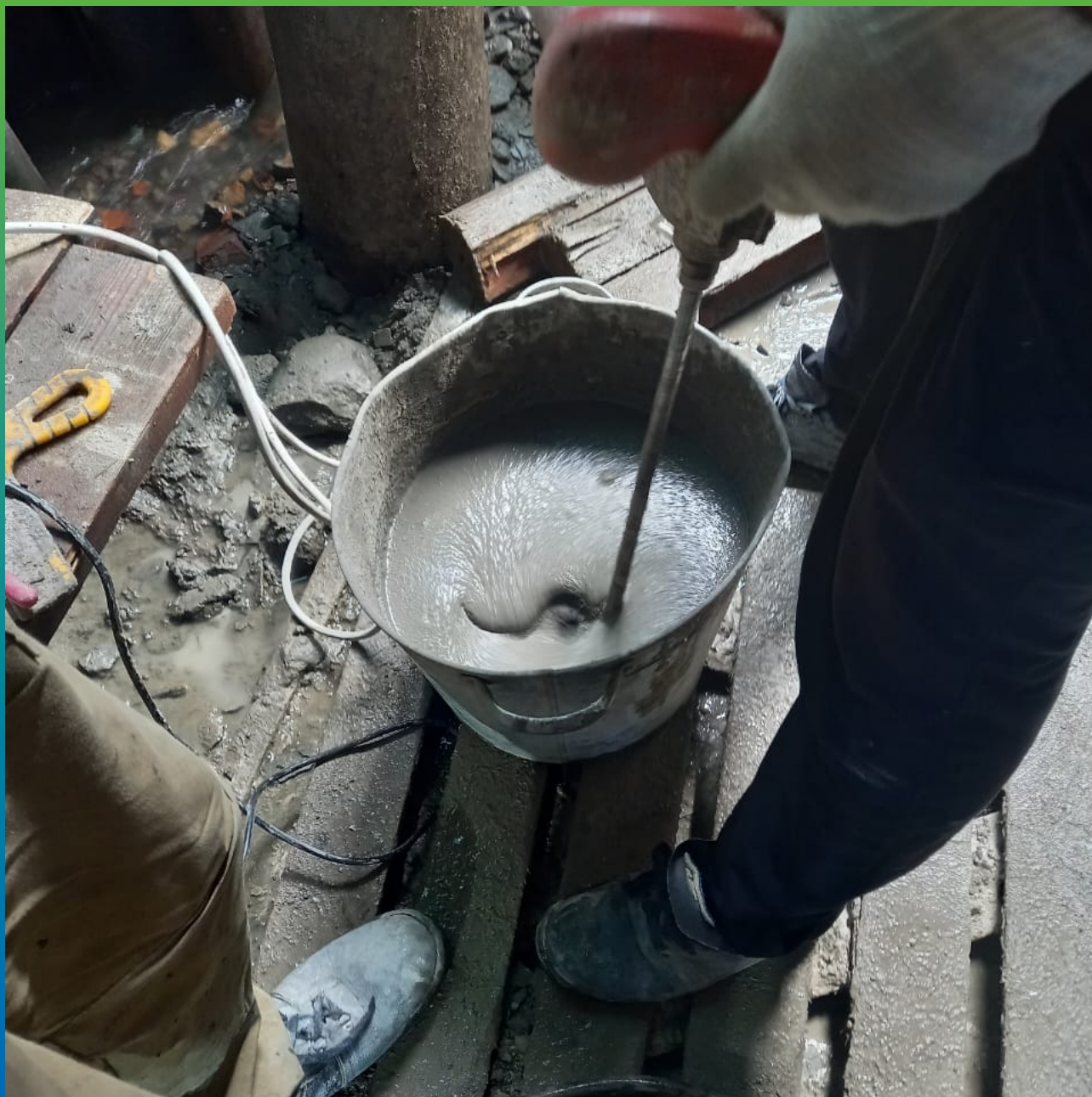
Приготовление раствора Стармекс ФМ7.
