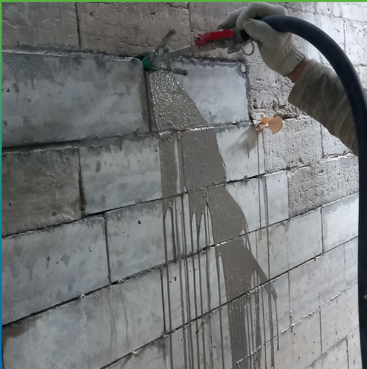
Пробное инъецирование раствора Маноцем Фил в каменную кладку.
