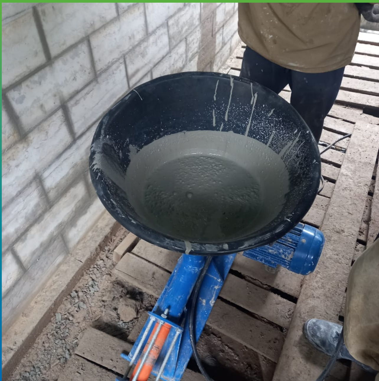
Вид раствора Маноцем Фил в бункере насоса.
