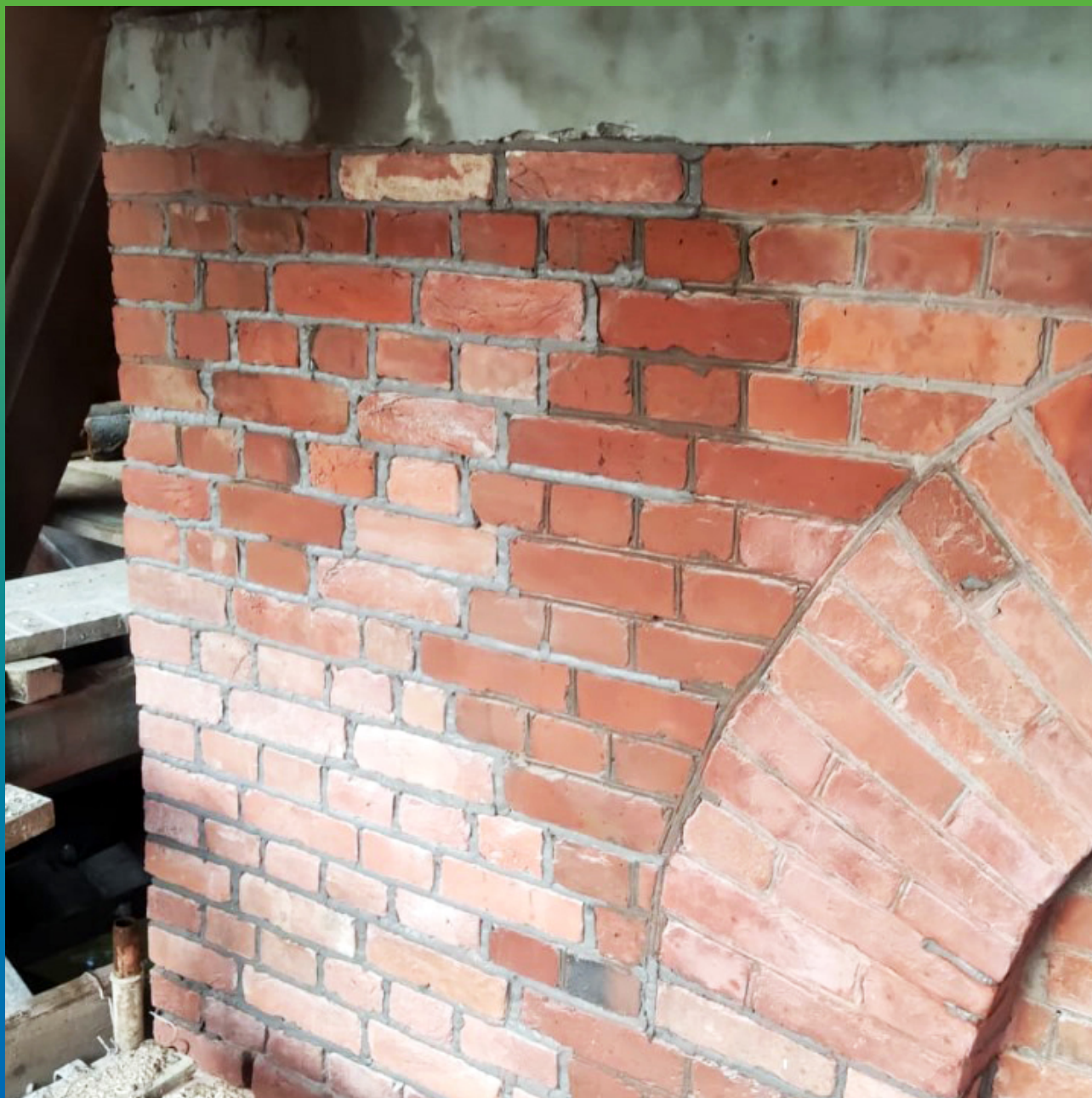
Вид отремонтированной кирпичной кладки опор моста.
