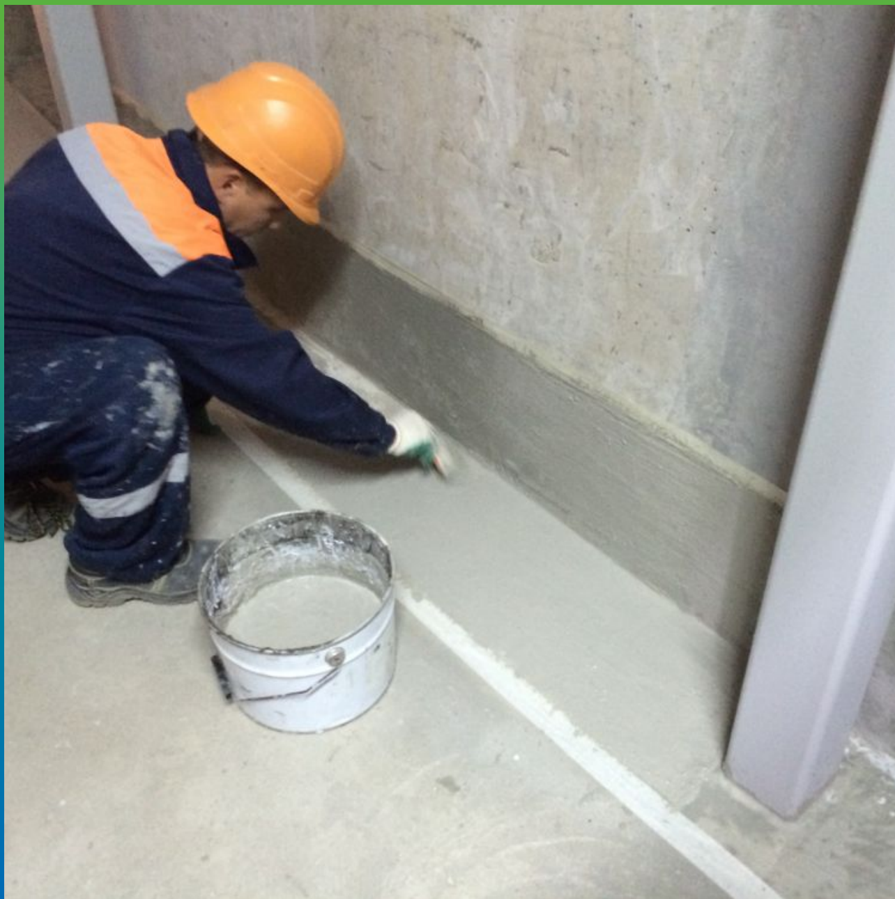
Нанесение гидроизоляции Максил Флекс на примыкание стена/пол.
