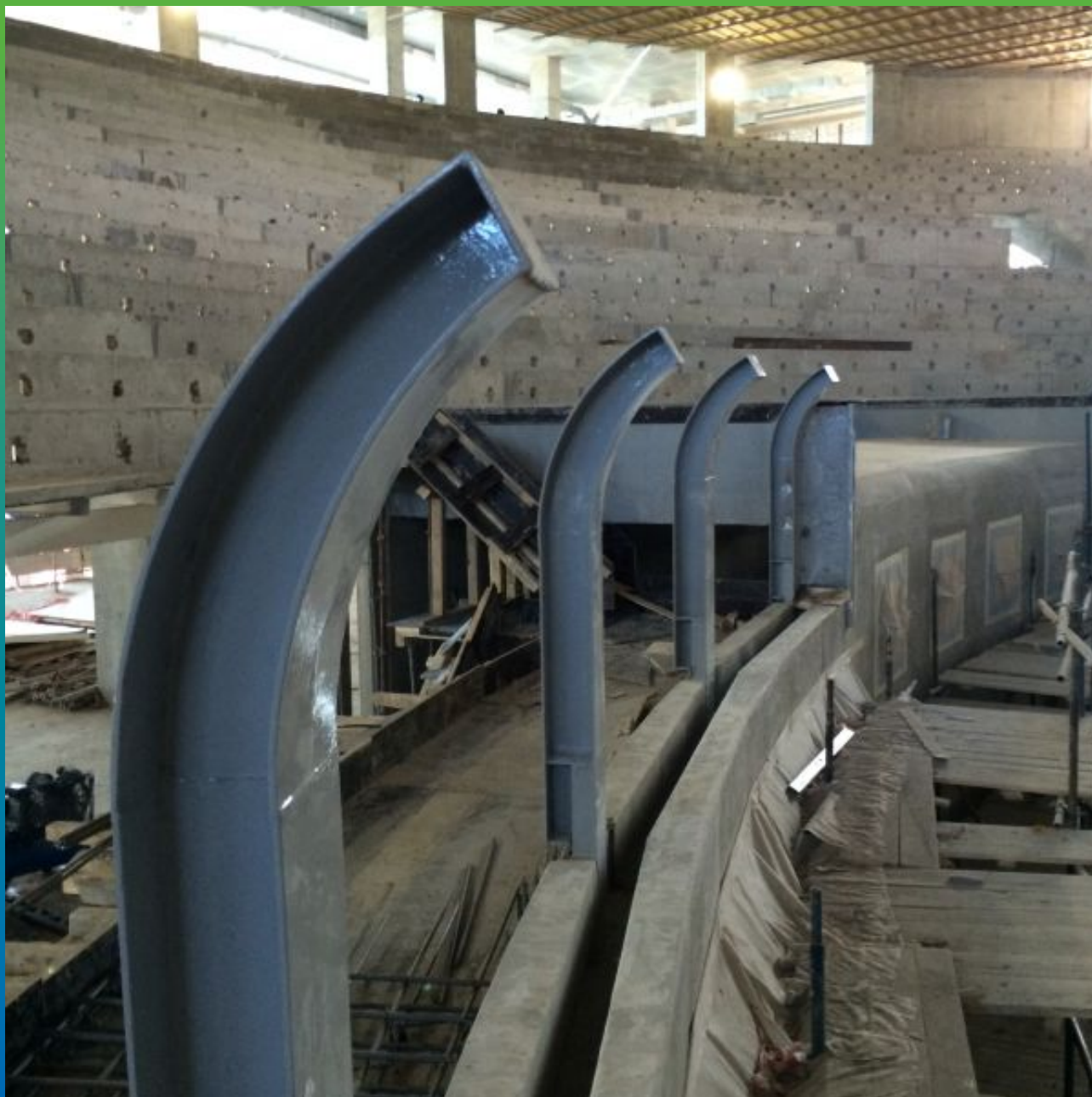
Металлические балки для крепления акрилового стекла обработанные Максэпокс Флексом.
