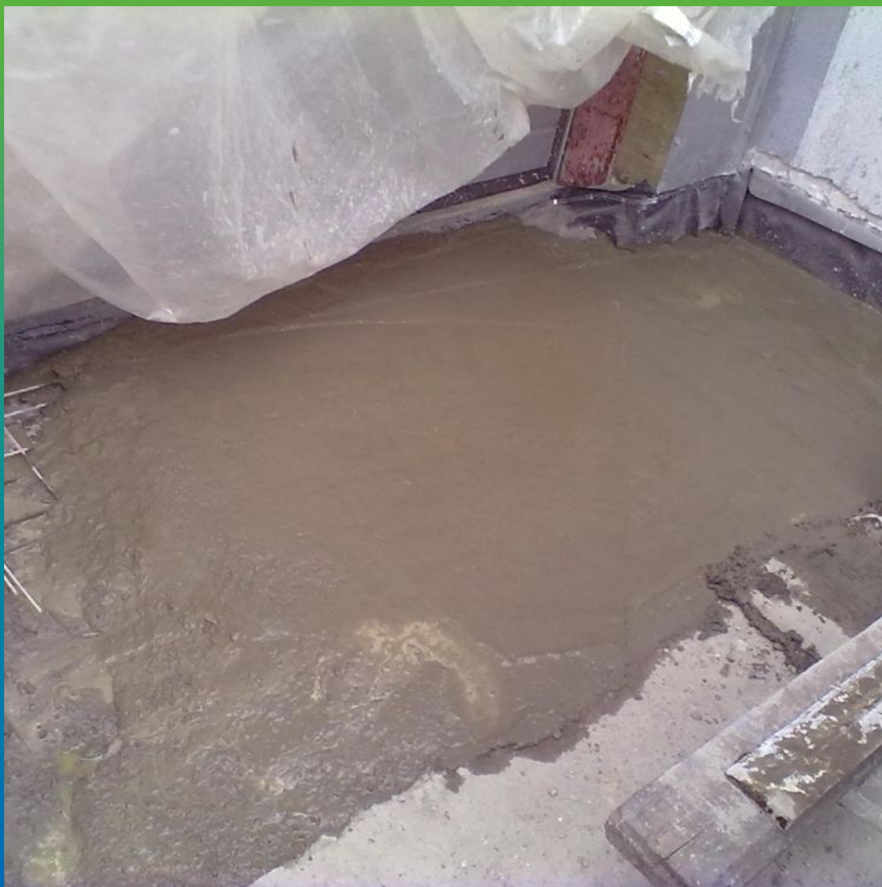
Бетонирование гидроизолированной поверхности.
