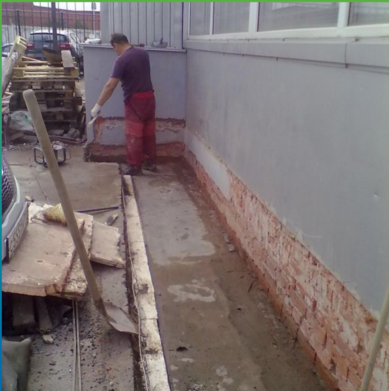
Подготовительные работы. Демонтаж отмостки.
