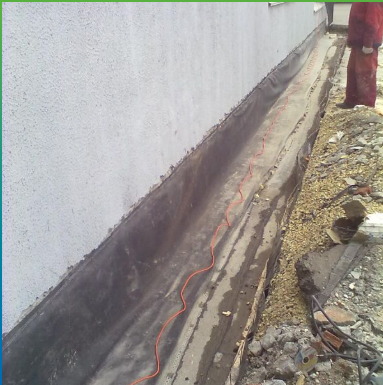
Укладка и крепеж ЭПДМ мембраны.
