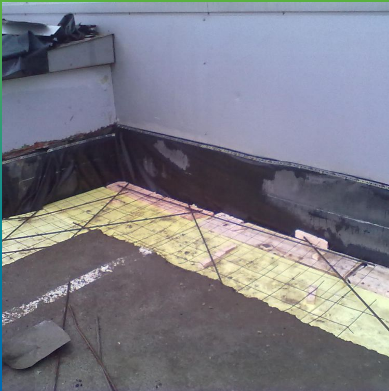
Подготовка к бетонированию.
