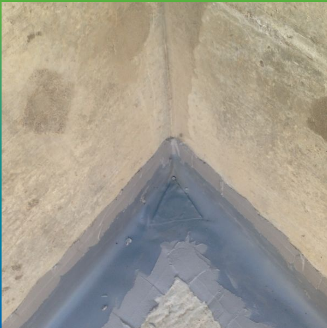
Обтекание угла лентой, выполненное с помощью сварки горячим воздухом
