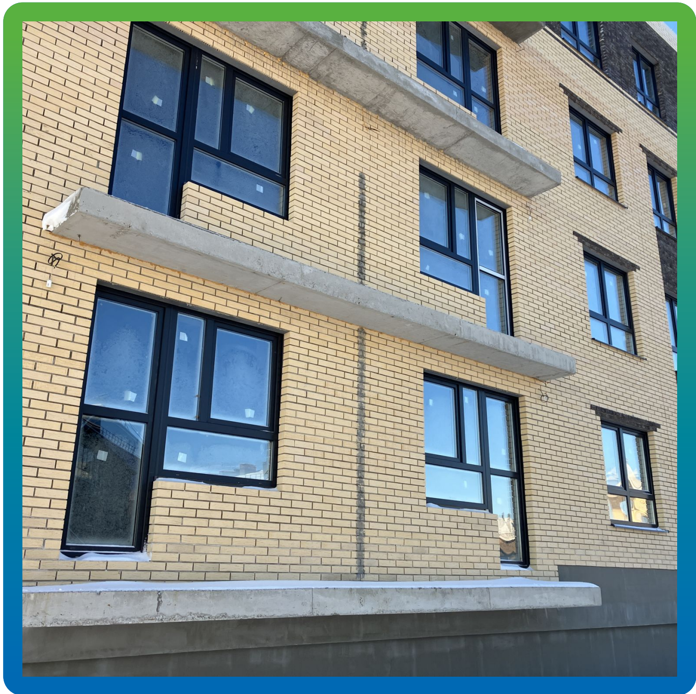
Гидроизоляция французских балконов на ЖК Зеленая Горка
