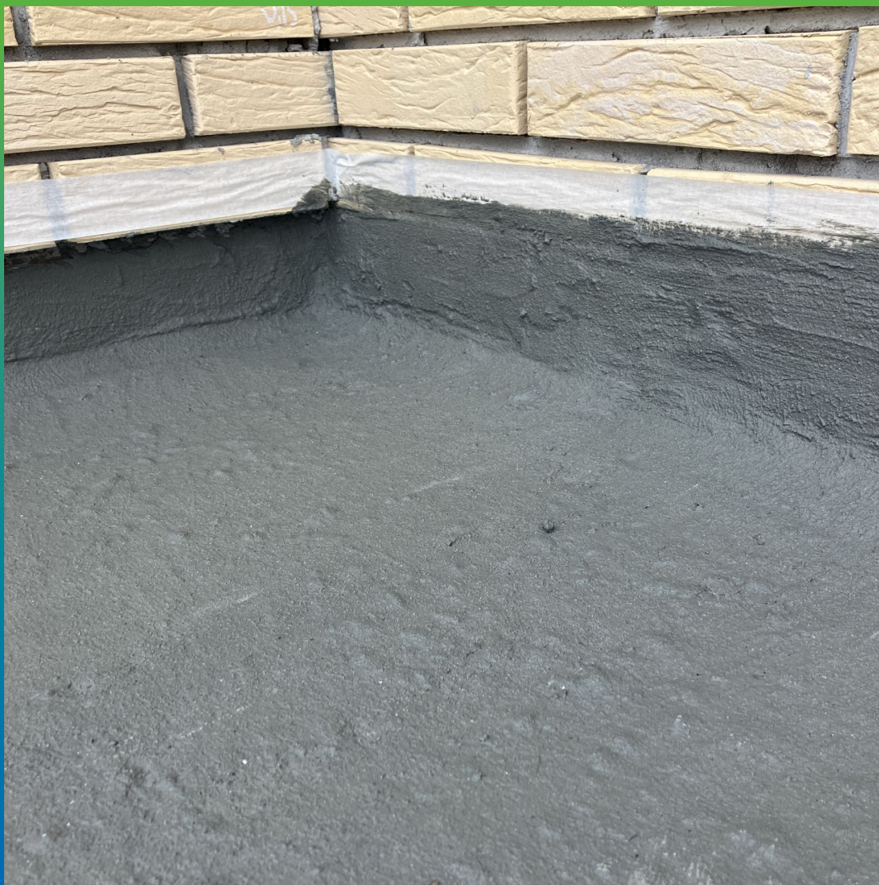
Нанесенный Стармекс Сил Флекс
