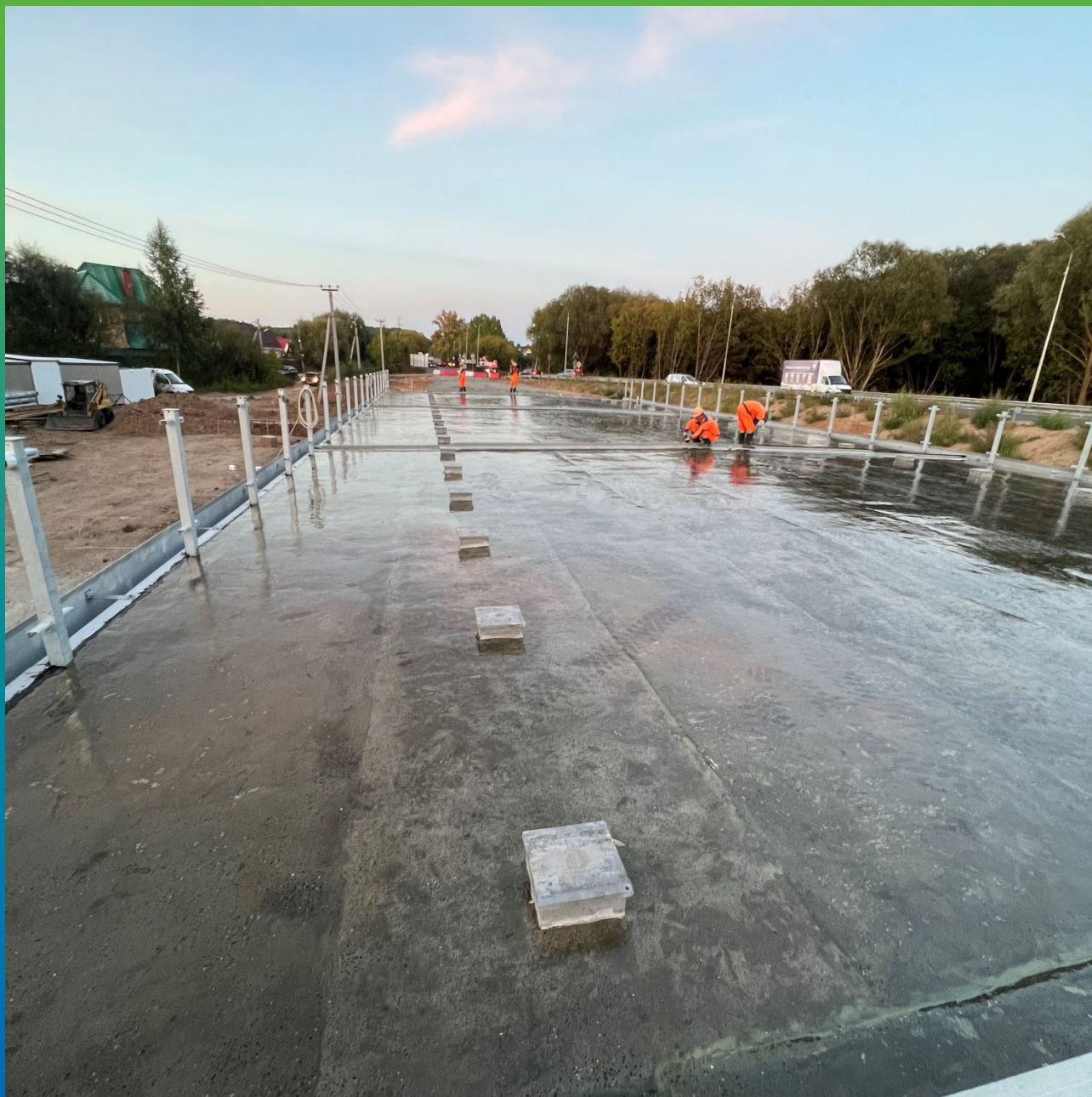
Нанесение 2-го слоя грунтовки Манодил ПУ 90 с общим расходом 0,4 кг/м 2
