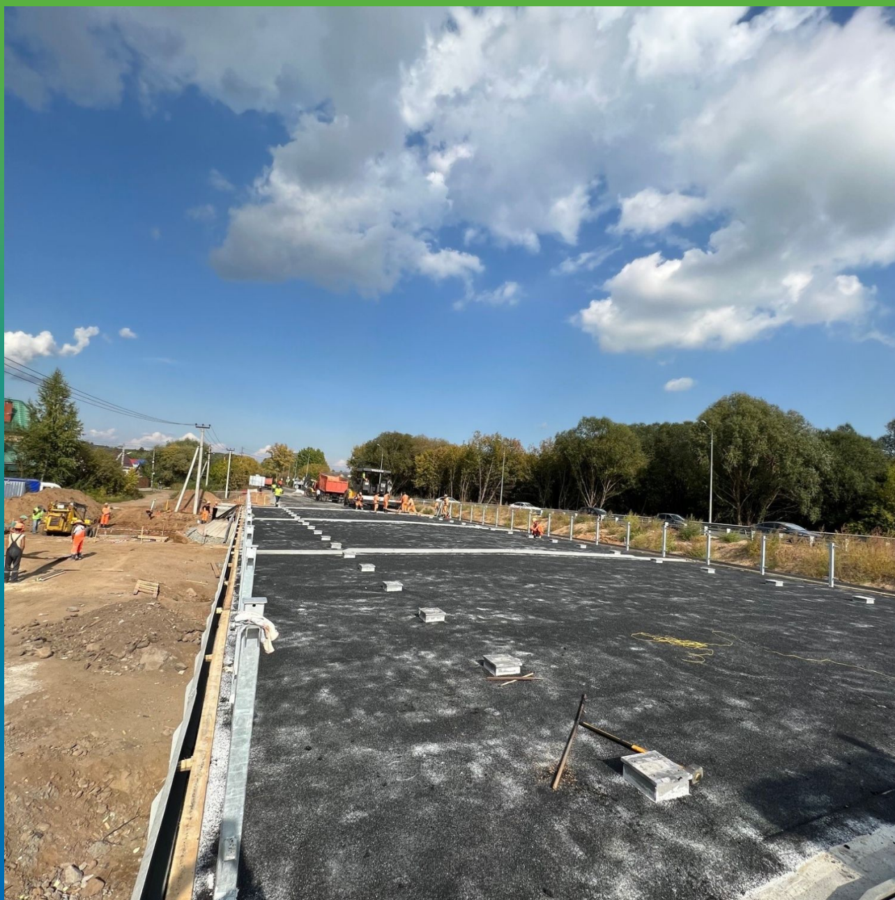
Нанесение третьего слоя гидроизоляции Денстоп ПУ 228 с финишной просыпкой Денстоп Филлер КР
