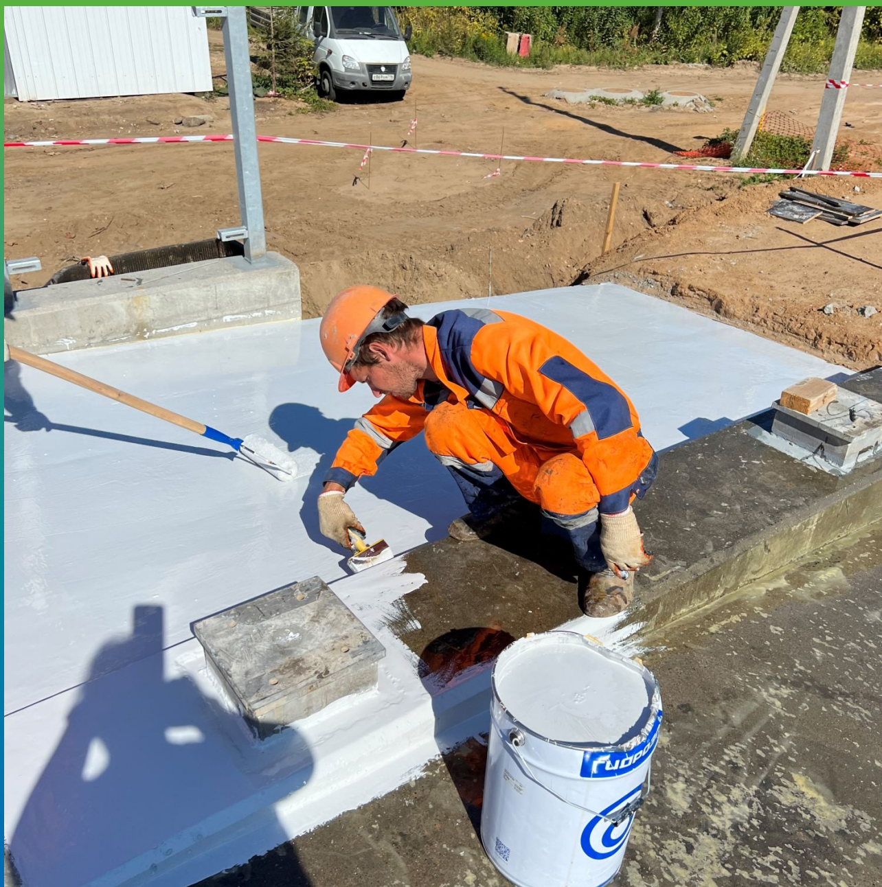
Нанесение первого слоя однокомпонентного гидроизоляционного состава Денстоп ПУ 228 с расходом 1 кг/м 2 на слой
