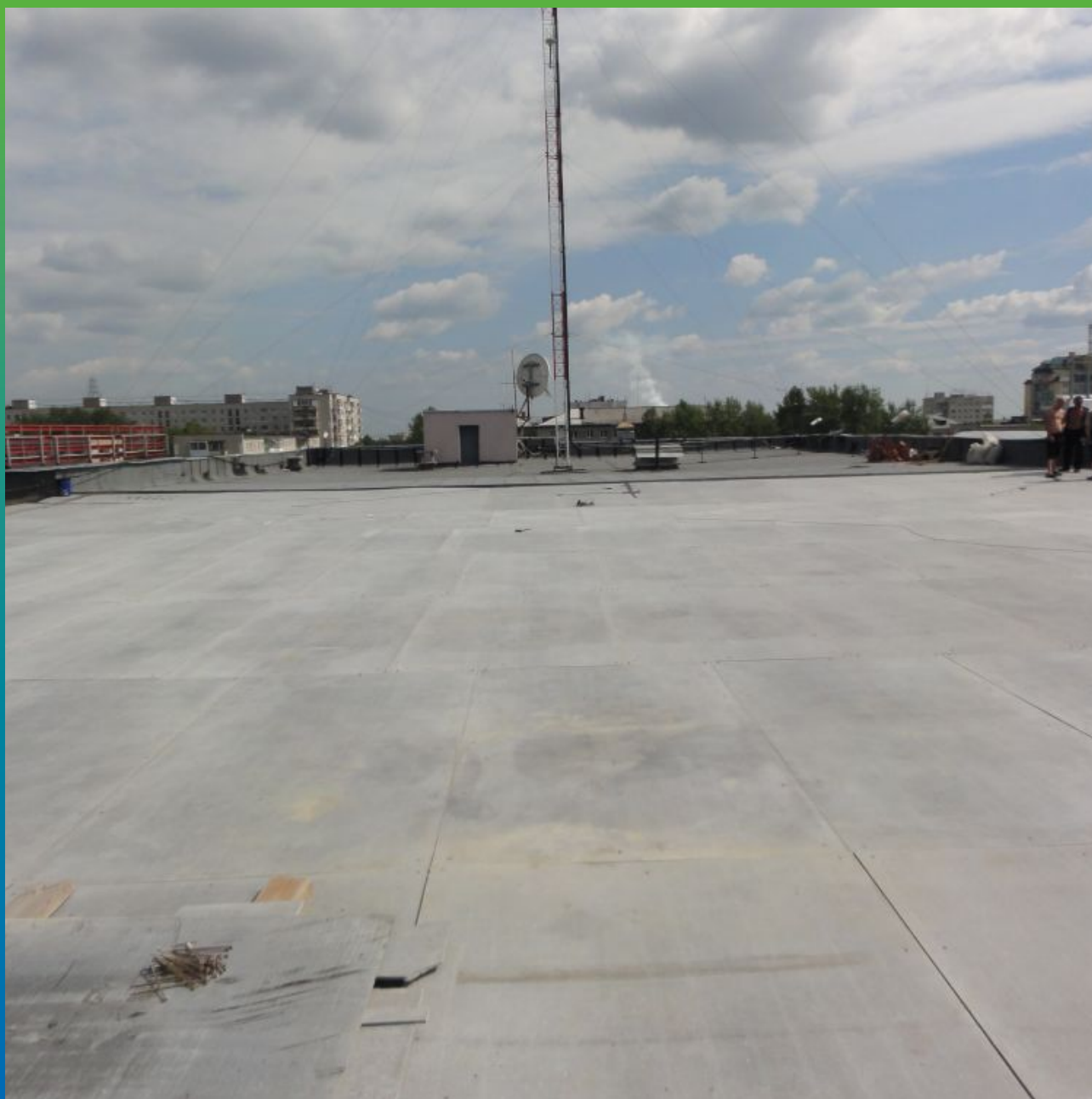
Вид объекта перед укладкой ЭПДМ
