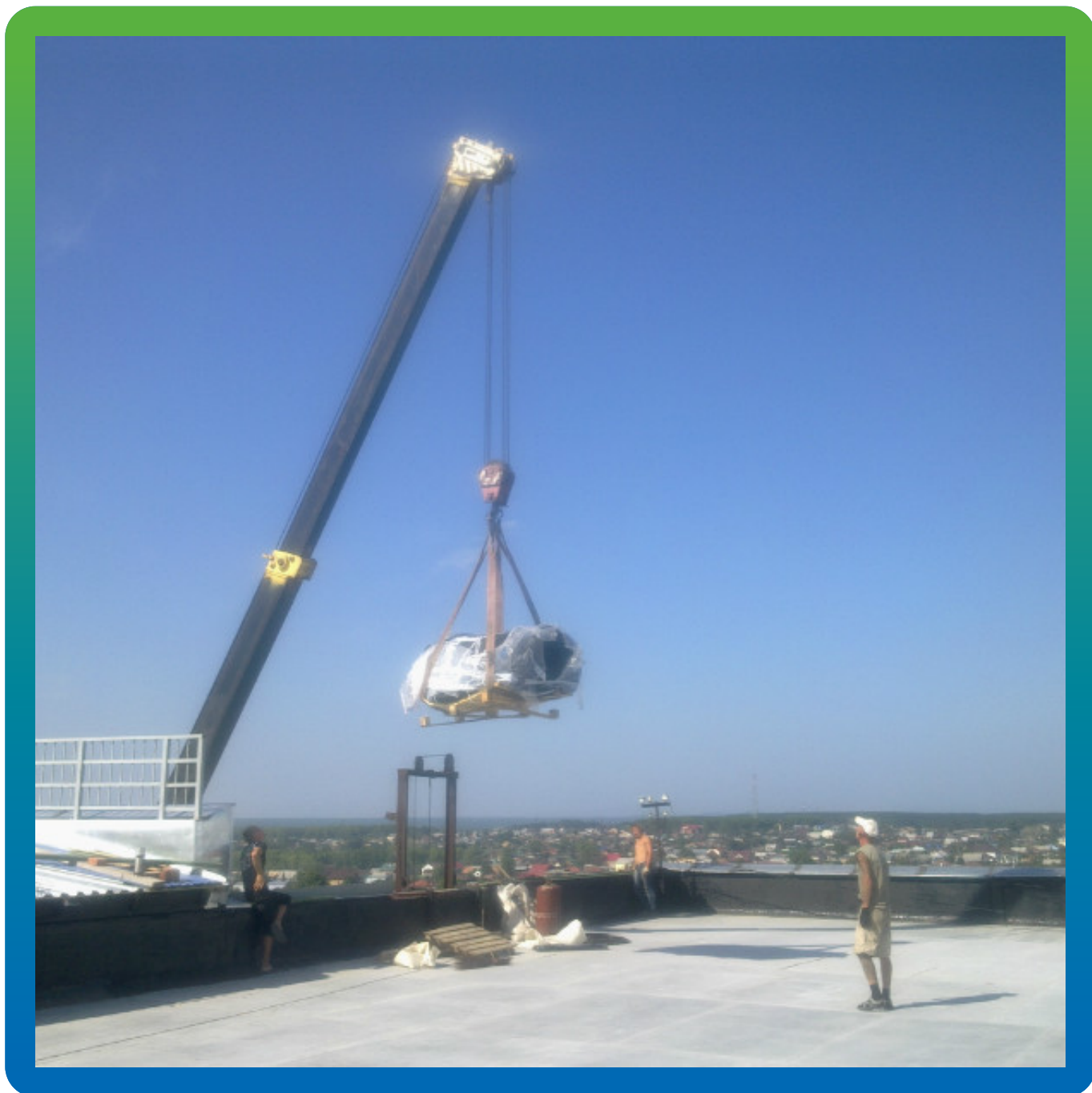
Поднятие ЭПДМ на кровлю
