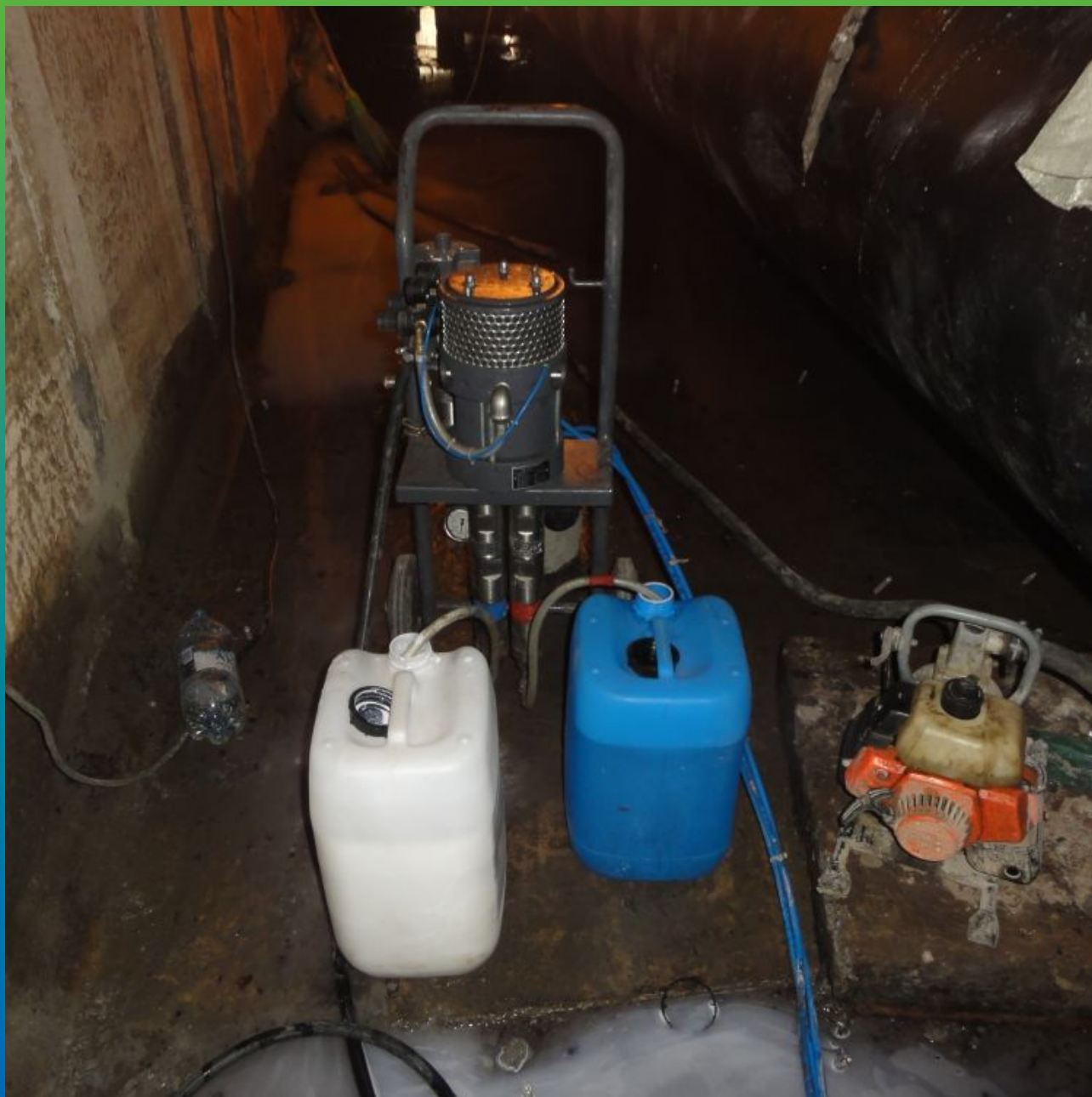
Инъектирование Манокрил Гель В с помощью насоса БМ 1425
