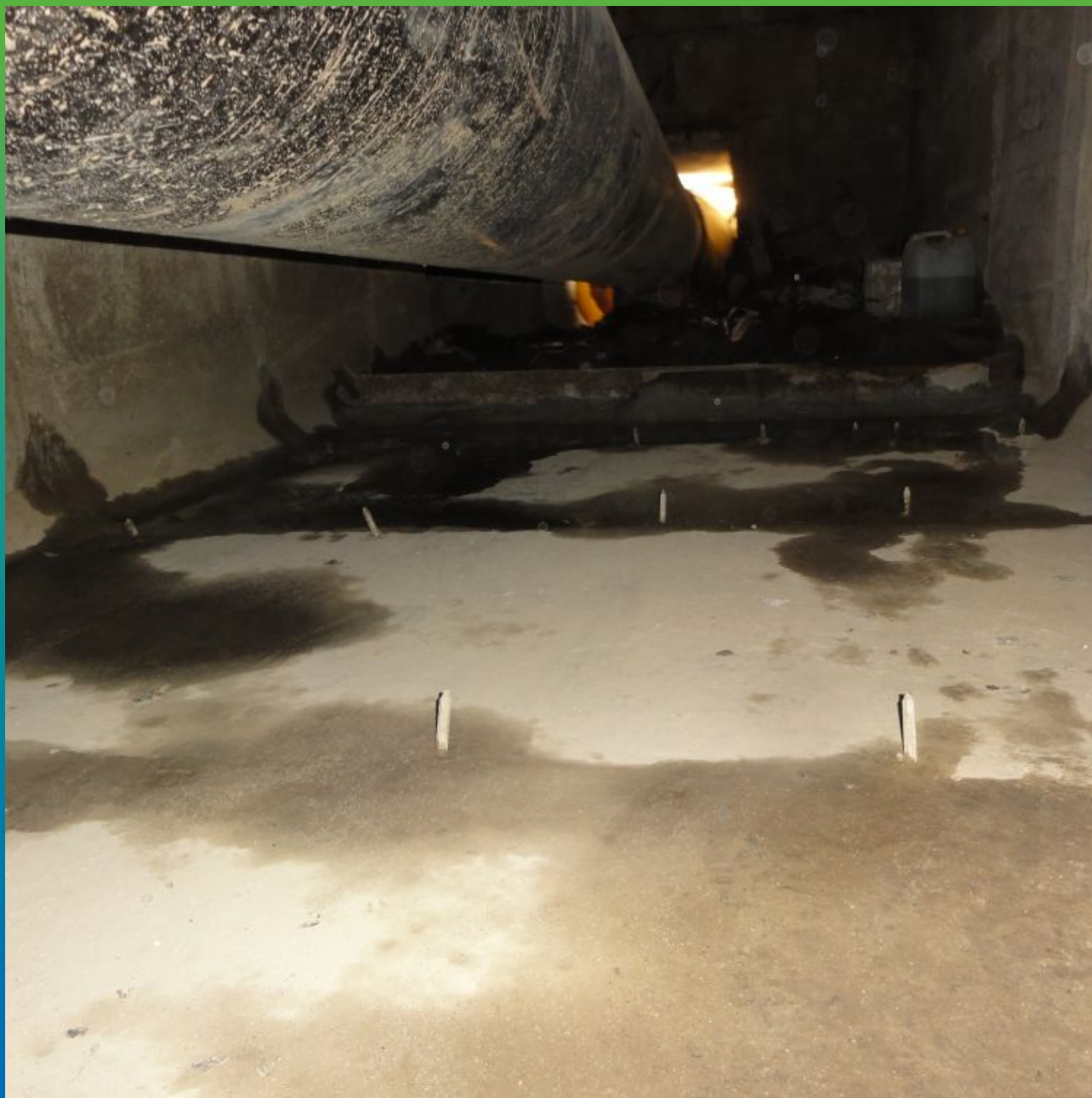
Вид объекта после инъекирования
