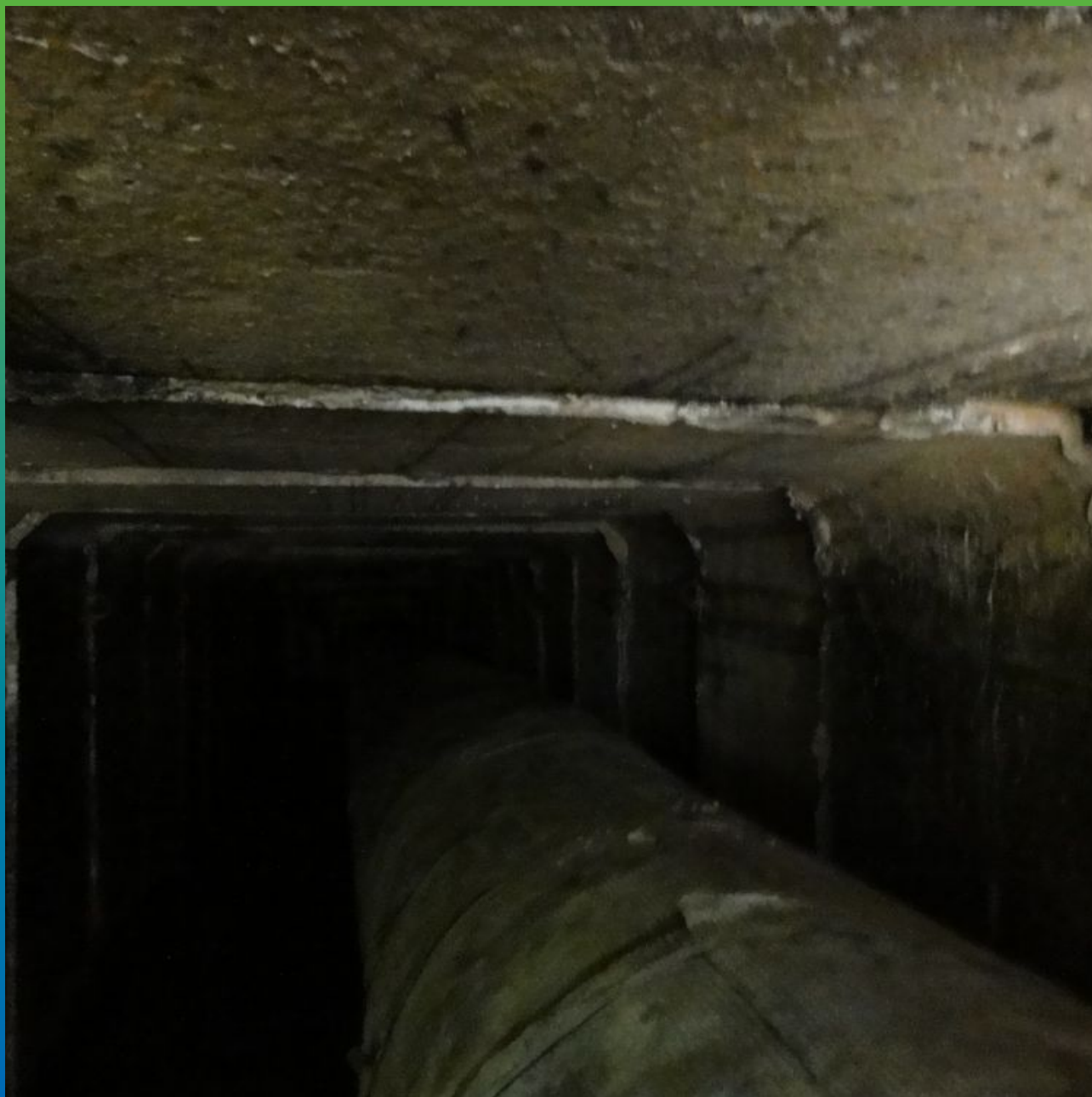
Вид объекта до начала производства работ
