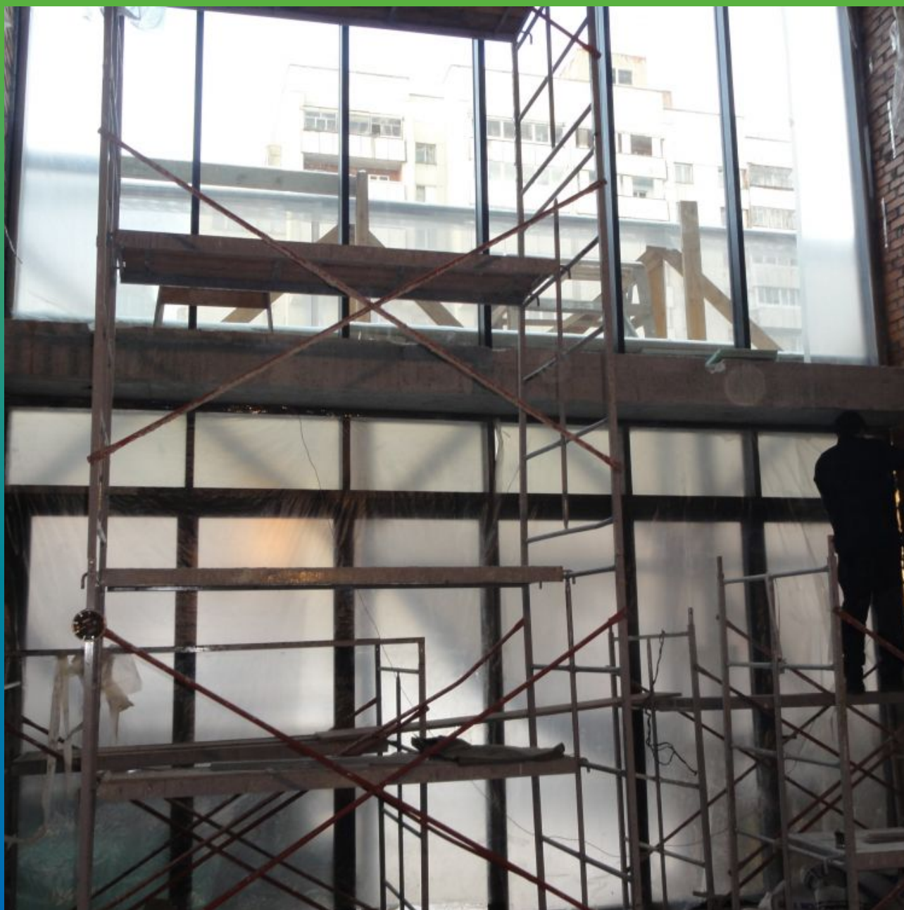
Вид поверхности перед началом работ
