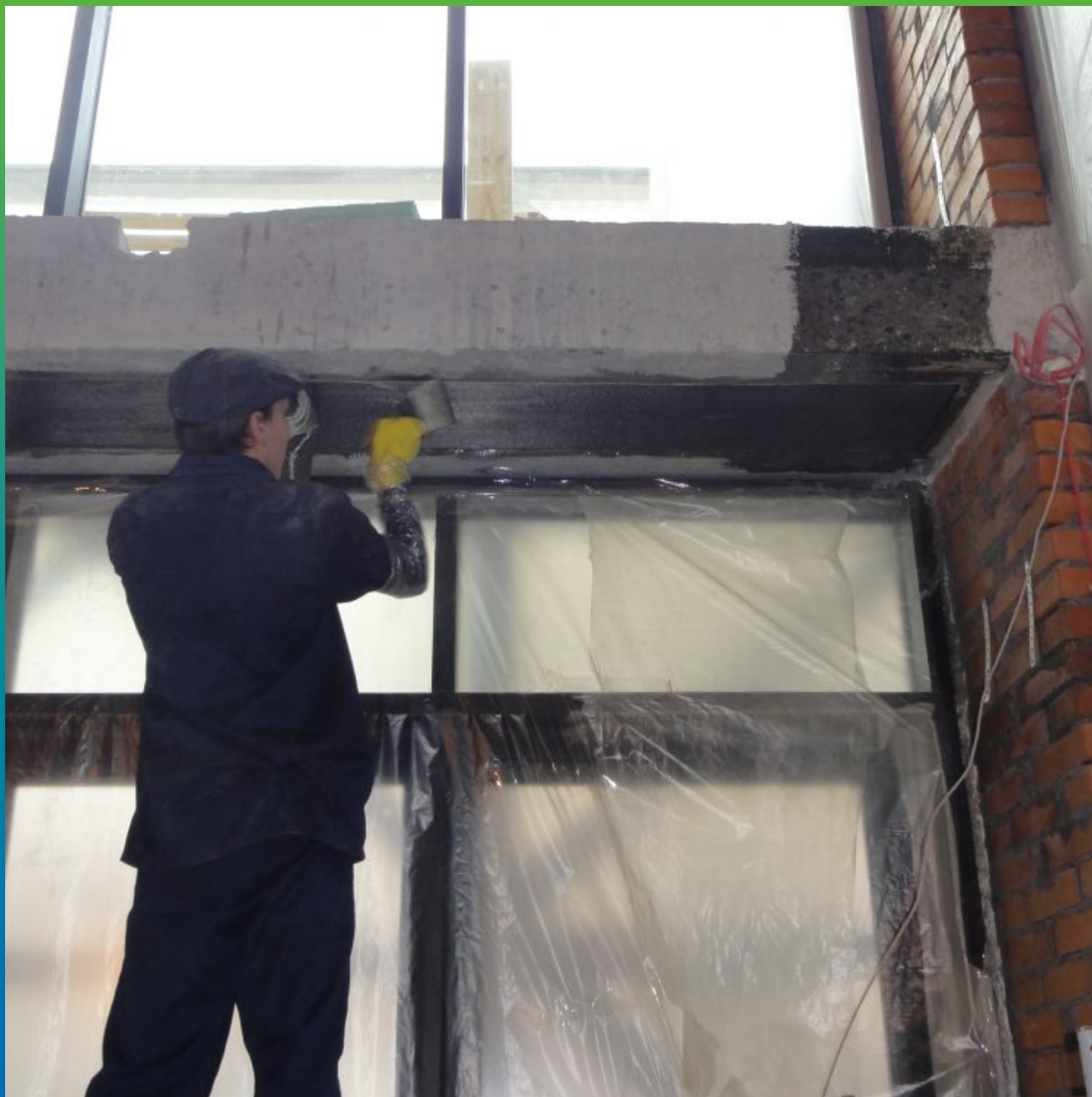
Монтаж второго слоя Тайфо СЦХ 7АП-Н
