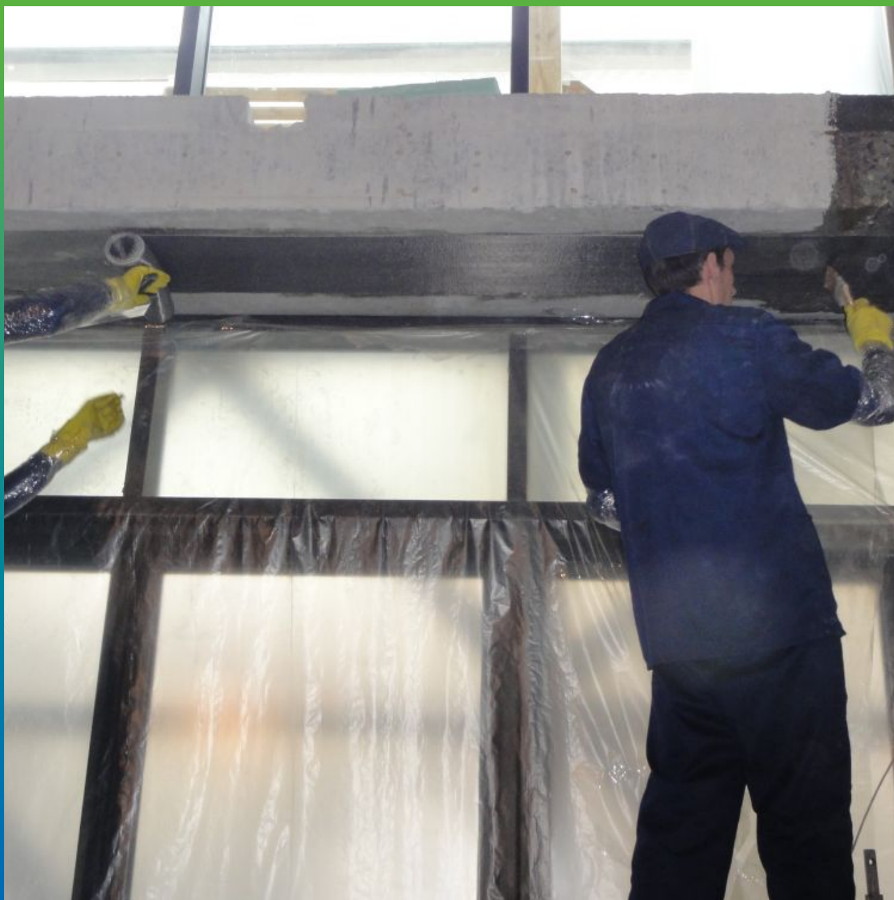
Монтаж первого слоя Тайфо СЦХ 7АП-Н
