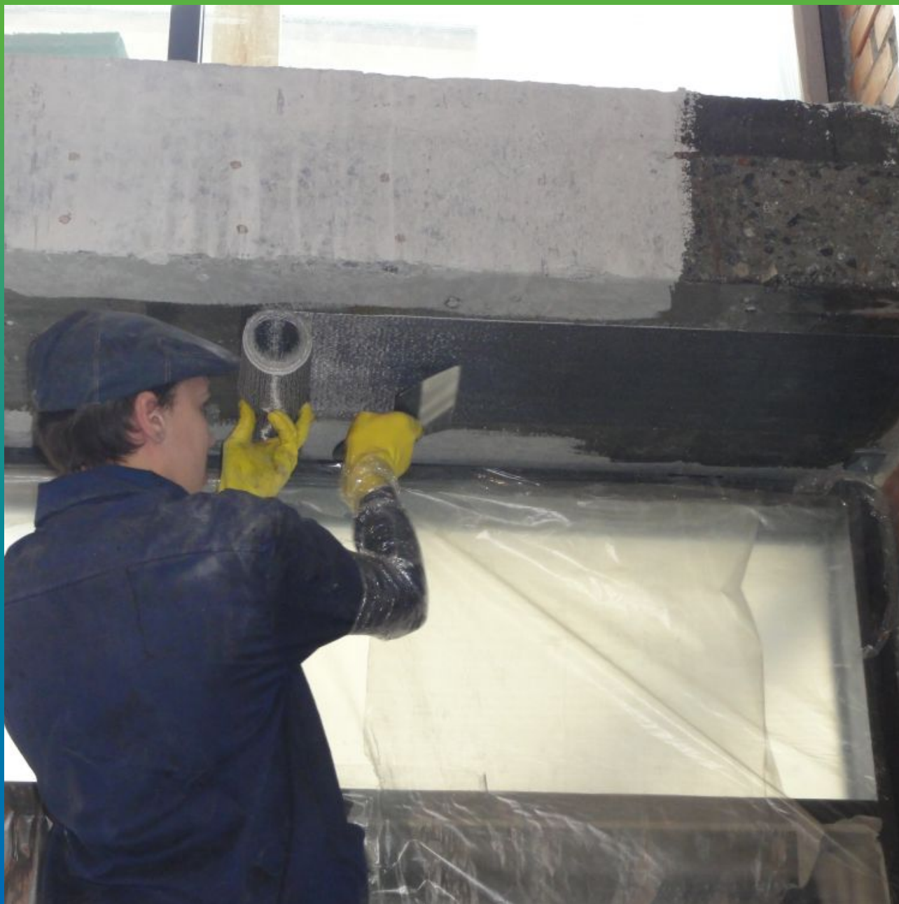
Монтаж первого слоя Тайфо СЦХ 7АП-Н
