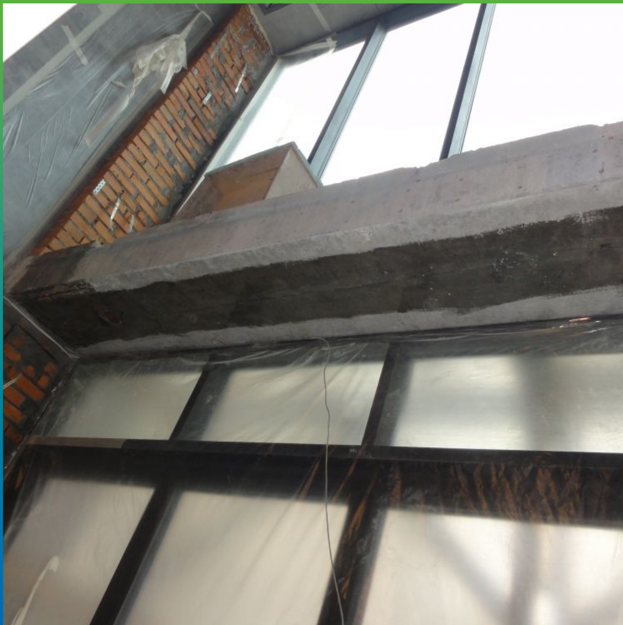
Вид прогрунтованной поверхности
