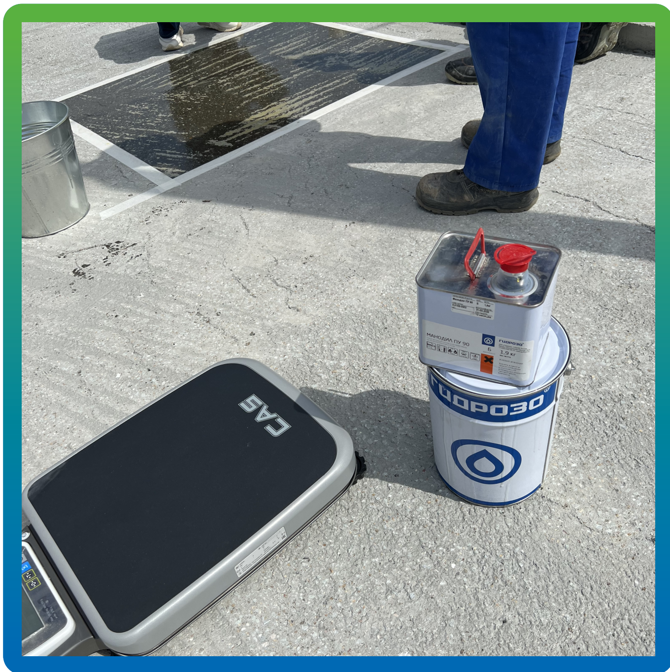
Отработка нанесения системы на пробном участке. Грунтование составом Мандил ПУ 90
