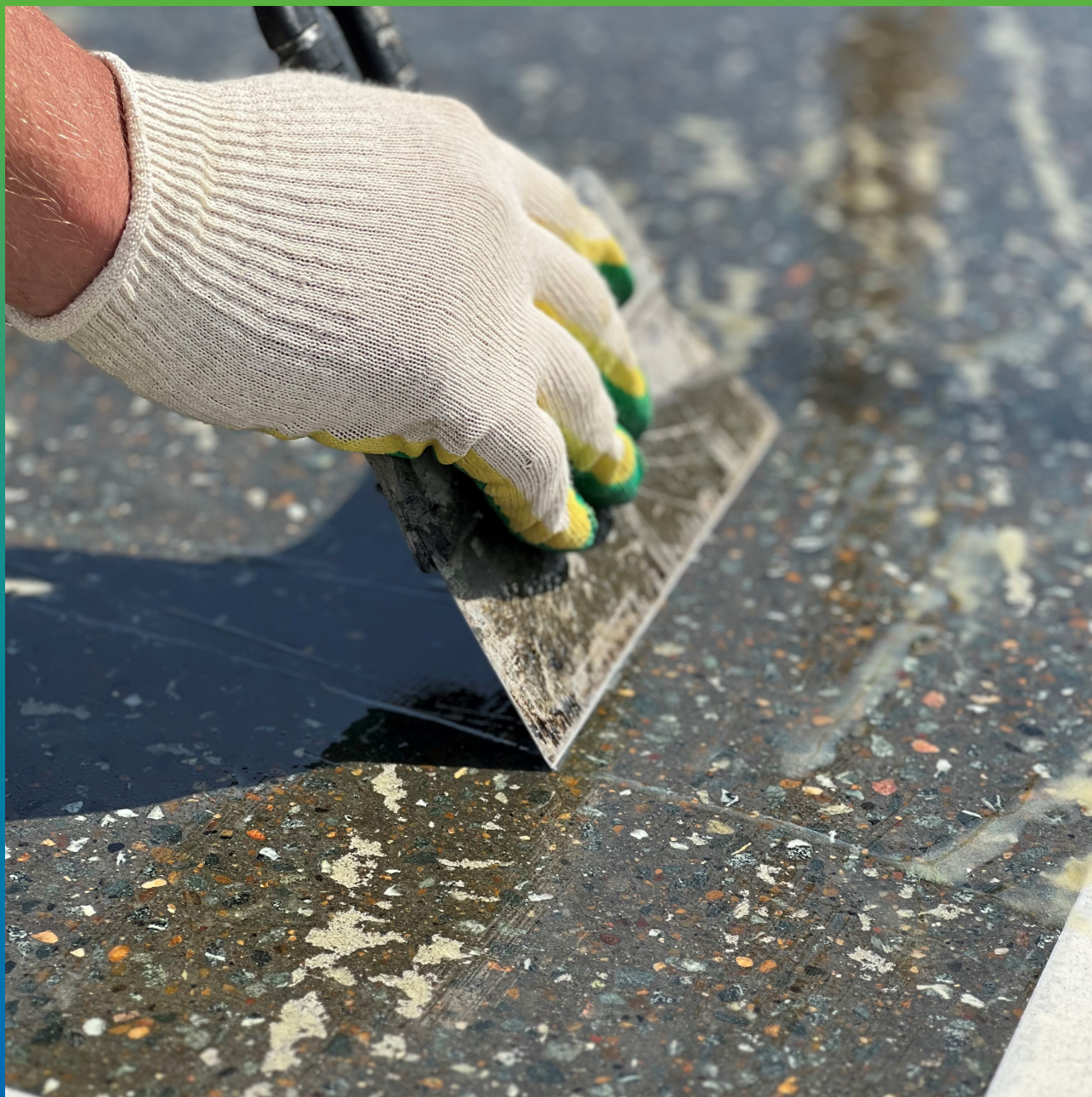
Нанесение грунтовочного состава Манодил ПУ 90
