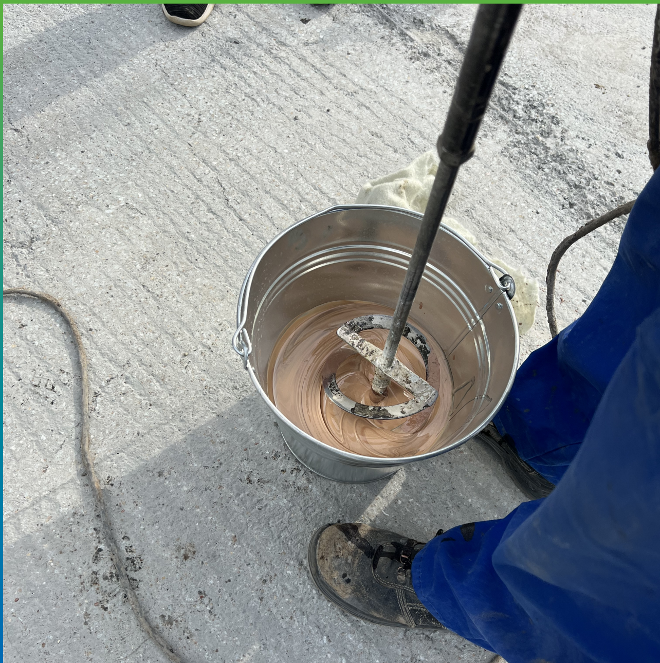
Смешивание гидроизоляционного состава ДенсТоп ПУ 700 Шелл
