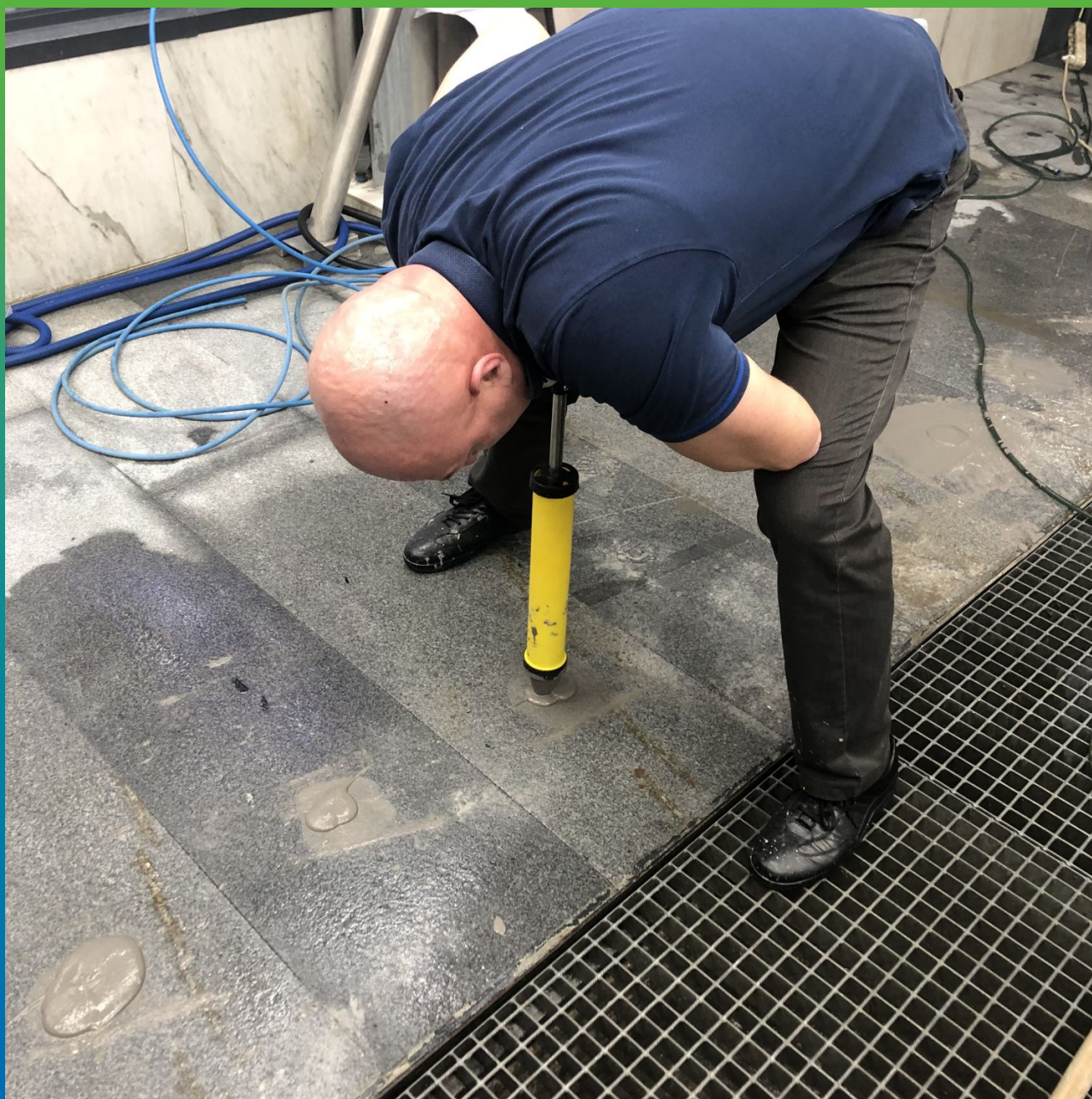
Процесс инъектирования
