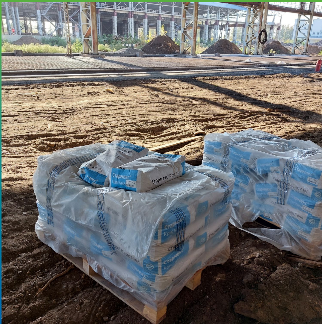
Материалы Гидрозо на объекте
