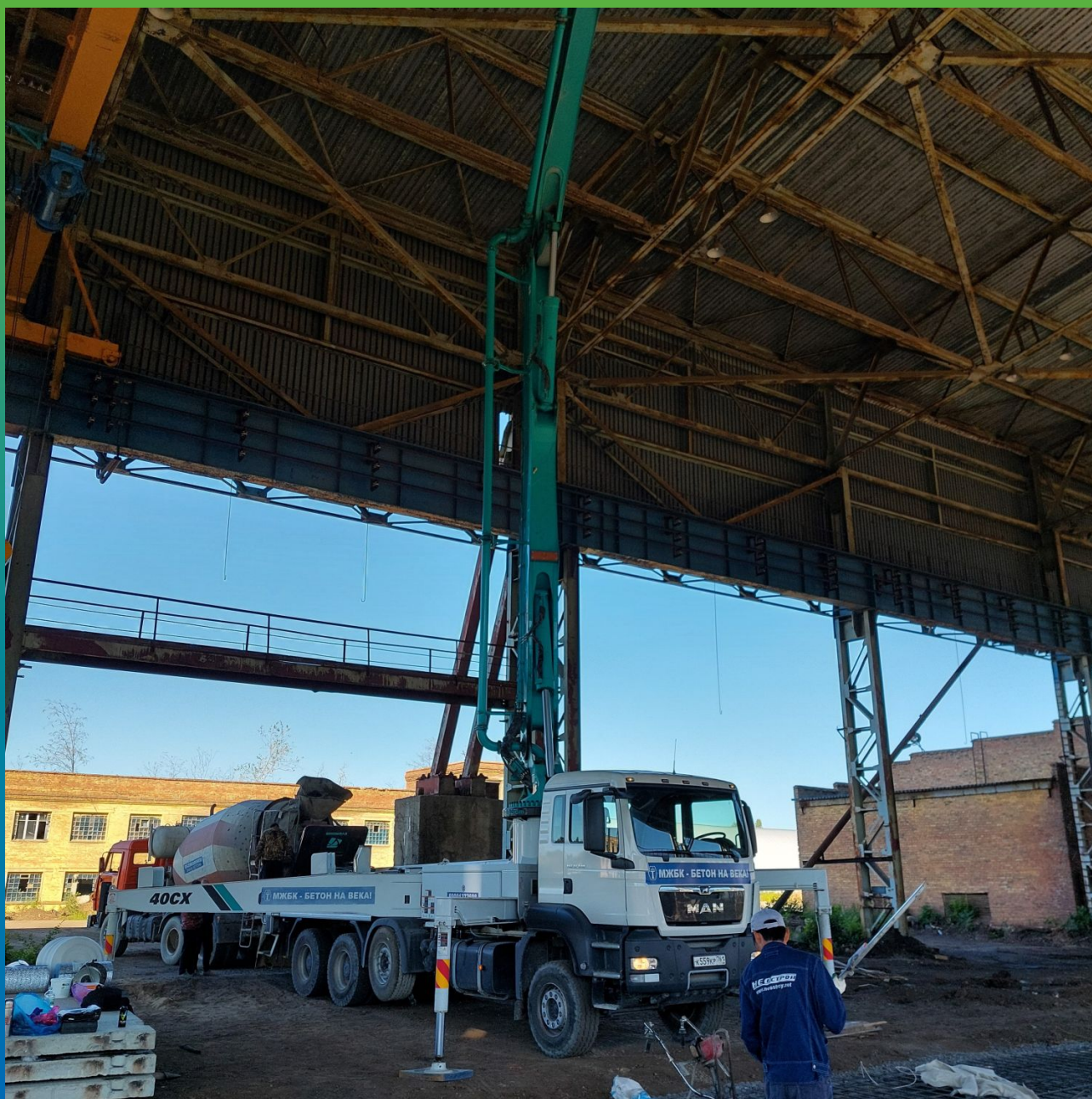
Подготовка бетононасоса
