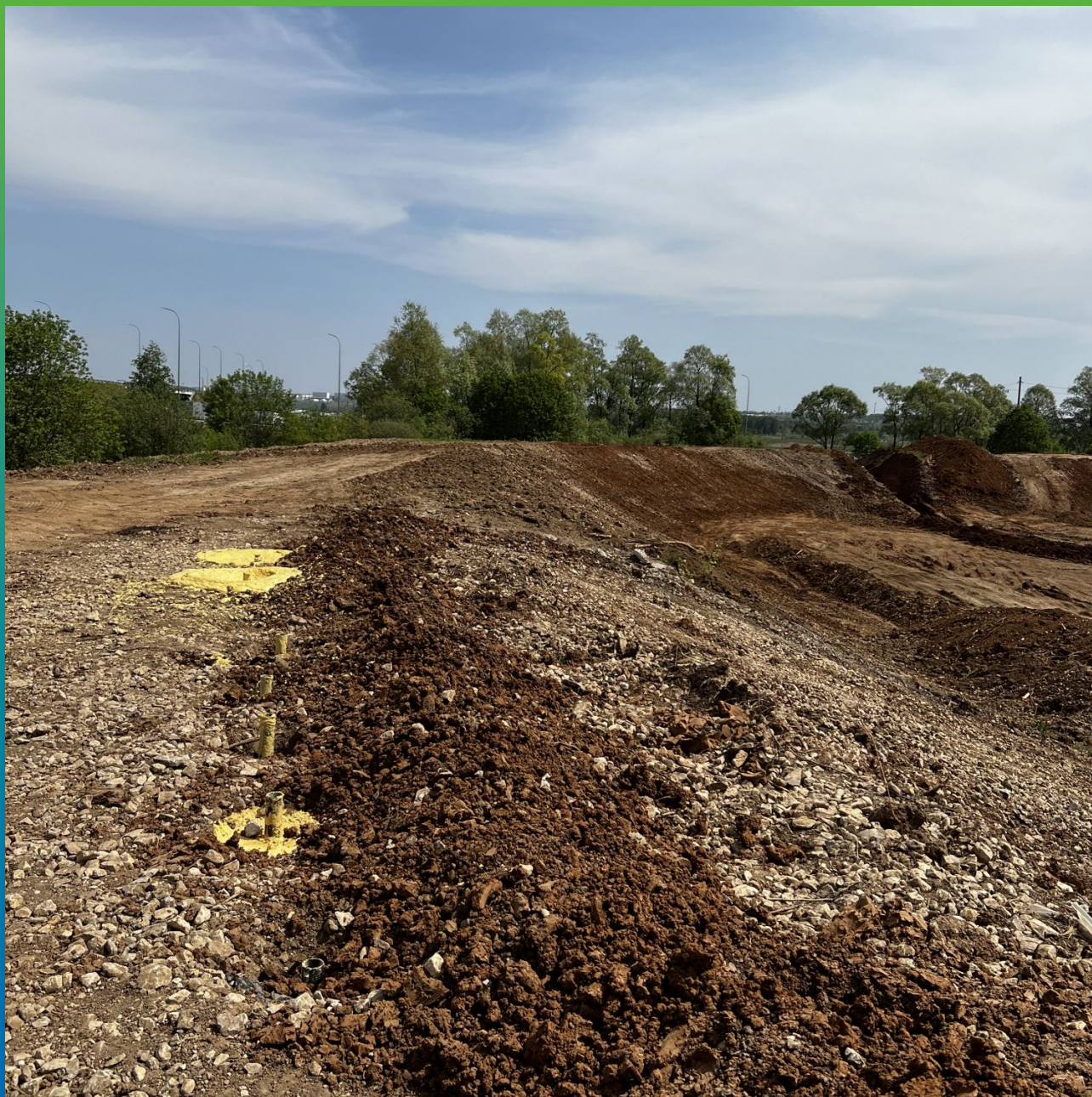
Скважины, заполненные составом Манопур 127
