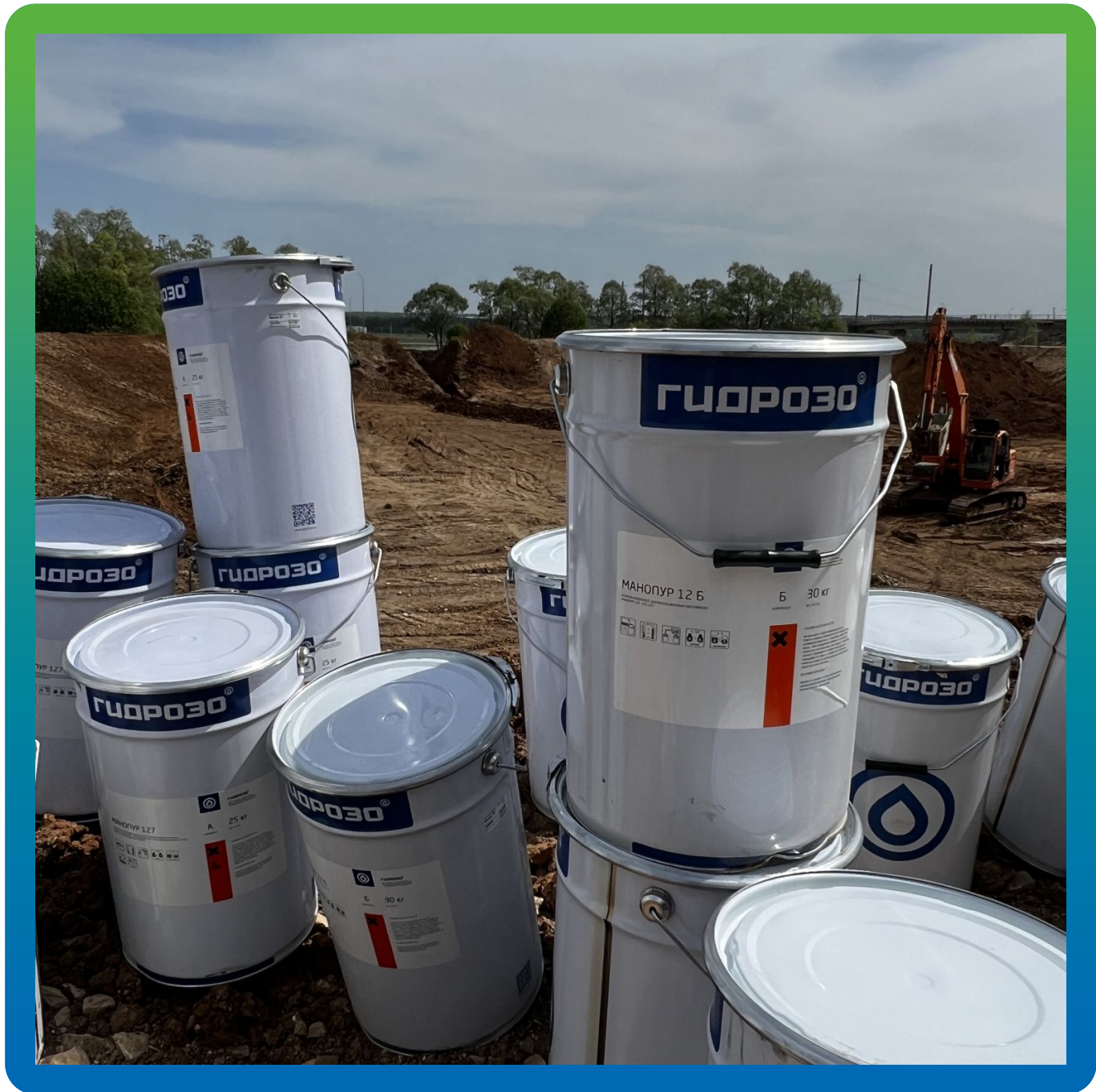
Манопур 127 на объекте. Выбор состава был обусловлен высокой обводненностью грунта
