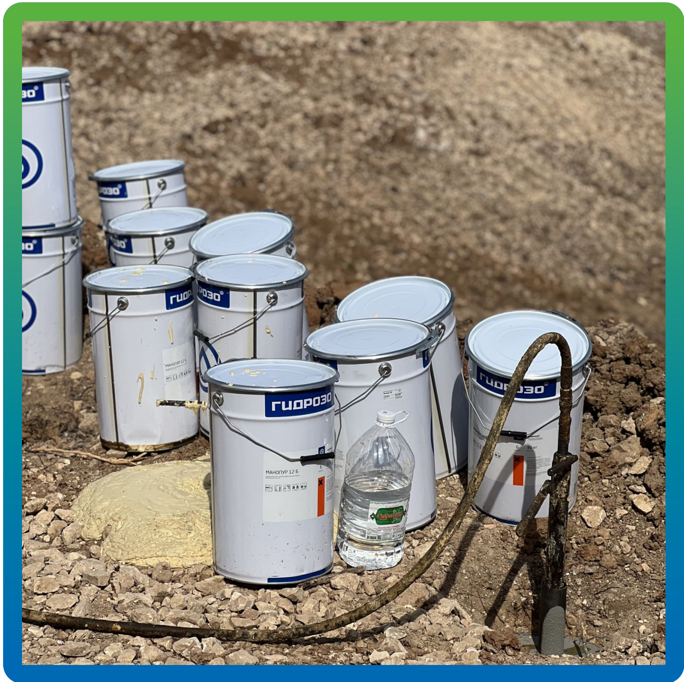
Проведение работ по консолидации грунта
