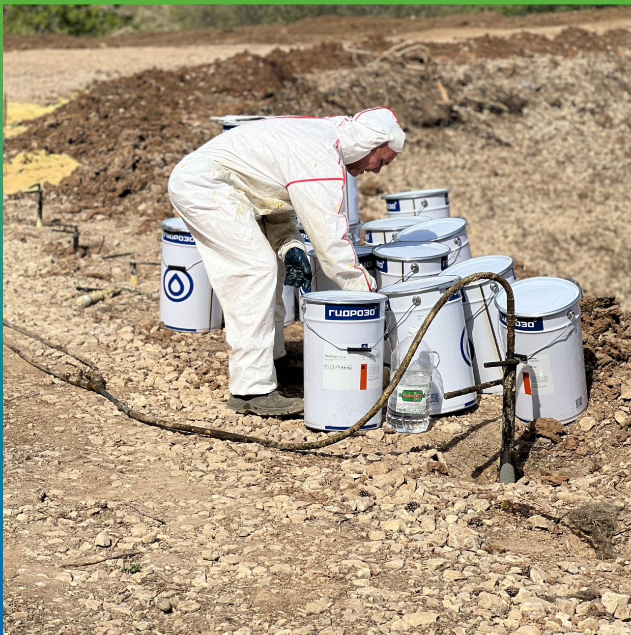
Проведение работ по консолидации
