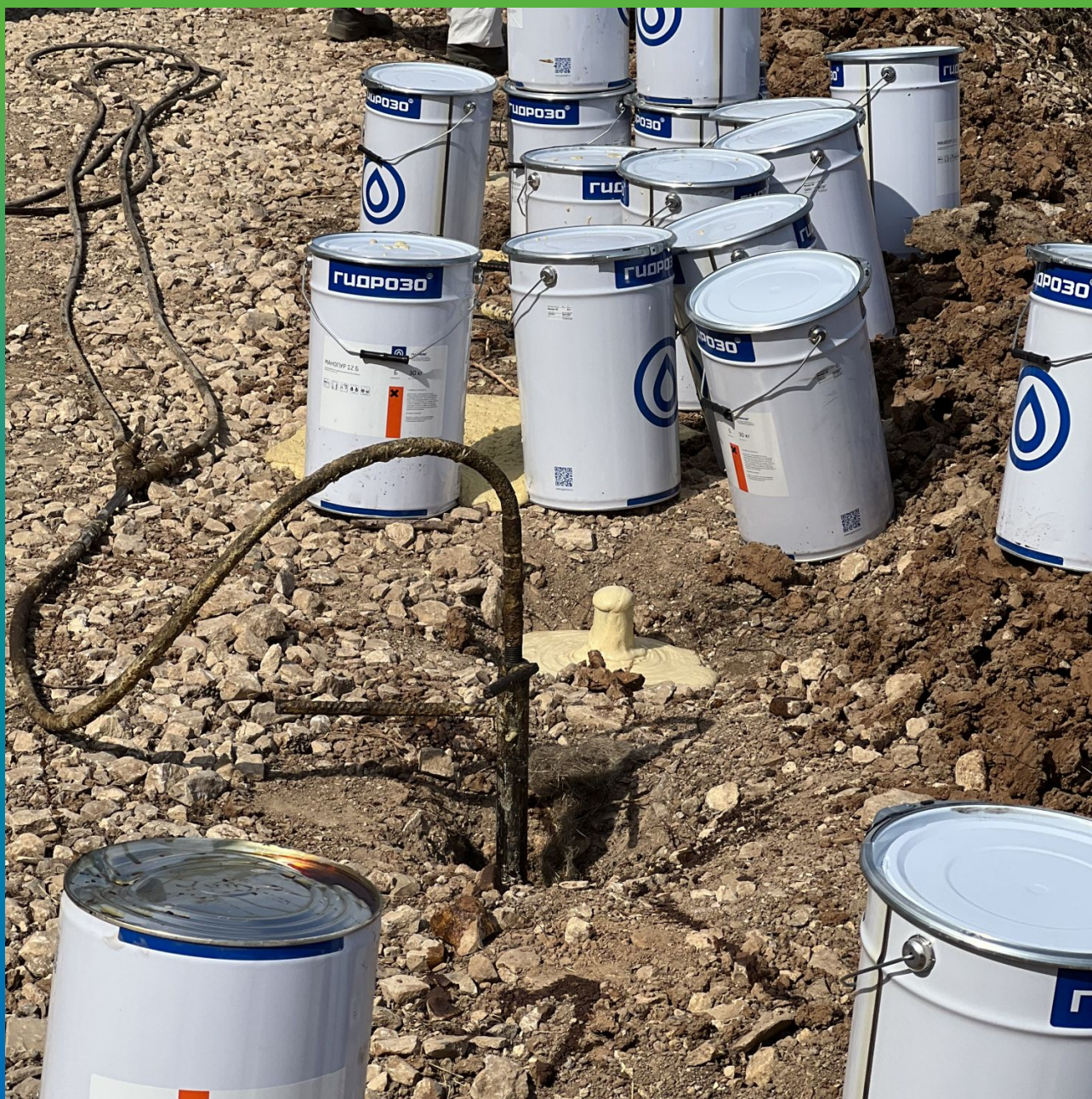
Проведение работ по консолидации грунта
