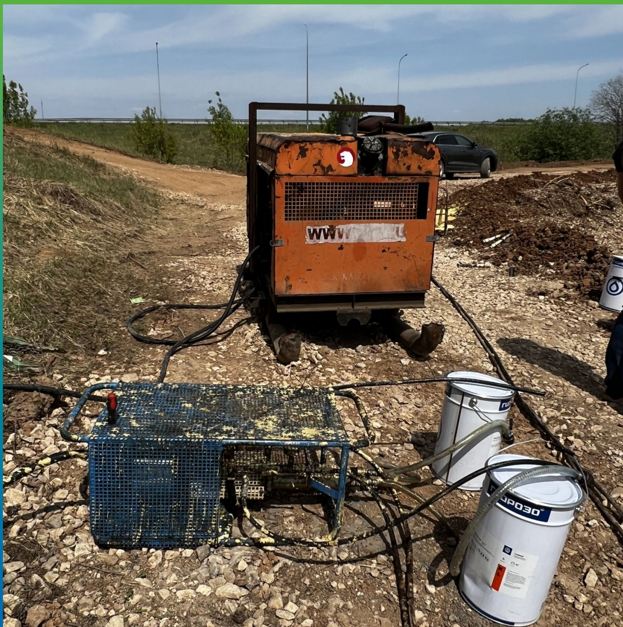
Подготовка насоса БМ 1429, который используется для подачи 2К смол
