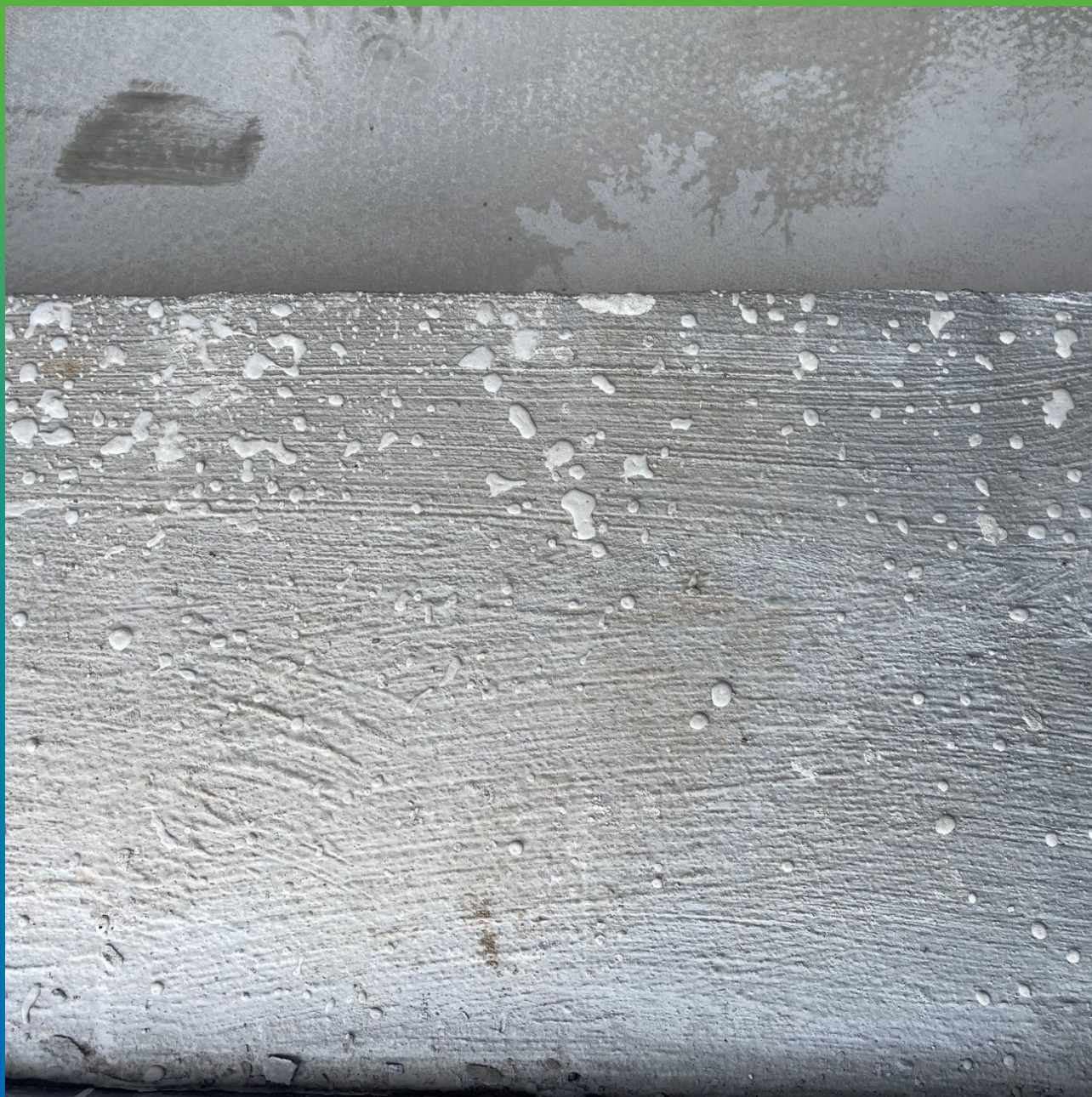
Нанесенный Стармекс Кристалл на плиту основания
