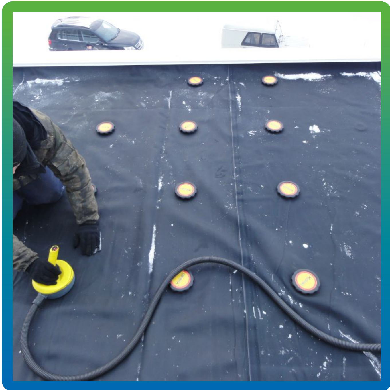
Процесс механического крепления ЭПДМ мембраны без прокола по системе Центрикс
