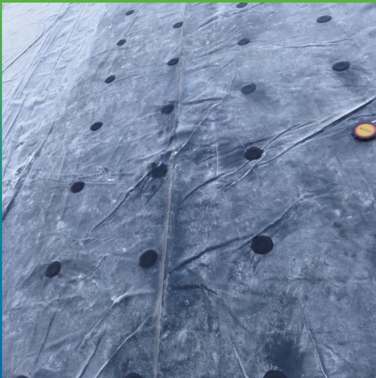
Свежее крепление ЭПДМ мембраны по системе Центрикс
